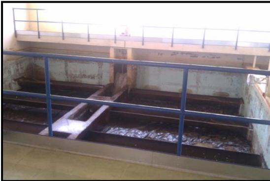
Imagen 17. Vaciado del filtro de arena
