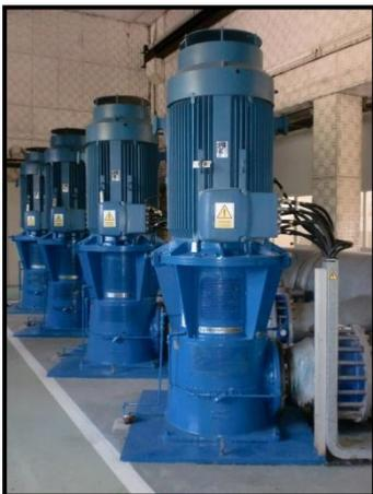
Imagen 14. Señalización de peligro de riesgo eléctrico en los grupos moto-bomba del bombeo a Contindas
