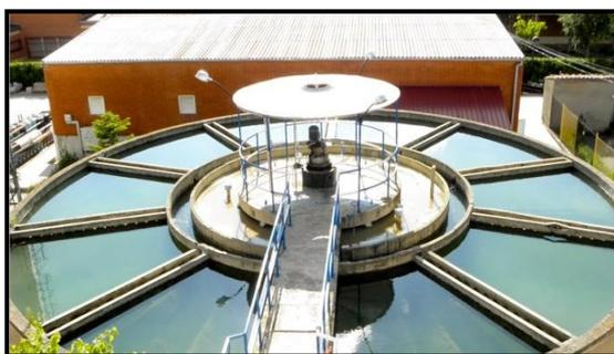
Imagen 6. Decantador acelerador estático de la ETAP Las Eras
