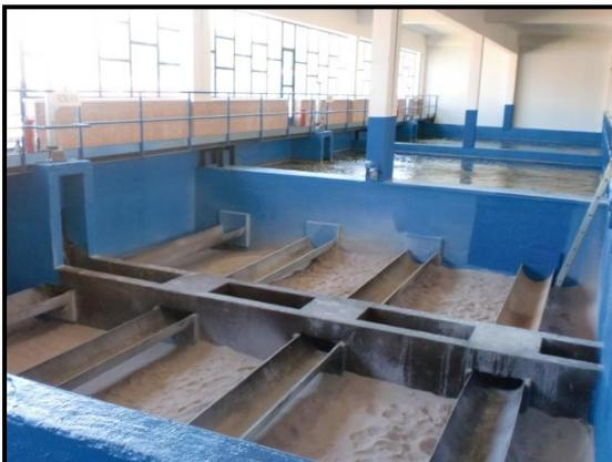
Imagen 19. Filtro de arena pintado y con arena completamente nueva.
