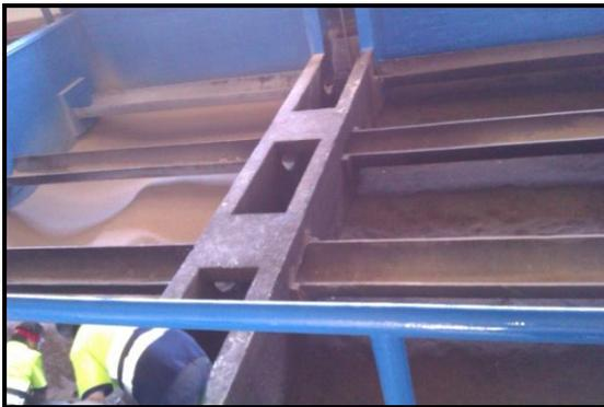
Imagen 18. Llenado del filtro con arena nueva. Obsérvese la diferencia entre la arena nueva (izqd.) y arena vieja (dcha.)
