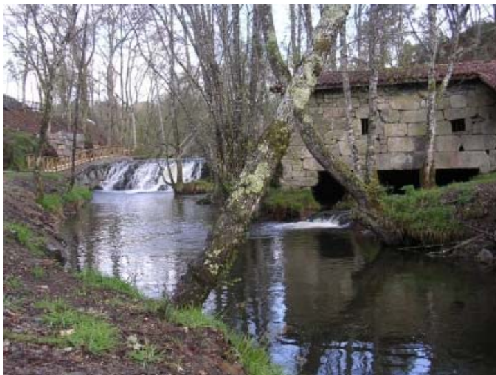
Imagen 3: Paseo fluvial Río Maceda Fuente: Ayuntamiento de Maceda
