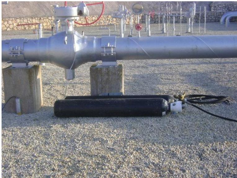
Fotografía 6. Botellas de Nitrógeno.
