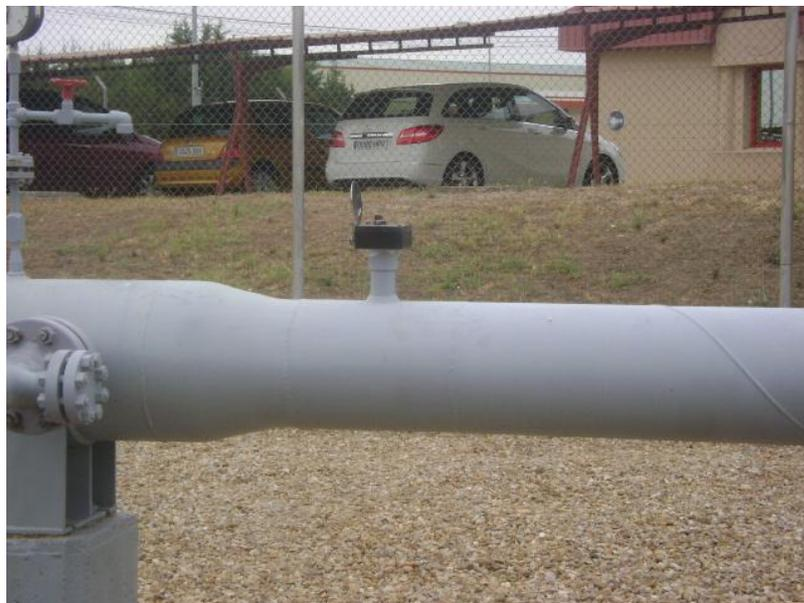
Fotografía 4. Señalizador paso PIG trampa.
