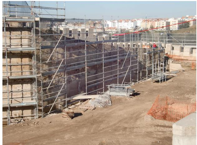
**CONDICIONES:** Se ha realizado el montaje del andamio en esta zona, que sirve como protección colectiva y como plataforma de trabajo segura. Este montaje ha sido realizado por una empresa especializada.
