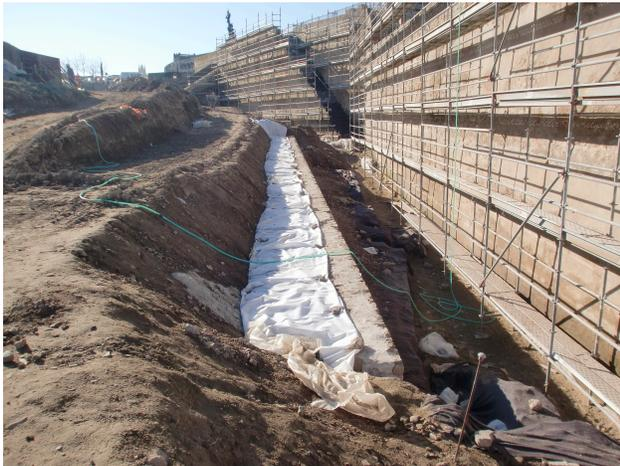
**CONDICIONES:** Se ha realizado un muro de mampostería que sirve como contención de los taludes de tierra que se han realizado, de esta manera se evita posibles movimientos de tierra debido a sobrecargas o lluvias.
