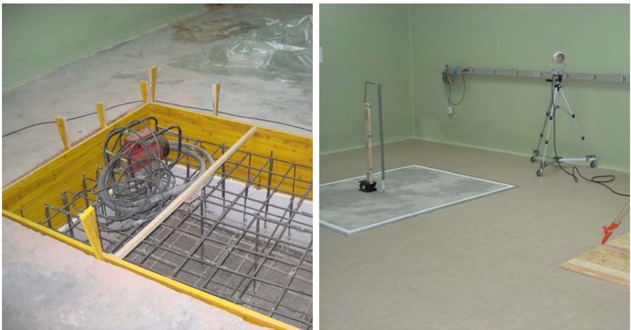
Figura (3, 5) a y b). Cimentación independiente en el lugar de instalación de la columna.
