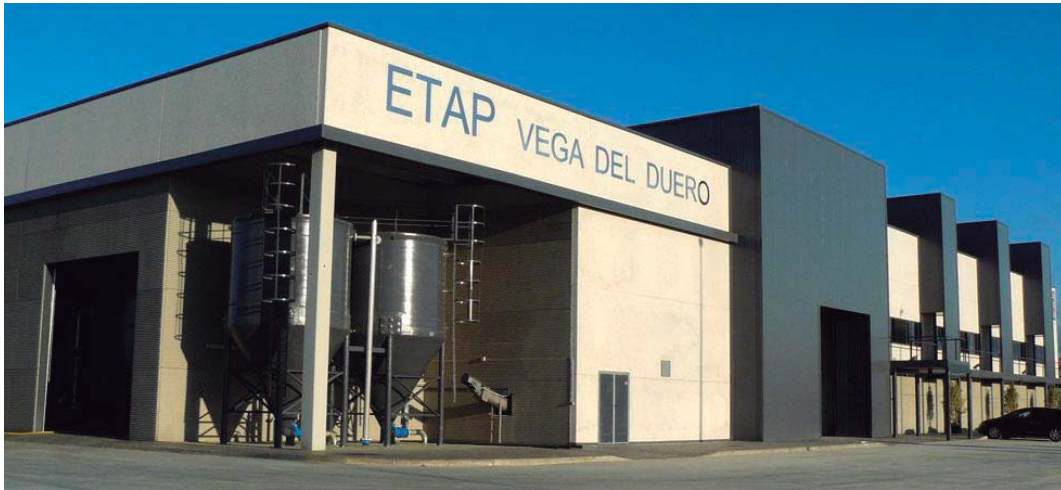
Figura 43. Edificio para el abastecimiento de agua potable ETAP “Vega del Duero” (Fuente: Diputación de Valladolid www.diputaciondevalladolid.es )
