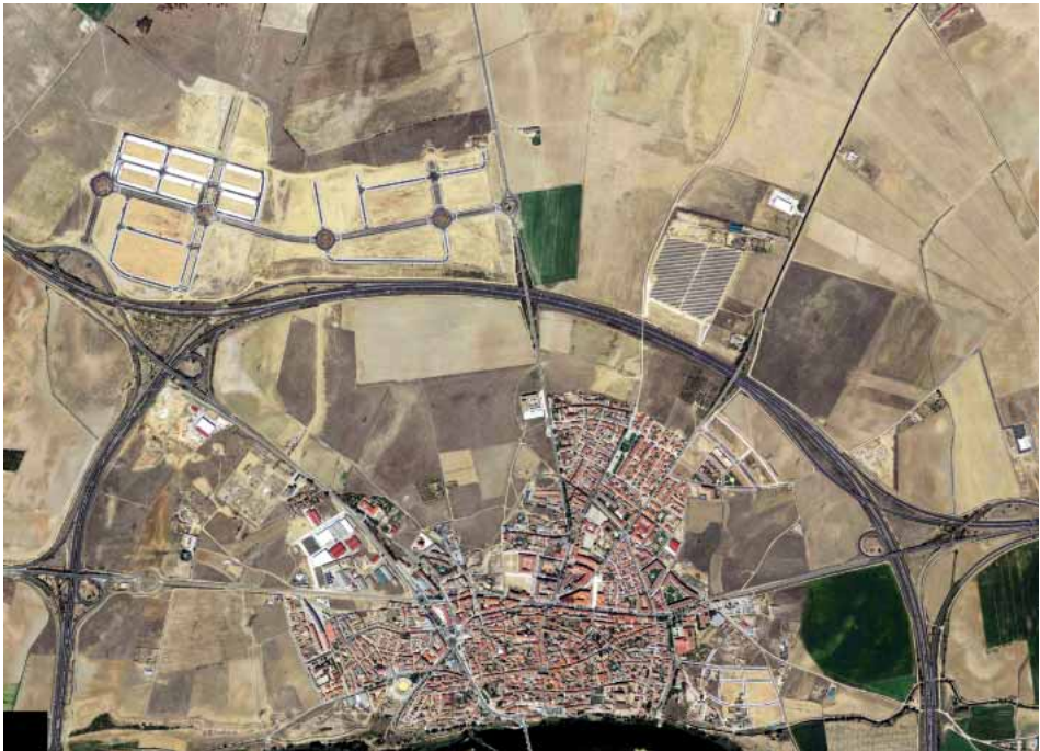
Figura 6.30 Parque industrial y Logístico de Tordesillas en 2009. Una localización excepcional en dos grandes itinerarios europeos: E-80 (A-6, autovía del noroeste) y E-82 (A-62, autovía de Castilla)
