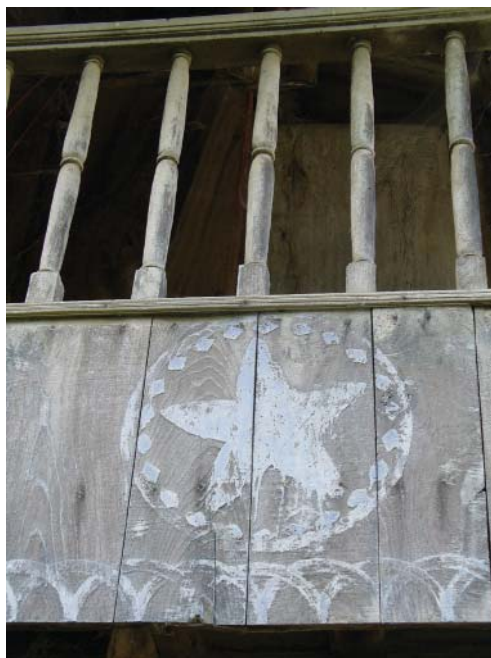
Fig. 19. Panera de Casa Jerónimo (Casa Palmira), Riocastello. Exterior del corredor. Rueda solar con estrella.
