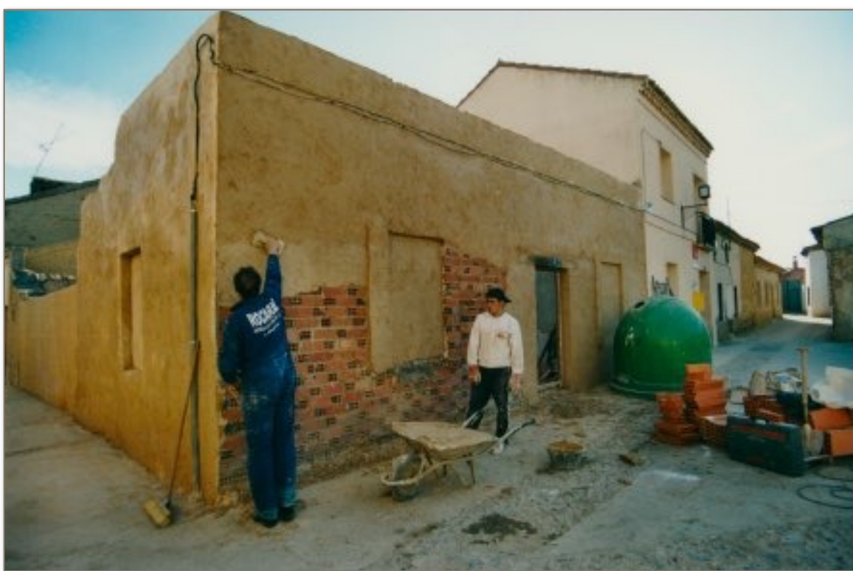
Fig. 3.15. Proyecto Urueña (2000-2001). Reportaje visual II . Revoco de fachada con tapial.
