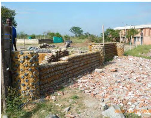
Figura 2. Muro de tierra y botellas PET. Puede observarse el sistema combinado de muros y pilares ejecutados con el mismo sistema. Kajunga Uganda. 2010. Foto Eco-tec.
