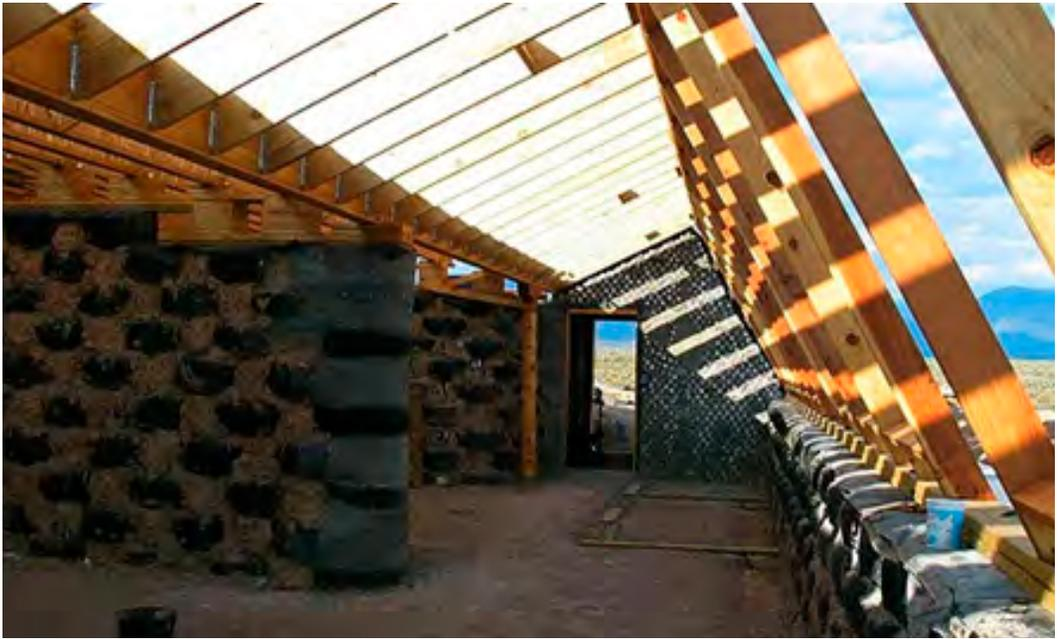
Figura 6. Prototipo de vivienda Earthship. Se puede apreciar el sistema de ejecución del muro y de los elementos de remate finales realizados con mezcla de cemento. Foto Mike Reynolds.
