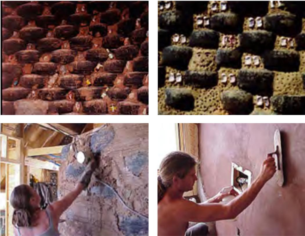
Figura 7. Prototipo de vivienda Earthship. Proceso de construcción del muro y revocado final con barro. Foto Mike Reynolds.
