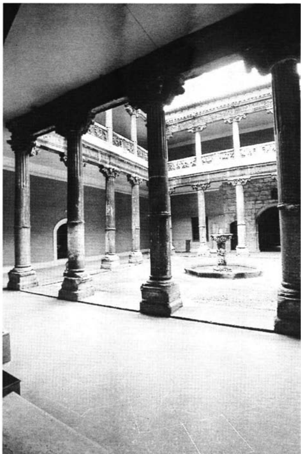
Lámina 1. Burgos. Casa Miranda. Patio.
