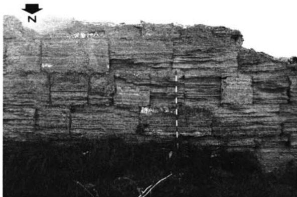
Lámina II, 1. Detalle del aparejo de sillares, opus quadrarum , de la muralla Norte del Durón del Belmonte en su sector occidental. Obsérvese la disposición de las hiladas alternando bloques a sogá y tizón. Vista desde el foso septentrional (fotos del autor).
