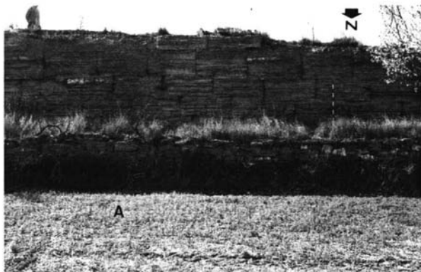
Lámina III, 1. Detalle de un tramo del sector central de la muralla Norte del Durón de Belmonte, con un aparejo al soga algo diferente a los observados en las ilustraciones anteriores. Vista desde el foso septentrional, señalado con la letra A.
