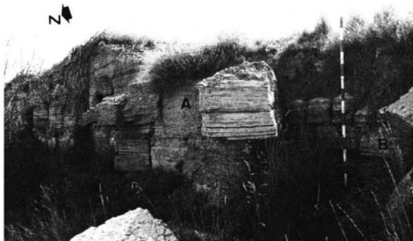
Lámina III, 2. Detalle de uno de los tramos del sector central de la muralla Norte del Durón de Belmonte en el que algunos sillares del paramento externo de quadratum , señalado con la letra A, han caído y dejan ver el murete interno de sillarejo, señalado con la letra B.
