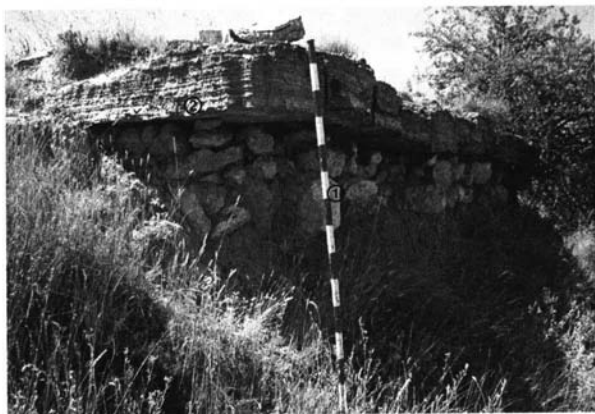
Lámina V, 1. Fotografía de agosto de 1993 en la que se aprecia la cimentación de la muralla del Durón de Belmonte, a base de un lecho de caementa sobre el que se coloca la primera hilada se sillares.
