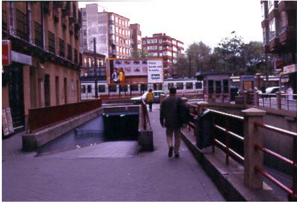
La ciudad dividida por un tren. Paso subterráneo de la calle Labradores en el antiguo “Portillo de la Merced”
