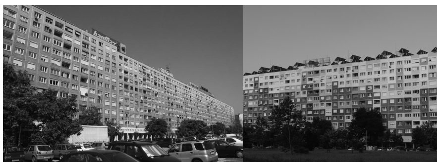
Figs. 10 y 11. El llamado "Pueblo-casa" (Faluház) en Óbuda (Budapest, Distrito III). El edificio residencial más grande de Hungría, que abarca 886 viviendas, antes y después de la renovación. Fuentes: http://epiteszforum.hu/node/13547 (Fig. 10) y foto del autor (Fig. 11)
