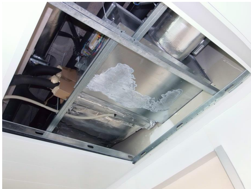
Figura 40. Intercambiador agua-aire de la instalación.
