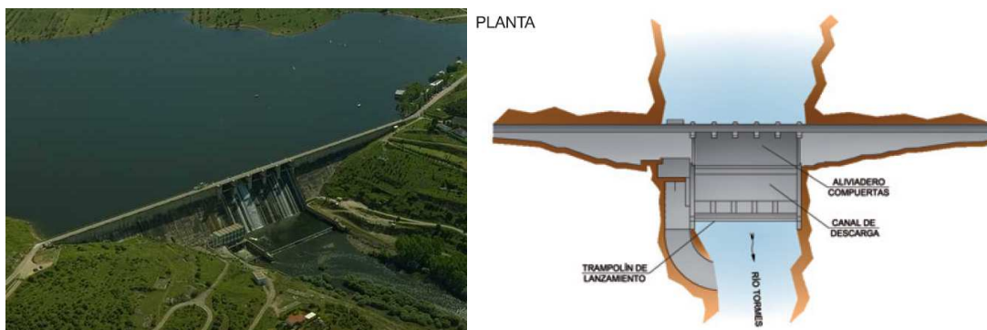
Figura 3.20. Vista aérea (izquierda) y planta (derecha) de la presa de Santa Teresa (CHD, 2014b)
