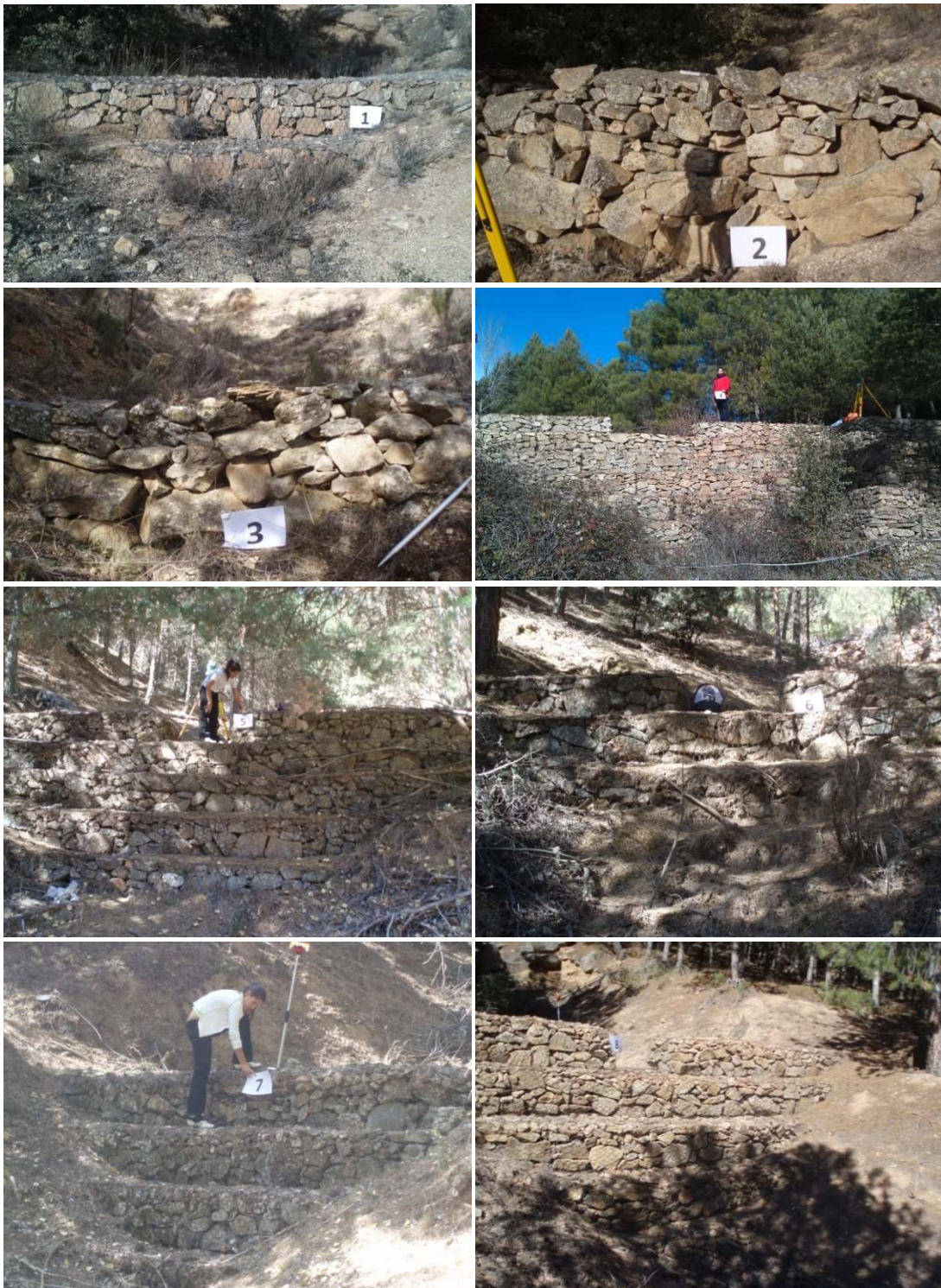
Figura A1.4. Fotos de los diques 1 a 8
