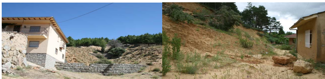
Figura 4. Izquierda: Construcción empotrada en un dique de gaviones en Tórtoles (Ávila). Derecha: Vivienda construida al pie de una cárcava en Saldaña (Palencia).
