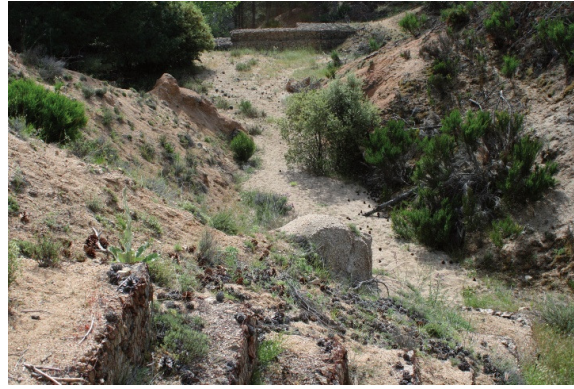
Figura 11. Cuña de sedimentos del dique 2.
