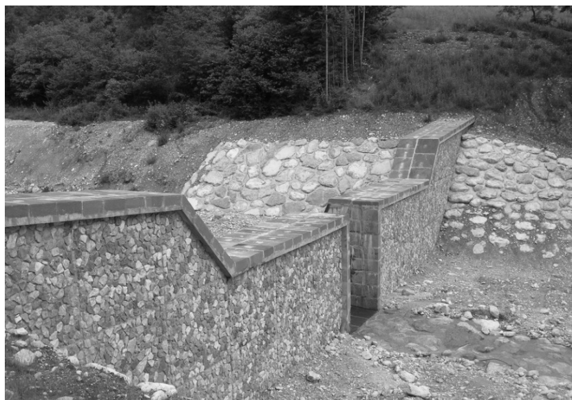
Figura 1.11. Dique abierto en el río Forchia (Italia)
