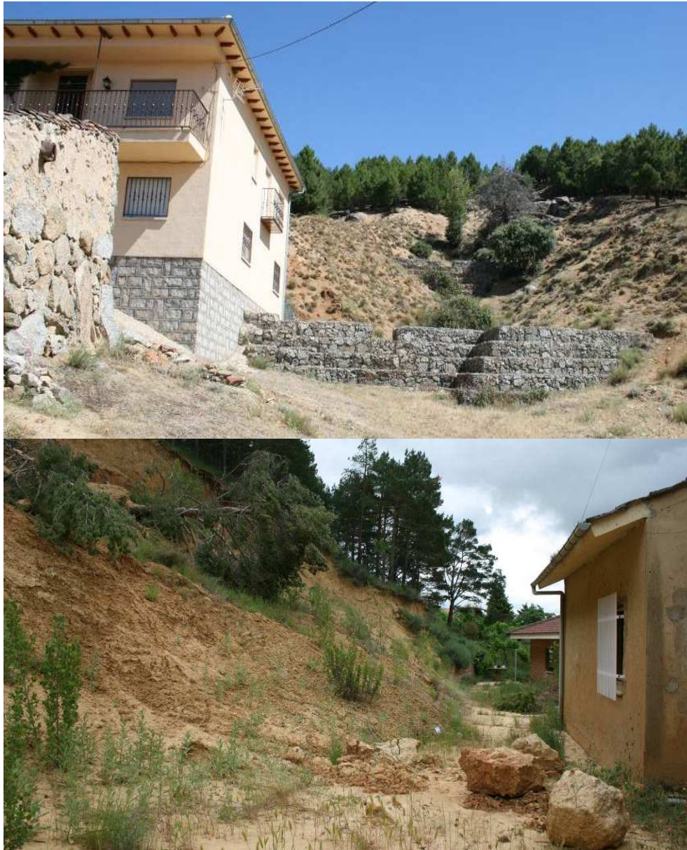
Figura 1.16. Arriba: Construcción empotrada en un dique de gaviones en Tórtolas. Abajo: Vivienda construida al pie de una cárcava en Saldaña.
