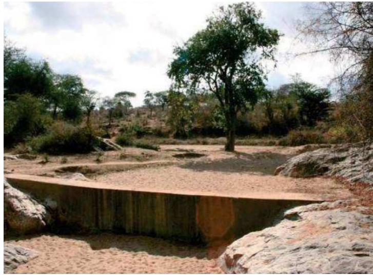
Figura 1.14. Dique subsuperficial en Kitui (Kenia) (Foto: TRAGSATEC)
