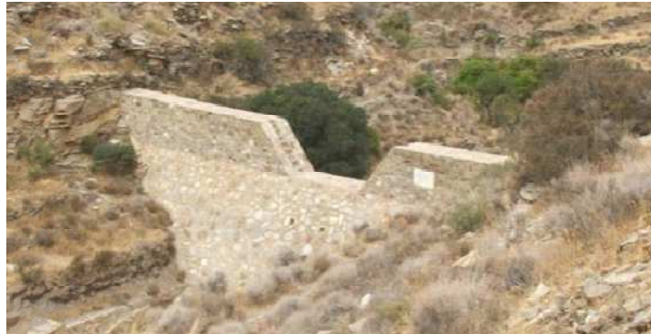
Figura 1.9. Dique de hormigón en la Sierra de los Filabres (Bellín et al. , 2011)
