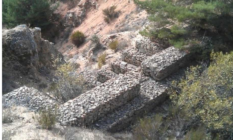
Figura 1.8. Dique de mampostería gavionada en Tórtoles (Ávila)
