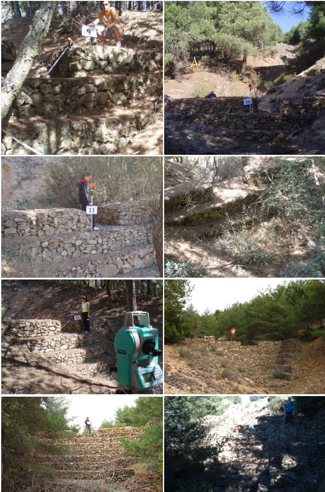
Figura A1.5. Fotos de los diques 9 a 16
