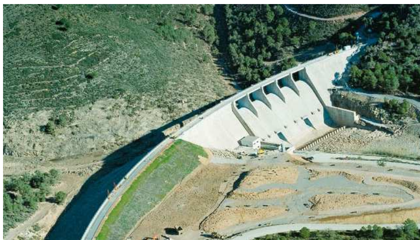
Figura 1.13. Presa del Algar (Valencia) diseñada para la recarga del acuífero (Foto: www.ohl.es)
