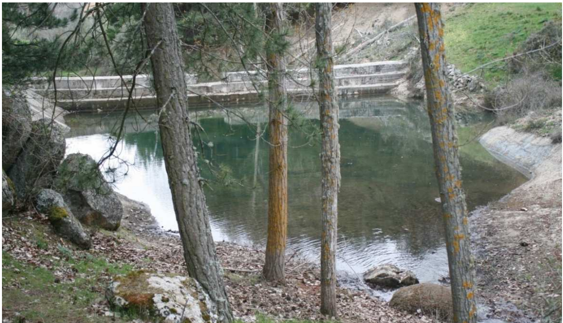
Figura 3.53: Dique cementado (dique 86)
