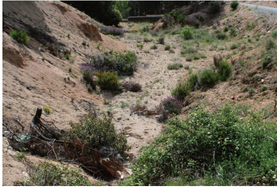
Figura 10. Cuña de sedimentos del dique 1.
