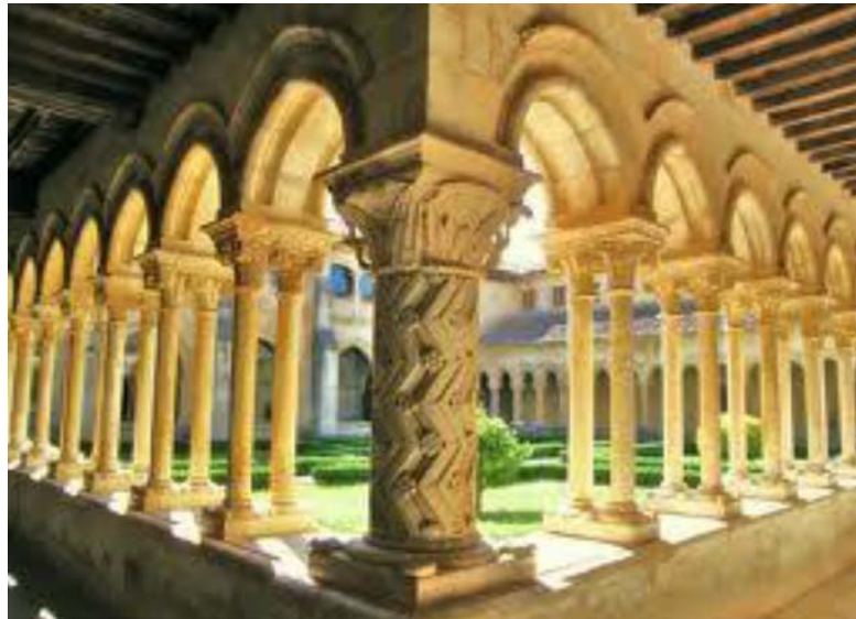
Fig. 14 Claustro de San Andrés de Arroyo.
