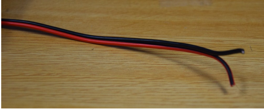
Figura 7.17.- Cable usado para la instalación del sistema de alimentación de los ventiladores.
