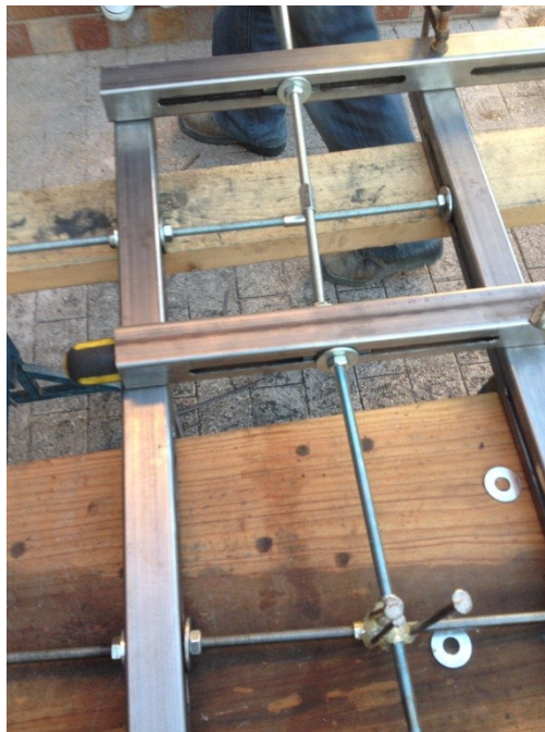
Figura 6.12.- Detalle de la colocación de las varillas roscadas formando un eje de cuadratura.
