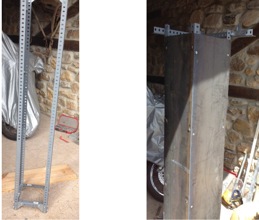
Figura 6.3.- Esqueleto metálico del armazón (derecha) y armazón terminado (izquierda)
