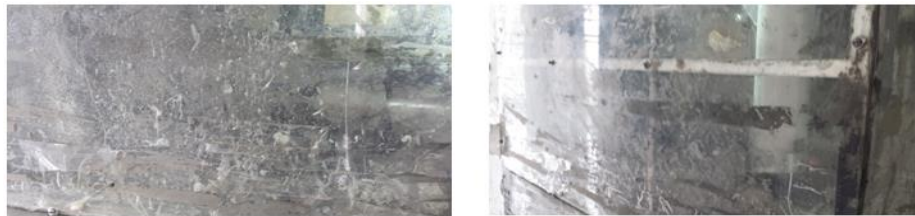
Figura 5.25. Aspecto de la tapa superior de la zona de pegado de asas
