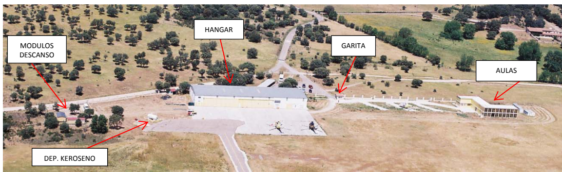
Figura 20. Infraestructuras del aeródromo "El Tietar" Fuente. HASA. Elaboración propia.
