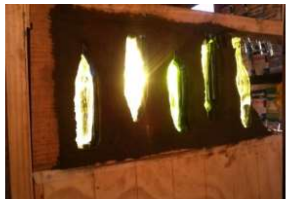
Figura 54: Tercera técnica, colocación vertical de las botellas.
