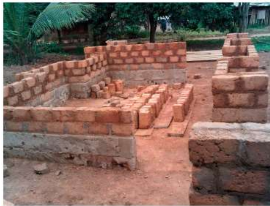
Figura 27: Construcción de la vivienda, muros de adobe.
