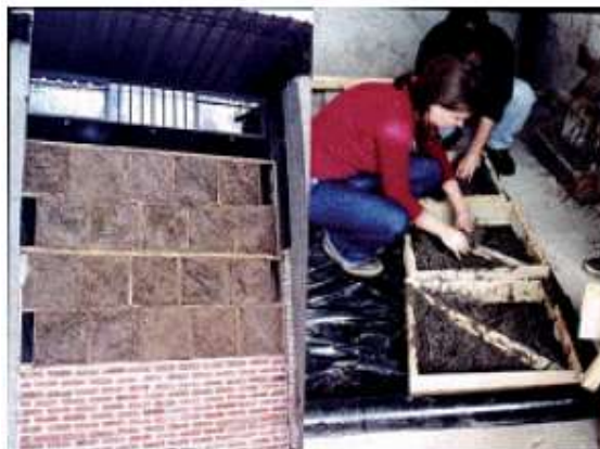
Figura 36: Sistema semi-prefabricado de paneles de tierra-paja. Elaboración de los paneles.
