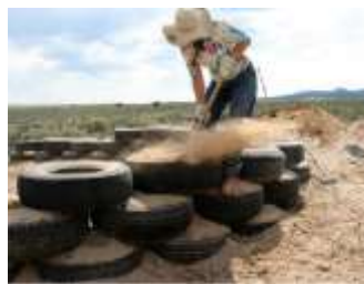
Figura 58: Proceso de compactación de tierra en un NFU.
