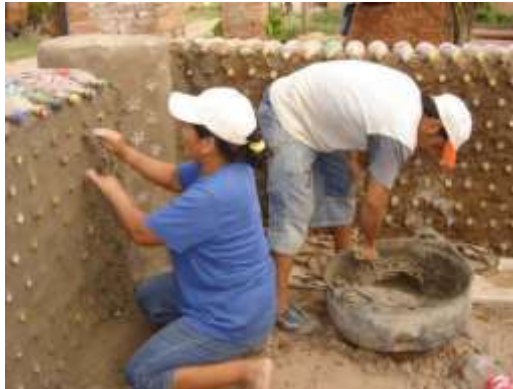
Figura 49: Construcción con botellas recicladas.
