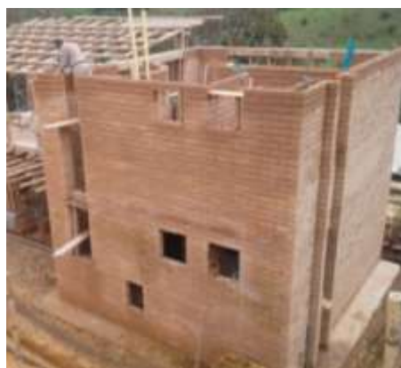
Figura 34: Ejemplo de construcción con BTC.
