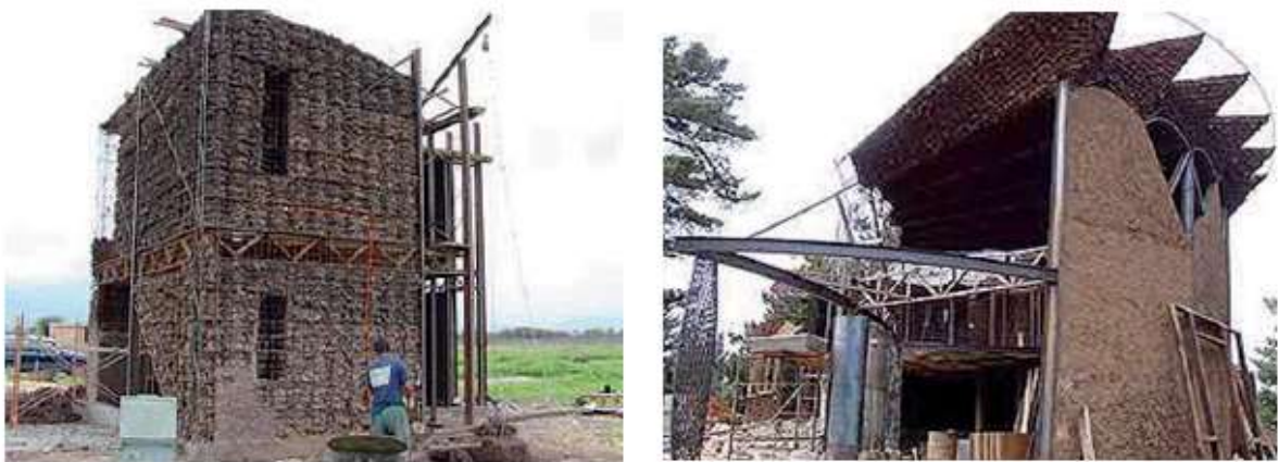
Figura 38: Vivienda realizada con tecnobarro.
