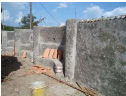
Figura 50: Construcción con botellas recicladas
