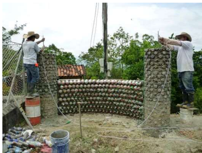
Figura 48: Construcción con botellas recicladas.
