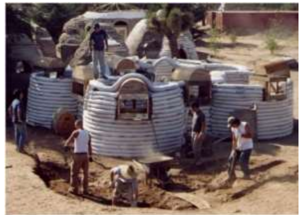
Figura 35: Croquis del proceso de construcción con superadobe (izq.) y ejemplo de construcción (dcha).
