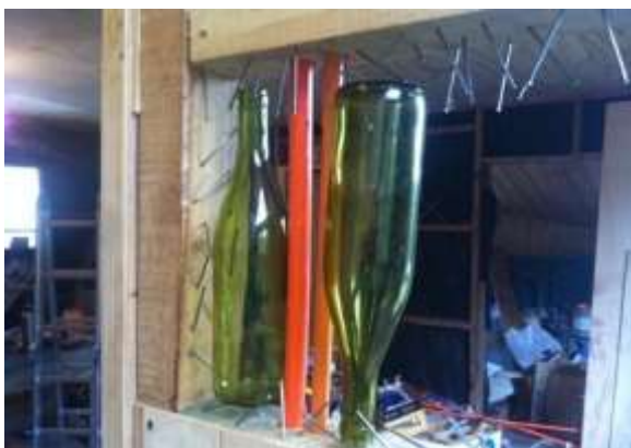
Figura 54: Tercera técnica, colocación vertical de las botellas.
