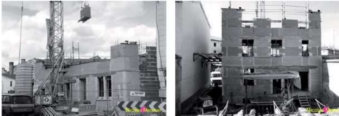
Figura 37: Prefabricación de módulos para la construcción de muros.
