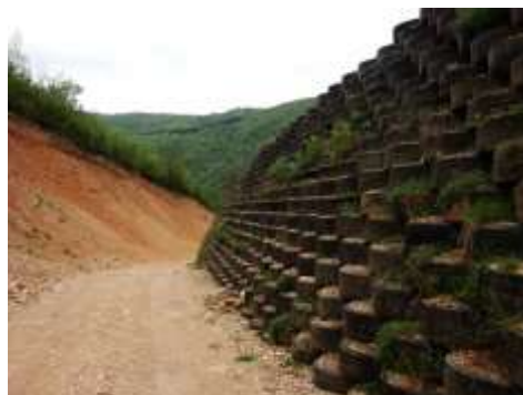
Figura 56: NFU utilizados en la construcción de un talud.
