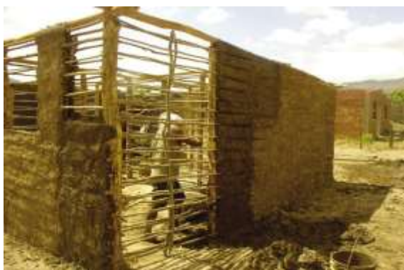
Figura 45: Ejemplo de muro macizo (izq.) y de muro vacío (dcha.)
