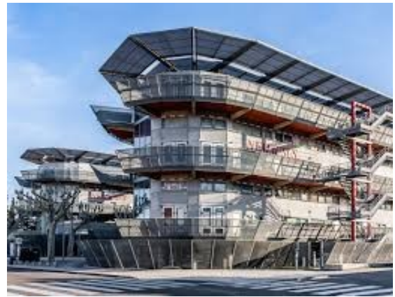
57 y 58. Vistas exteriores. Bloque de viviendas Nemausus
