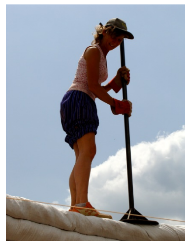
Figura 21: Apisonado de los sacos rellenos. Fuente: Domoterrae Dirección: www.domoterrae.com
