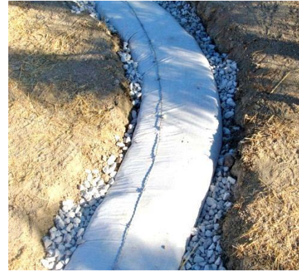
Figura 17: Cimentación mediante grava y tubos de bolsa doble rellenos de grava.
