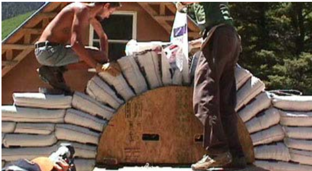
Figura 25: Ejemplo de cimbra y sacos dispuestos a modo de dovelas.
