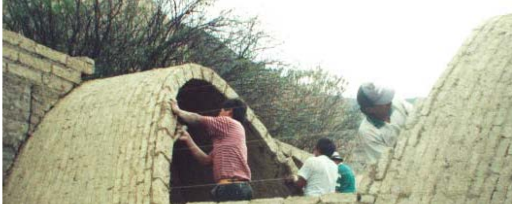
Figura 31: Proceso constructivo bóveda núbica.
