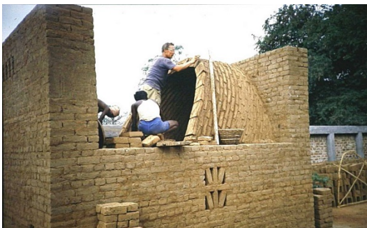
Figura 7: Construcción de Bóveda Nubia Fuente: Mudbrick House por Jan de Rooden
