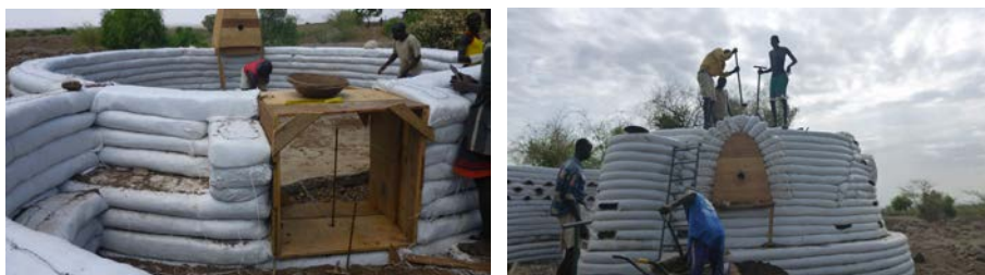
Figura 11: Momentos del proceso constructivo. Ejecución de huecos Fuente: Felix Jové Sandoval
