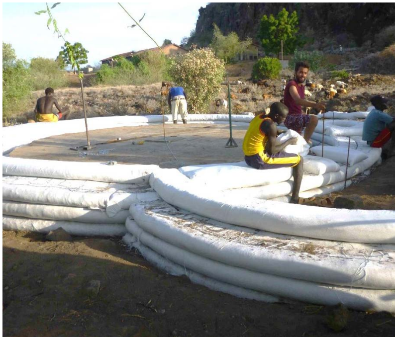
Figura 18: Construcción de las primeras hiladas. Fuente: Arquitecto Félix Jové Sandoval
