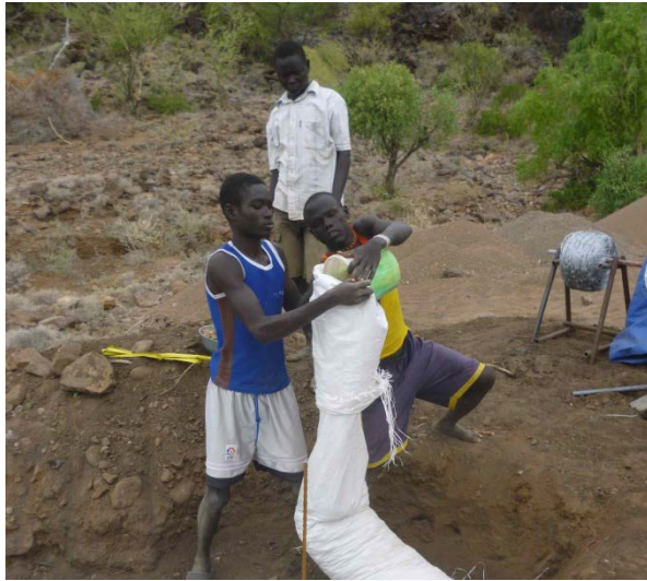
Figura 19: Relleno de los tubos Fuente: Arquitecto Félix Jové Sandoval
