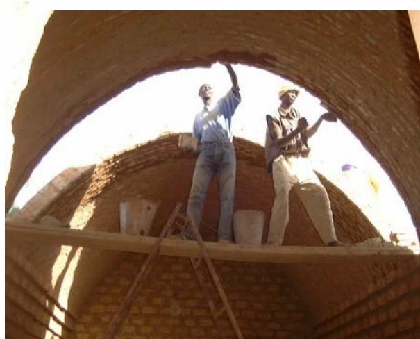
Figura 35: Vista interior de la construcción Fuente: Development workshop foundation http://www.dwf.org/sección “The vault”
