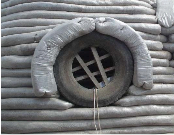
Figura 24: Neumático a modo de molde.
