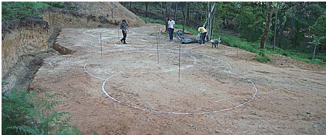
Figura 15: Ejecución del replanteo mediante cal.
