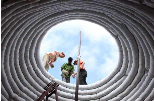
Figura 7: Construcción EarthBag en proceso. Vista interior Fuente: Arquitecto Xavier Colombet. Earthbag Building Workshop in Kyoto, Japan.
