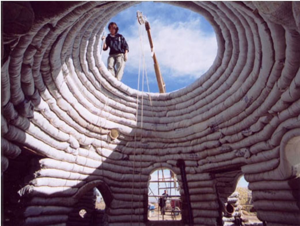
Figura 26: Vista interior de una estancia cupulada Fuente: Organización Cal-earth
