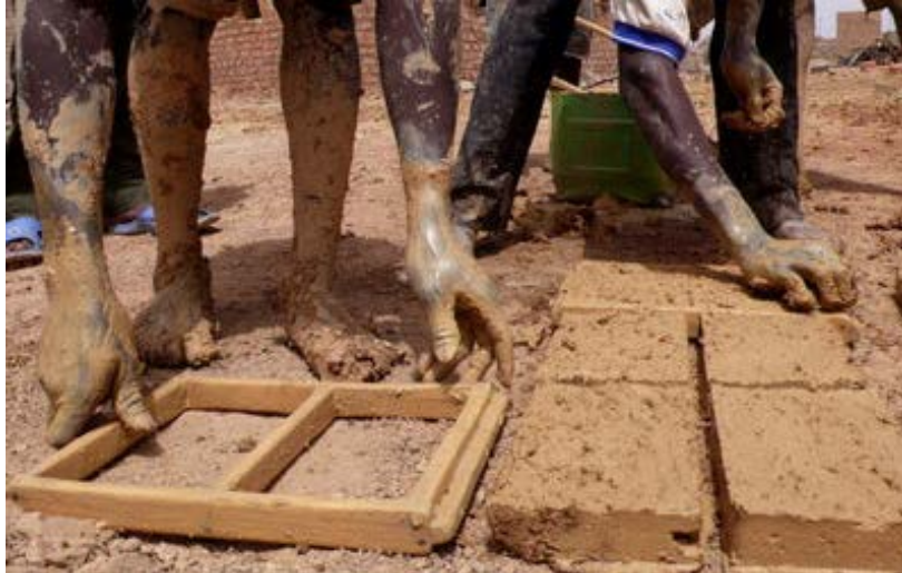
Figura 30: Fabricación artesanal de adobes de dimensiones especiales para bóveda nubia Fuente http://www.lavoutenubienne.org/
