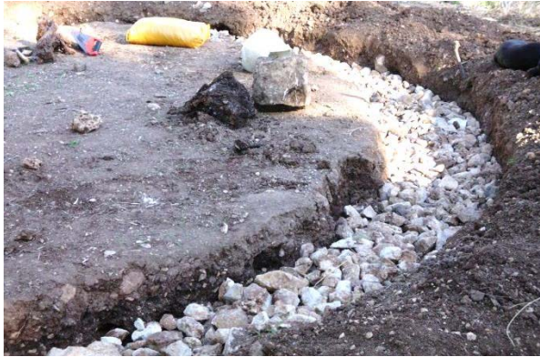
Figura 16: Cimentación mediante grava y bolos.
