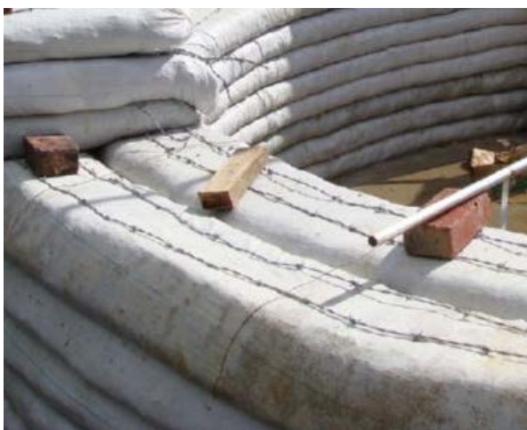
Figura 20: Alambre de púas de doble recorrido. Fuente: Arquitecto Félix Jové Sandoval
