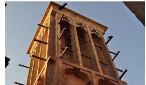
Fig. 5 - 10 Torre de viento.
