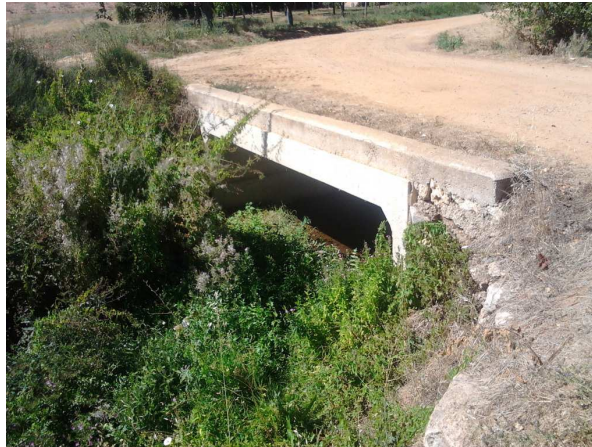
Figura 2. Foto del puente existente (aguas abajo)
