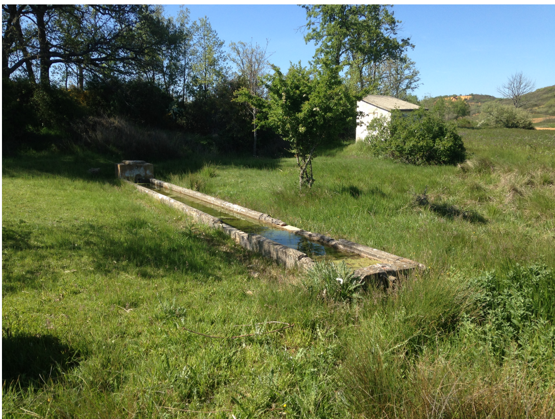
Imagen 2. Punto final de la vía (PK 4902 m).
