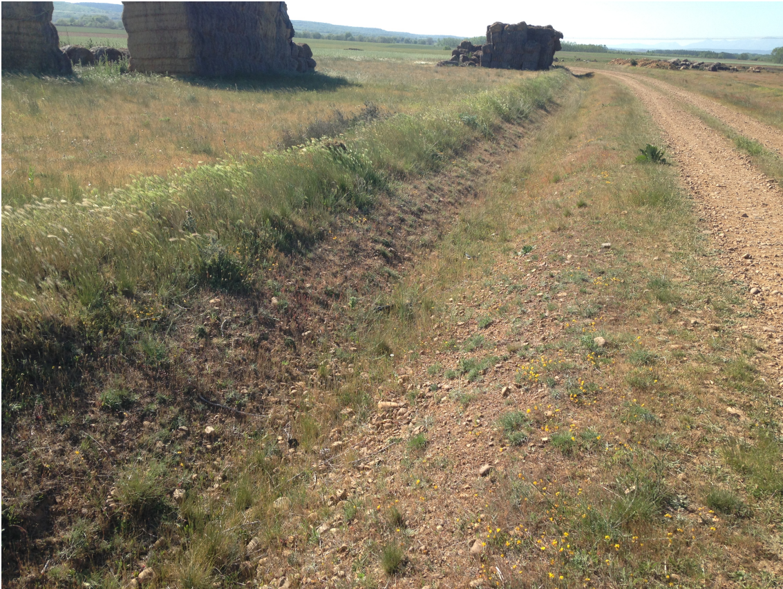
Imagen 5. Vegetación existente en cunetas de la zona.
