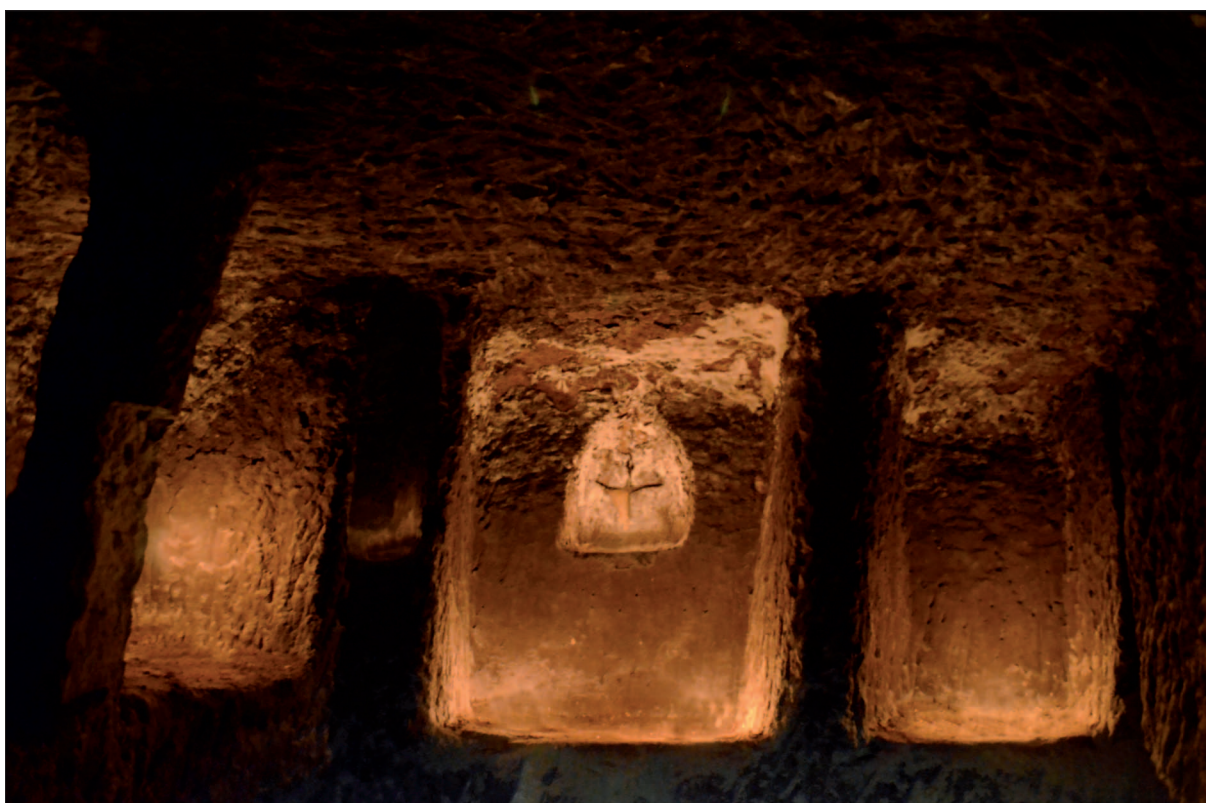
Imagen 221. Oratorio rupestre de finales del siglo XVII excavado a la entrada de la primitiva bodega de la orden de los Trinitarios en Serrada. Obsérvese la columna exenta a la izquierda de la imagen, labrada en la propia roca y el símbolo de la cruz en la hornacina central que, acompañada de imágenes religiosas, obligaría a unos momentos de recogimiento y oración, tanto a la entrada como a la salida de dicha bodega. Propiedad actual de la familia Díez Román. Foto: 21/02/2015.
