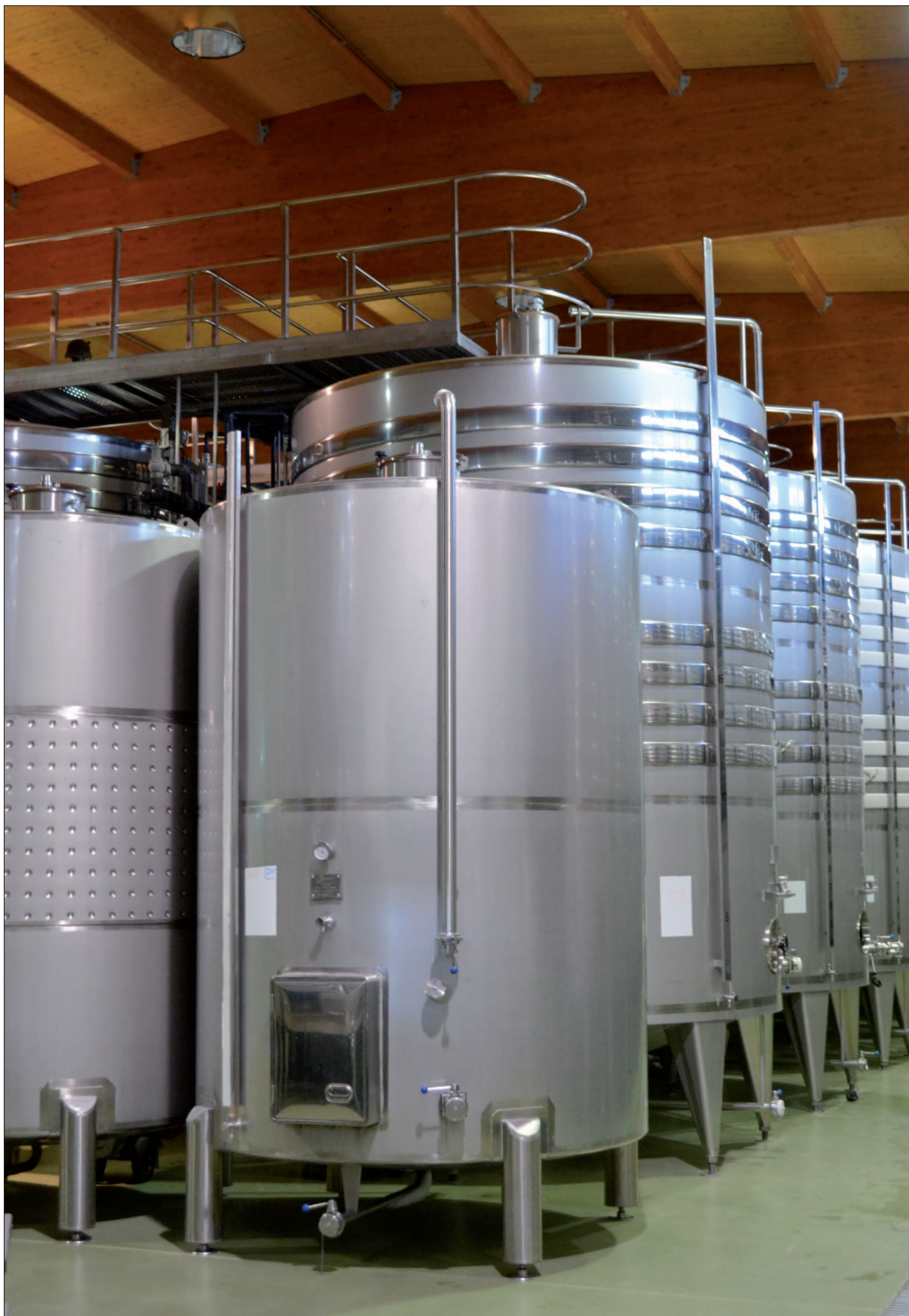
Imagen 166. Bodega en superficie dotada con los sistemas de elaboración más modernos. (Foto: 19/02/2015). Las innovaciones técnicas pronto revolucionan el sector y las nuevas fermentaciones en depósitos de acero inoxidable a temperatura controlada serán básicas para conseguir los nuevos verdejos que demanda el consumidor. En la imagen, interior de la nave de elaboración de Bodegas José Pariente. La Seca.
