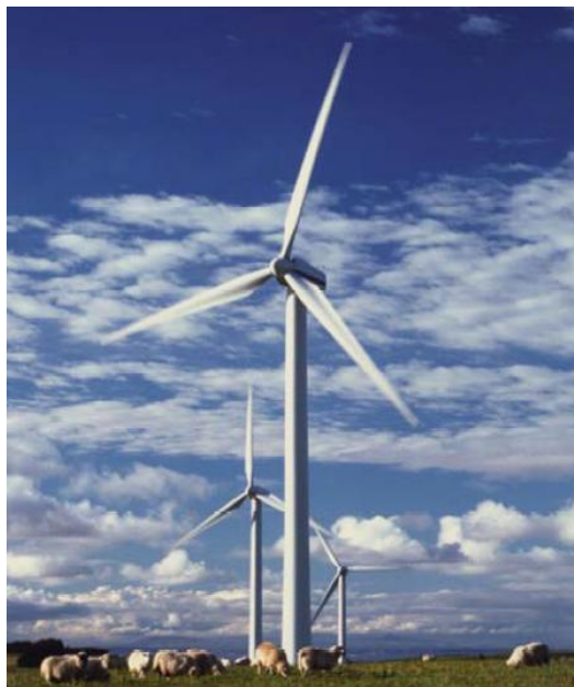
Fig. 1.2: Imagen de un aerogenerador de eje horizontal. [Sathyajith-2006].
