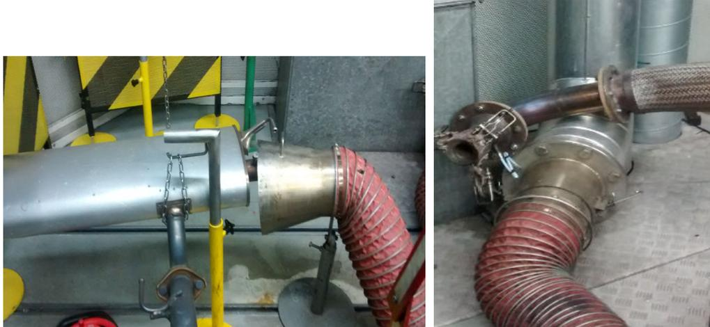
Figura 2.5: Izq.: Conexión de la línea de escape sin presurización mediante un cono. Dcha.: Conexión de la manguera al conducto de extracción.
