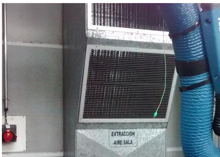
Figura 2.35: Sistema de extracción del aire de la sala.
