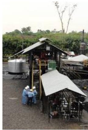
Figura 7. Módulo de recuperación A
