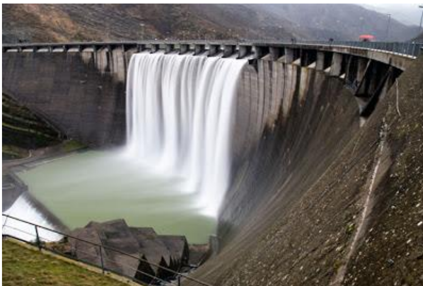
Figura 11: Central de pie de presa
