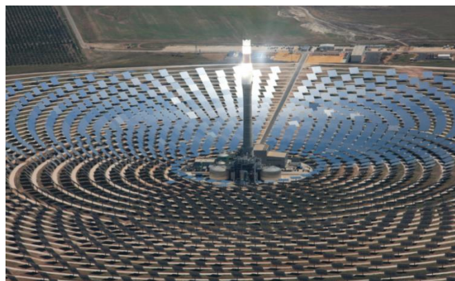
Figura 7: Instalación Solar Termoeléctrica
