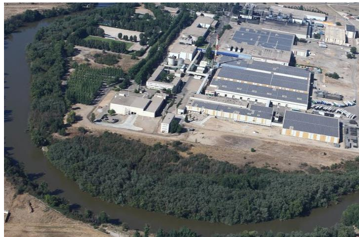
Figura 2.7. Fábrica de Valladolid
