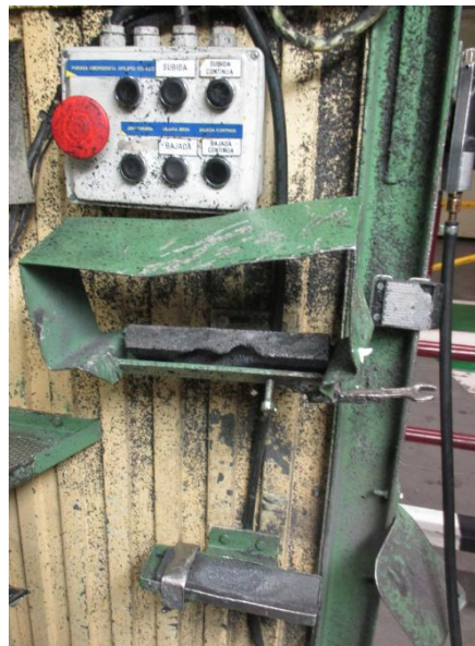
Figura 4.29. Lateral derecho antes de las modificaciones
