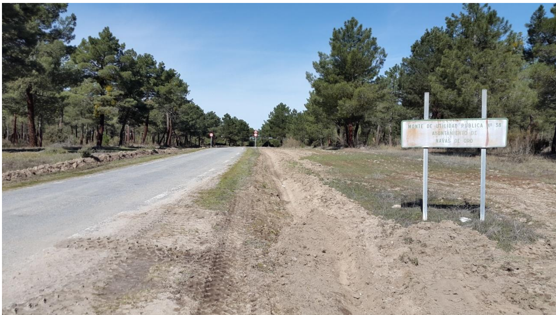
Foto nº 31: Carretera SG-V-3321. (Fuente: Elaboración propia).
