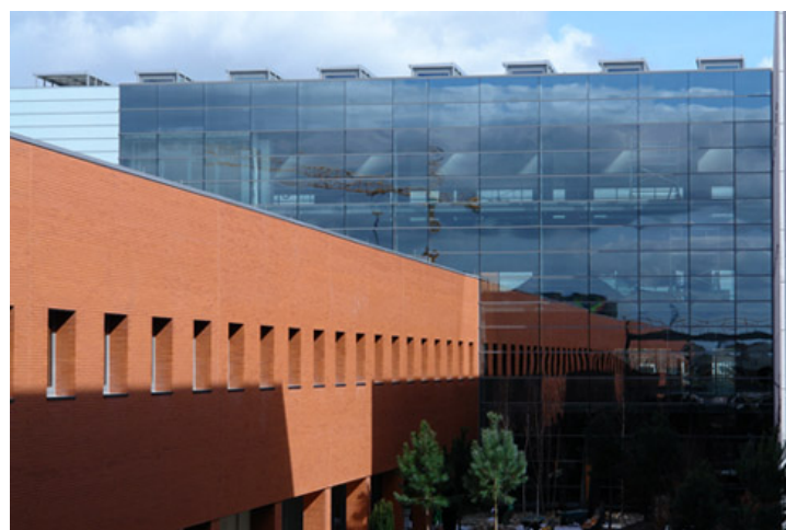
Figura 4. Ejemplo aprovechamiento de luz natural mediante cristaleras. Fuente: [27]
