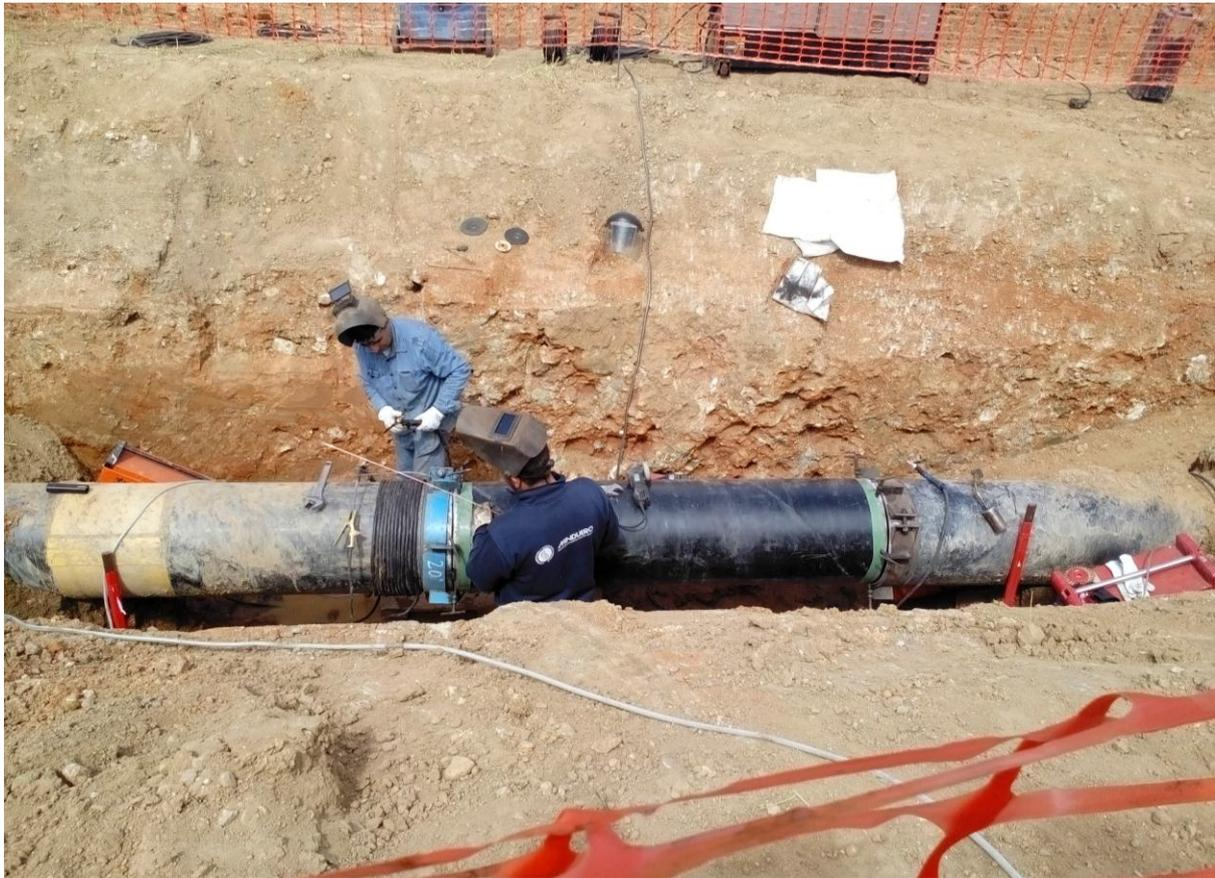
19. Trabajo de soldadura de un carrete al tubo del gasoducto, Segovia.
