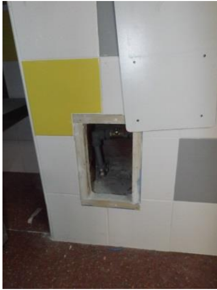
Figura 4.2.6. Patinillo a pie de pilar (Elaboración propia)
