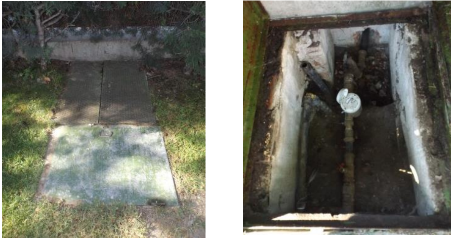
Figura 4.2.2. Arqueta de contado general (Elaboración propia)
