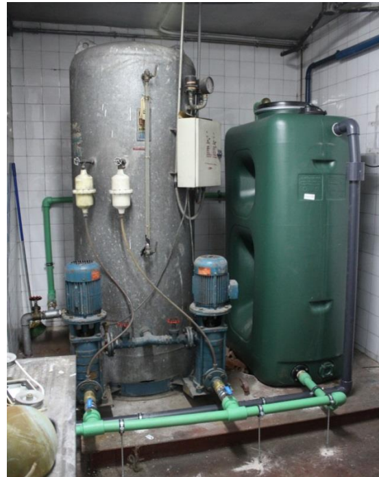
Figura 4.3.4. Grupo de presión Ed. De Direcc. E Investigación (Elaboración propia)
