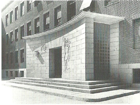
(3) Instituto Nacional de Óptica "Daza de Valdés", Madrid, 1948. Marquesina de entrada.
