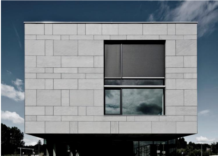
8 Revestimiento exterior de paneles de fibrocemento
