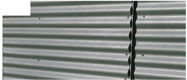
11 Placa metálica ondulada de aluminio
