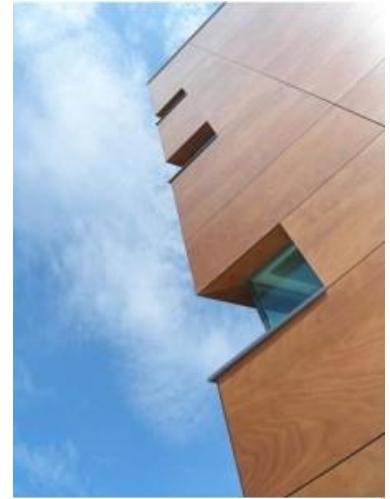
9 Revestimiento exterior de paneles de madera
