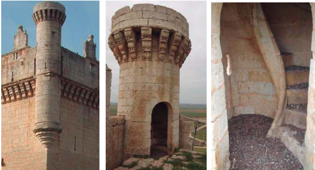
Imágenes exteriores e interiores de las garitas, obtenidas durante la visita al castillo.
