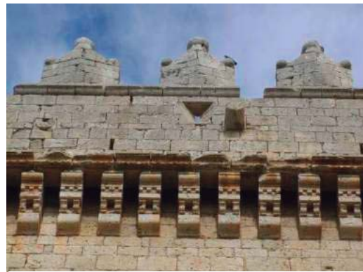
Imágenes del parapeto del matacán, obtenidas durante la visita al castillo.
