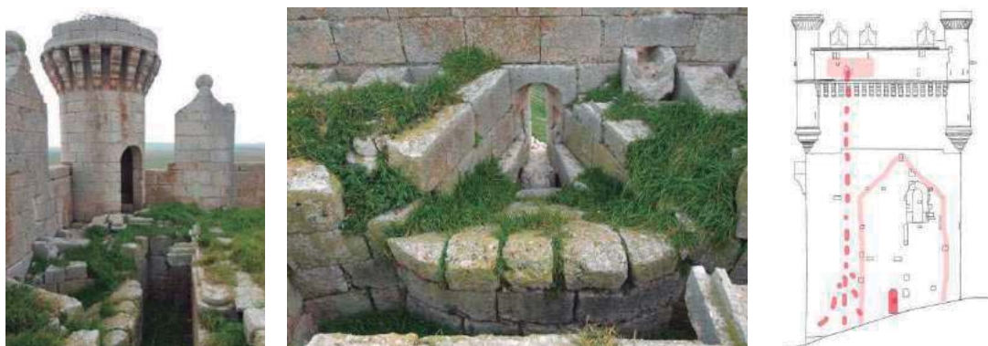
Imágenes del depósito de cubierta obtenidas durante la visita al castillo. La última de las imágenes esta sacada del Proyecto de Fernando Cobos, sobre la que he analizado donde estaba la construcción y donde desagua el depósito de la cubierta.
