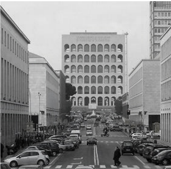
Fig. 7 Palazzo Della Civiltà Italiana desde el Palazzo dei Congressi. Vista Exterior. 1990
