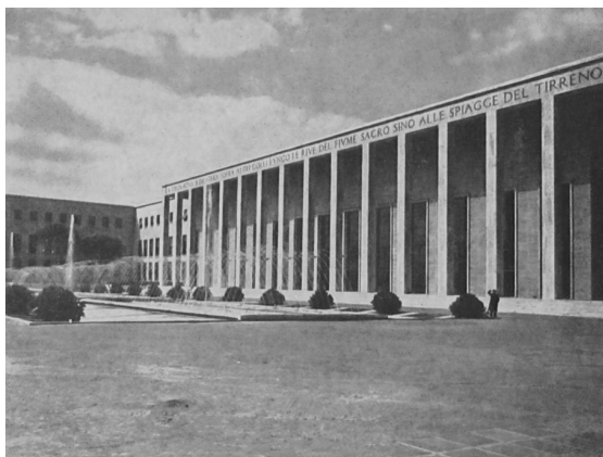
Fig. 92 "Palazzo del Commissariato e dell'Ente Autonomo". Vista exterior.
