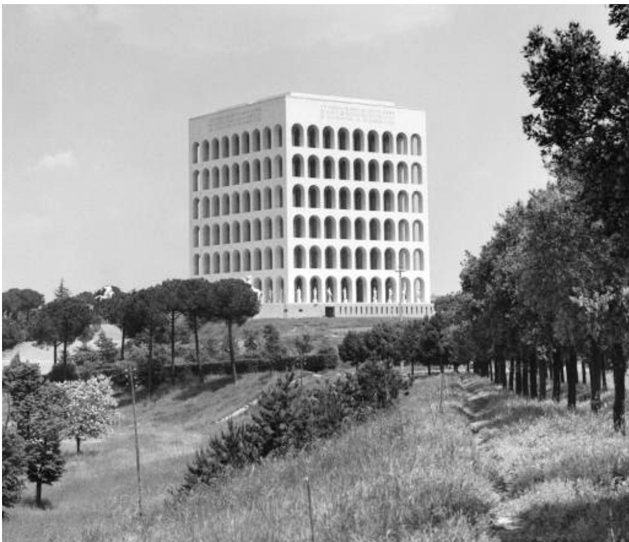
Fig. 19 "Palazzo Della Civiltà Italiana", apoyo topográfico sobre podio. Vista exterior 1960
