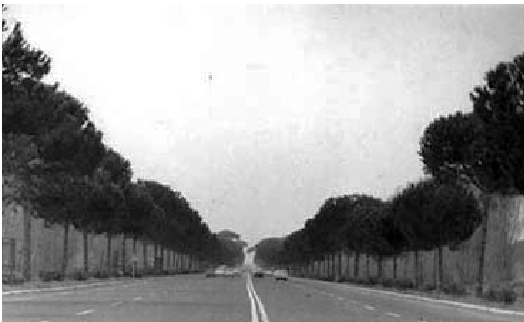
Fig. 58 Via Imperiale. Vista exterior. 1956
