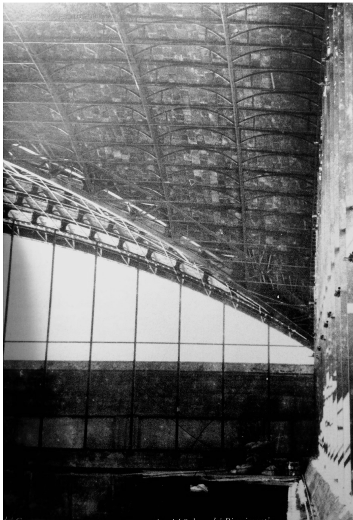
Fig. 103 El "Palazzo dei Ricevimenti", construcción con estructura metálica de la bóveda de arista, 1939
