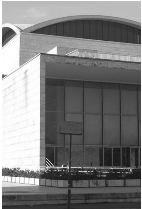
Fig. 48 Lateral del pronaos posterior de ingreso al "Palazzo dei Ricevimenti e dei Congressi". Vista exterior. 2015
