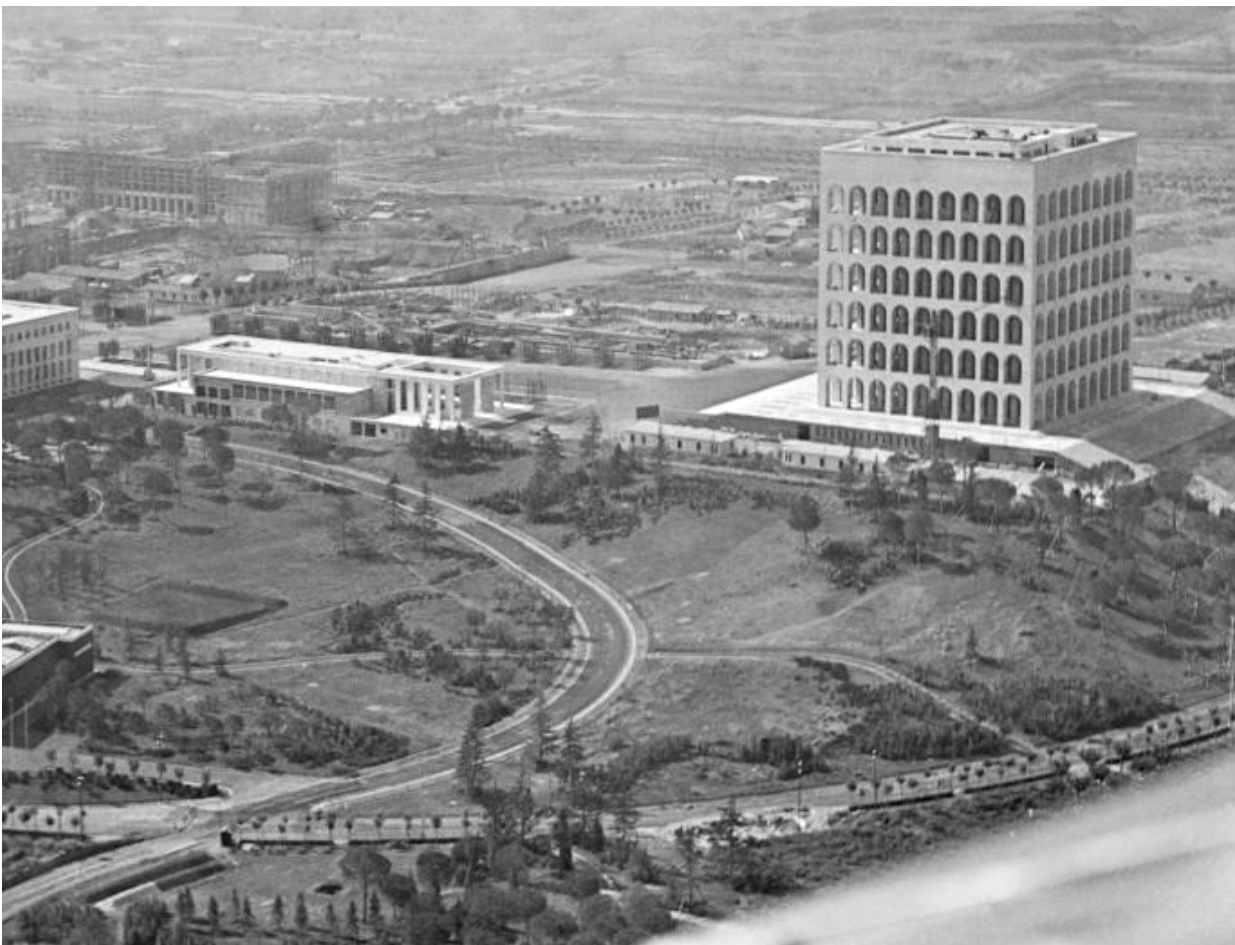
Fig. 13 "Palazzo Della Civiltà Italiana" Vista aérea. 1960 .
