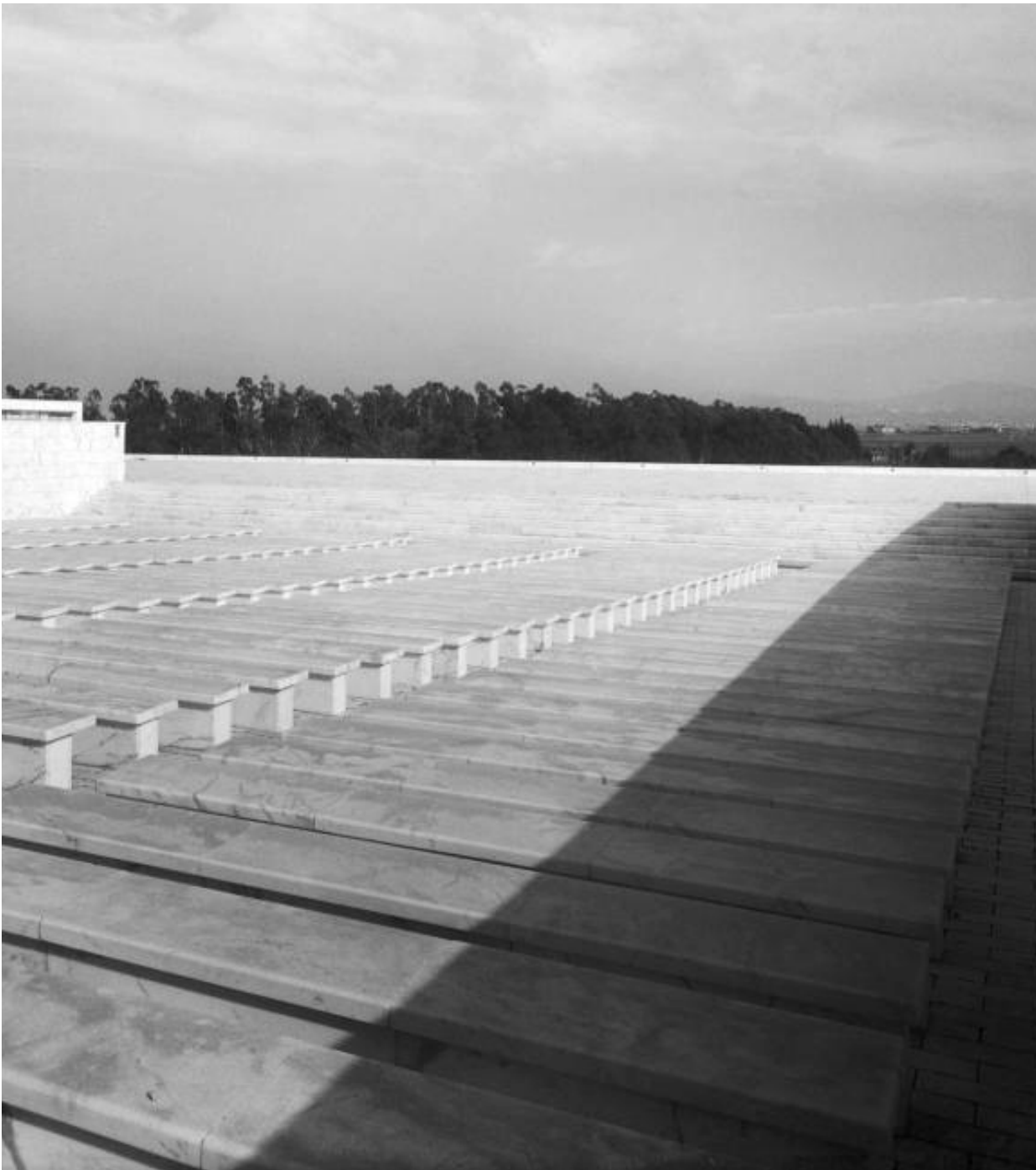
Fig. 10 Palazzo dei Ricevimenti e dei Congressi, "Terraza Teatro". Vista exterior. 1960
