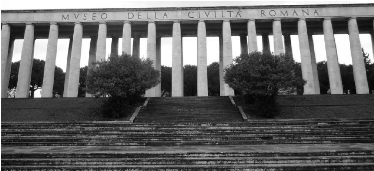
Fig. 114 "Loggia del Museo della Civiltà Italiana". Vista exterior
