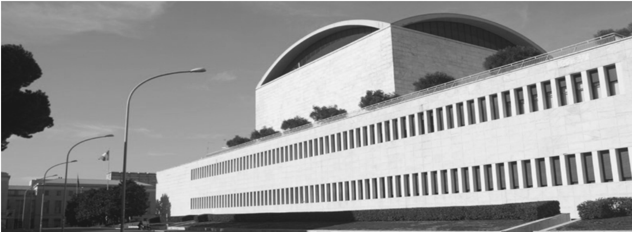
Fig. 45 "Palazzo dei Ricevimenti e dei Congressi". Vista exterior. 2015
