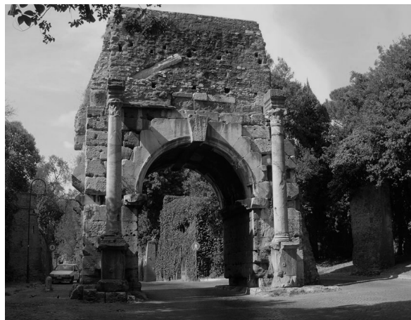
Fig. 73 "Arco di Druso" en la puerta de "San Sebastiano." Vista exterior. 2016
