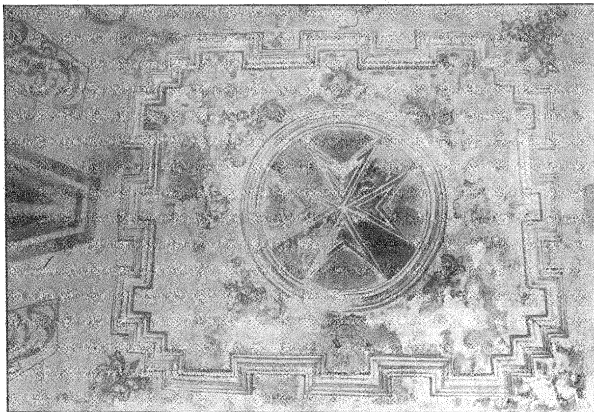
Techo de la sacristía de la iglesia de Arbejal con decoración barroca. (S. XVIII).
