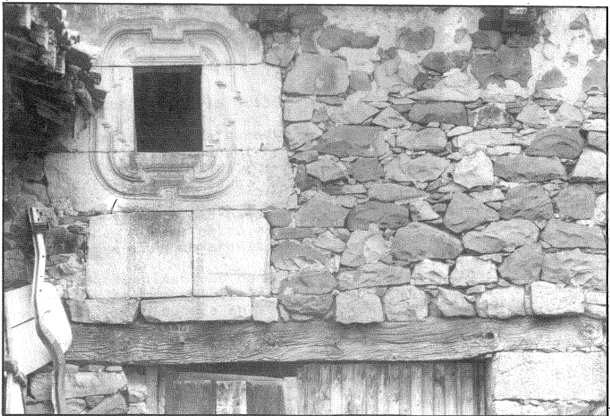
Ventana barroca reutilizada en una construcción popular de Herrerueta de Castilleria.
