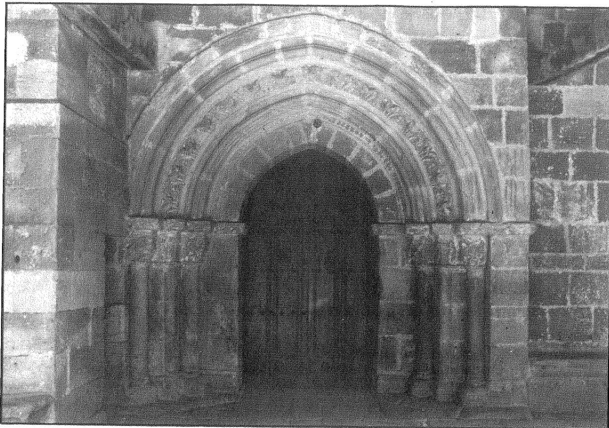
Portada con arco apuntado. Iglesia de San Cristóbal de Rueda.
