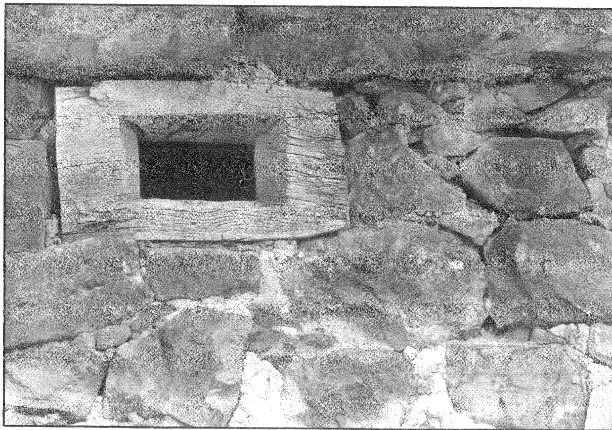
Detalle de construcción popular
