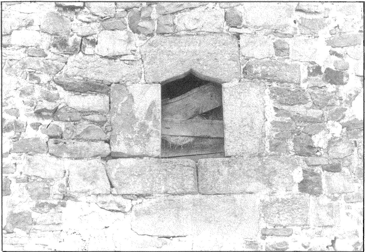
Ventana del gótico final en una casa de San Felices de Castillería.
