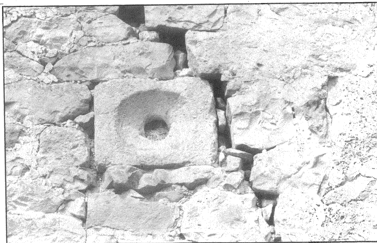
Vano constituido por una sola pieza con un hueco central. (Ligüerzana).
