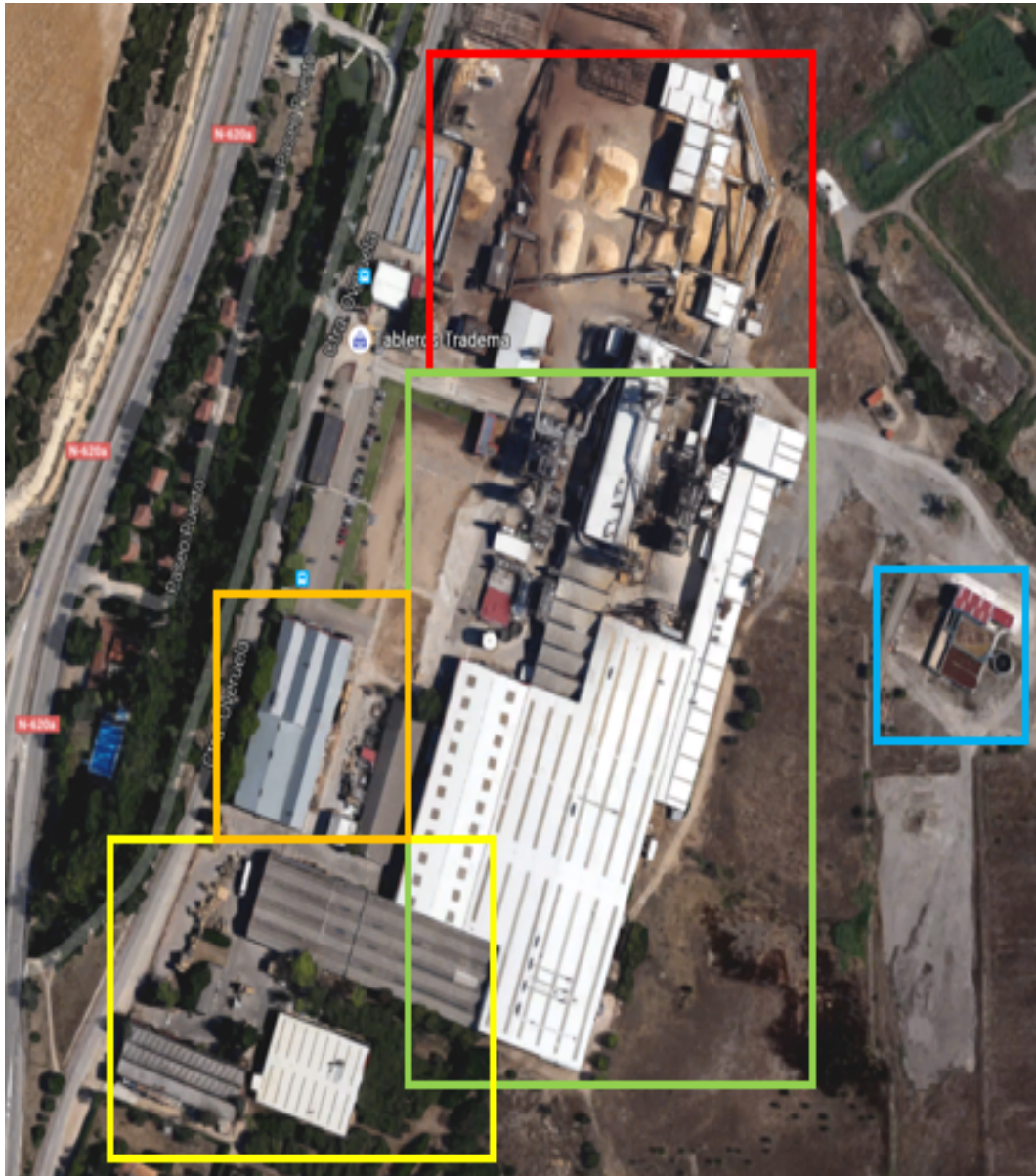
Imagen 4.3 Vista aérea de Tableros Tradema S.L (26)
