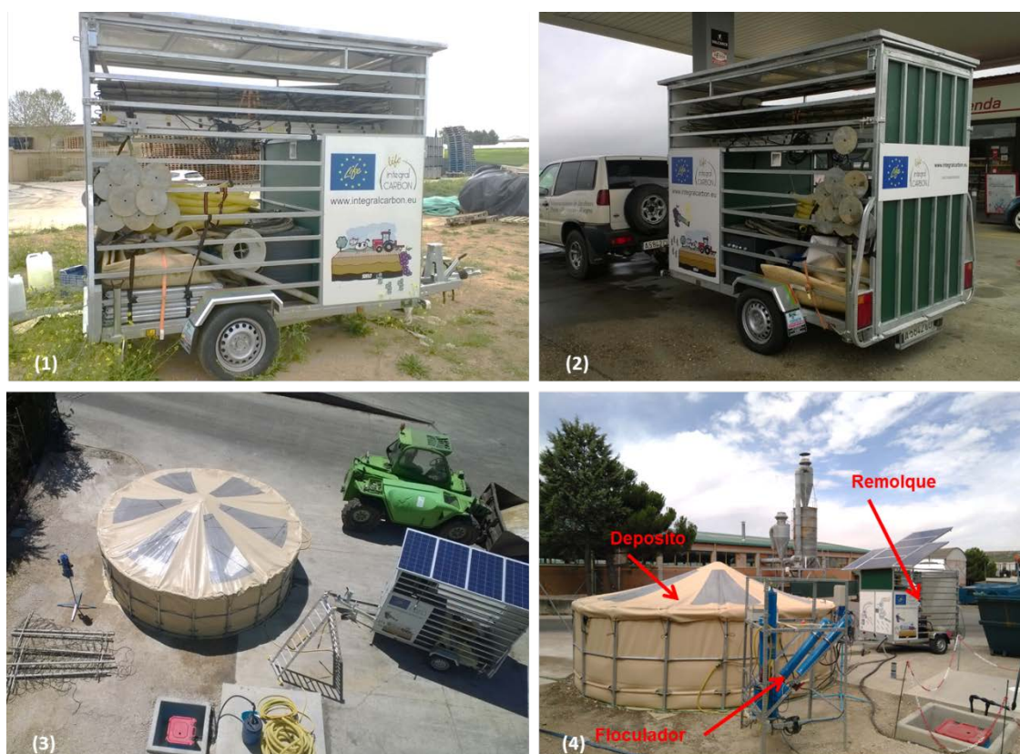
Figura II.46. Fotografías del traslado de DO Vinos de Uclés (Cuenca) a instalaciones de la empresa Ropulpat en Burgos. (1) MPB recogido y listo para ser transportado. (2) Transporte del MPB en trayecto dirección Burgos. (3) Vista del montaje de MPB, donde se aprecian los dispositivos que componen el modulo. (4) Vista de montaje finalizado del MBP.
