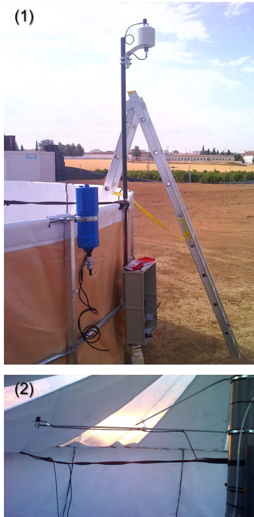
Figura I.28. (1). Sonda de radiación PAR exterior. (2) Sonda de radiación PAR interior, bajo cúpula transparente.
