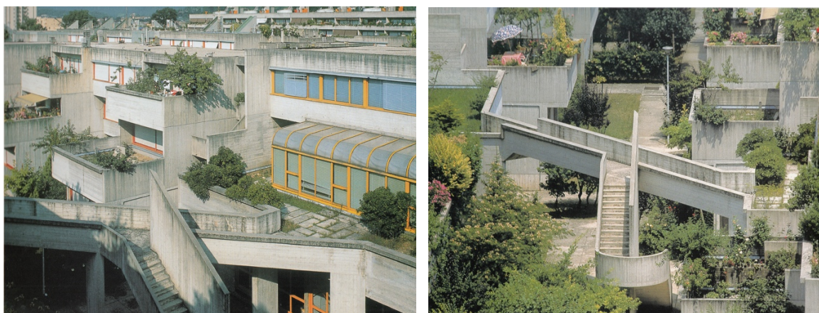
Figura 1.6 y 1.7 Villaggio Matteotti, Giancarlo De Carlo. Terni, Italia.
