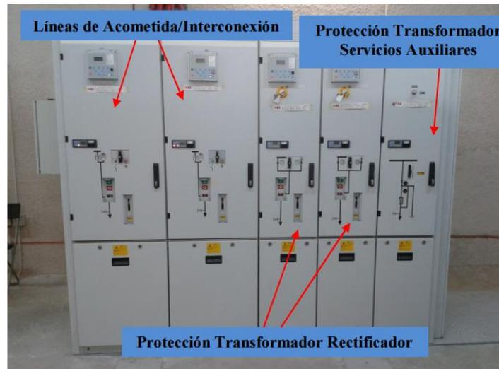
Figura 8. Ejemplo de celdas de protección de transformadores
