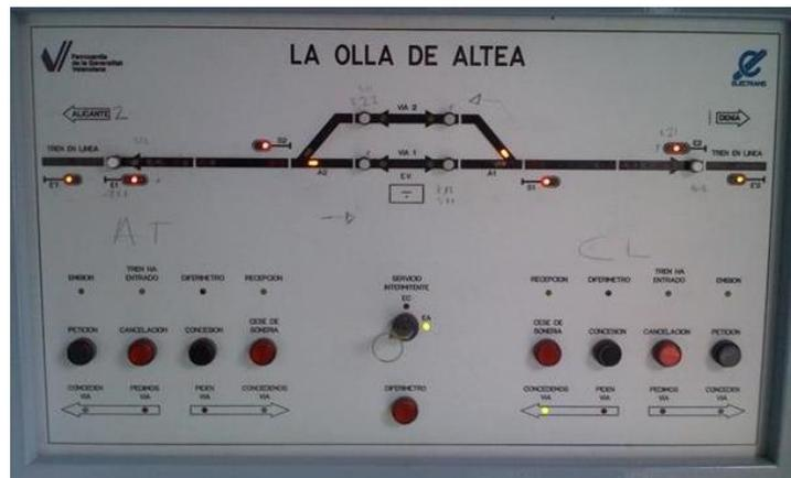
Figura 27. Ejemplo de Panel de Bloqueo Eléctrico Manual
