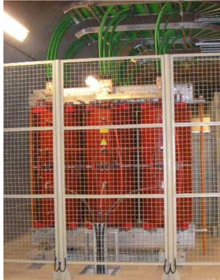
Figura 7. Transformador seco
