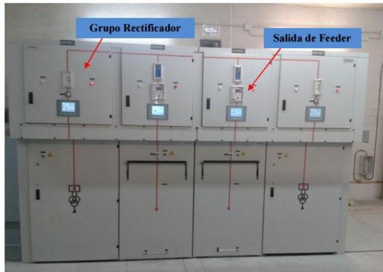
Figura 9. Ejemplo de celdas de protección de rectificadores
