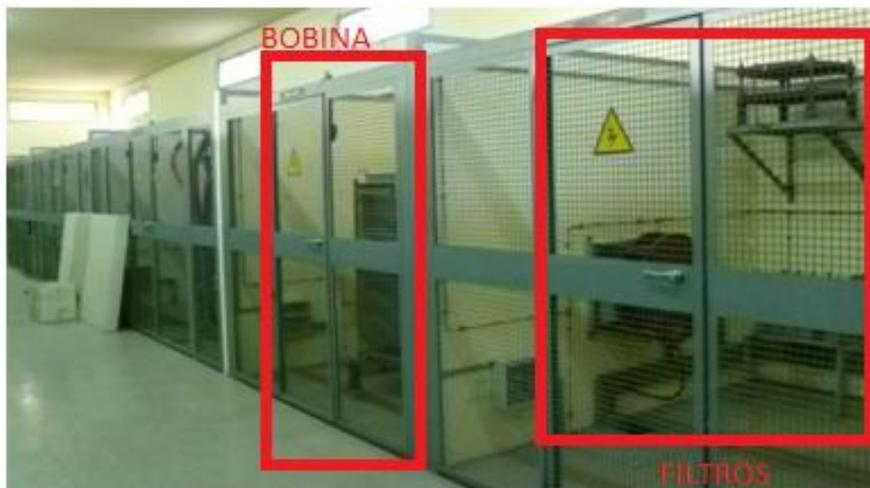
Figura 22. Bobina de alisamiento y filtros
