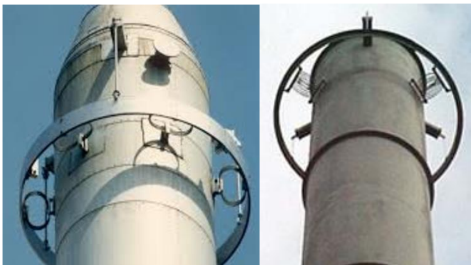
Figura 1. Chimenea industrial con TMD pendular
