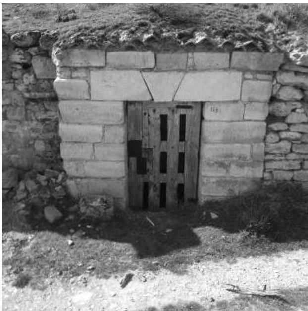
Frente de fachada. Bodega 113.
