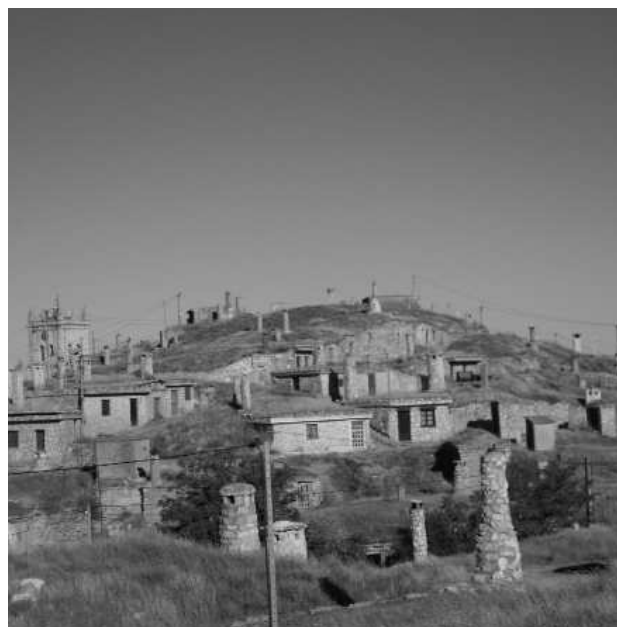
Vista de las bodegas desde el sureste.
