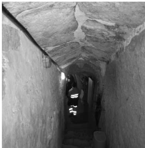
Cañón con techo de piedra. Bodega 180.
