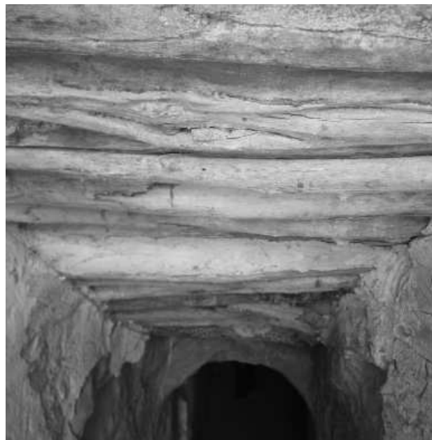
Cañón con techo de latas de madera de enebro.. Bodega 30.
