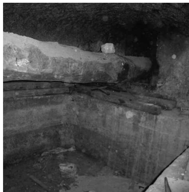
Apoyo de la viga en el fondo del Lagar. Bodega 128.
