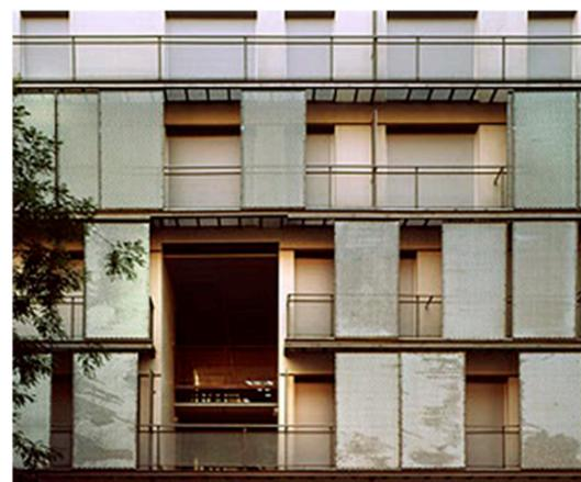
La solución, una galería civil interior, con acceso directo a los hogares, construida en acero galvanizado, transparente y separada de la fachada para permitir la ventilación y la iluminación.
