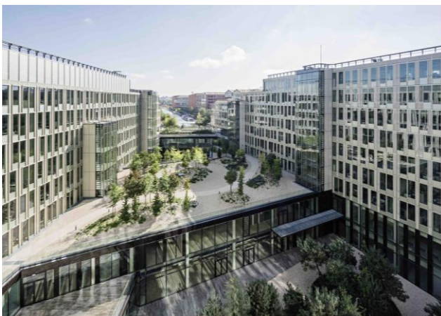
Patio interior (vista 01)
