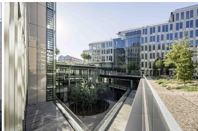
Patio interior (vista 02)
