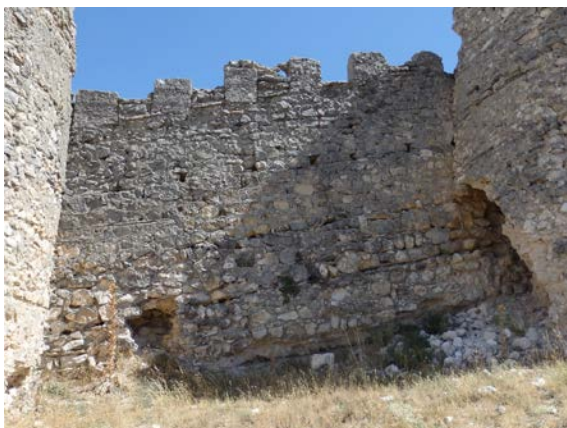
Fig. 5.3.42. Tramo entre las torres T6 y T7 [A.S.E. 8/7/2015]
