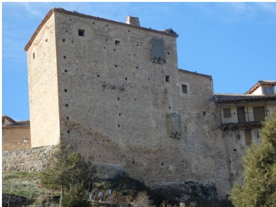
Fig. 5.5.37. Puerta de la villa desde el noroeste [A.S.E. 18/11/2015].
