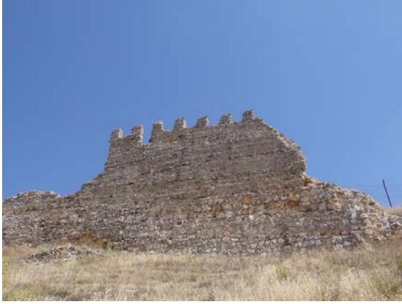
Fig. 5.3.50. Tramo aislado L4 visto desde el exterior [A.S.E. 17/6/2014].
