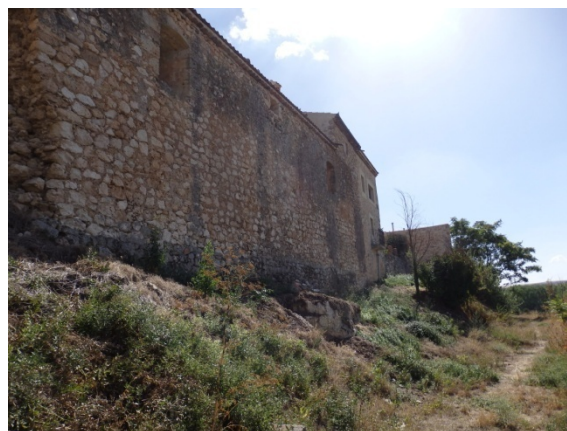
Fig. 5.4.31. Muro en el tramo P2-T2 [A.S.E. 3/9/2014].
