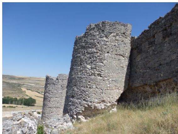
Fig. 5.3.43. Torre T7 vista desde el este. Al fondo se ve la torre T6 [A.S.E. 8/7/2015]
