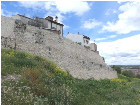
Fig. 5.2.79. Tramo entre el portillo de Exángel y la puerta de las Cuevas [A.S.E. 12/5/2016].
