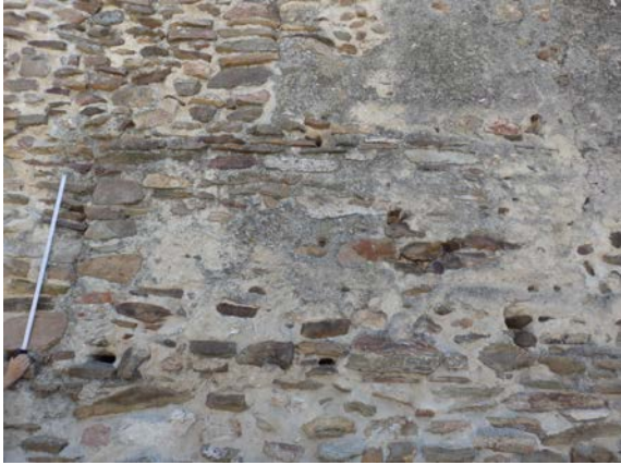
Fig. 5.1.34. Tapia de mampostería [A.S.E. 14/8/2016].
