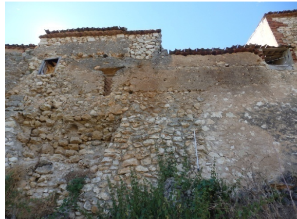
Fig. 5.4.35. Hiladas de tapia visibles en el tramo T2-suroeste [A.S.E. 23/7/2016]
