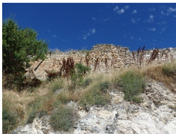
Fig. 5.4.45. Muro en el tramo T3-L3 [A.S.E. 23/7/2016]
