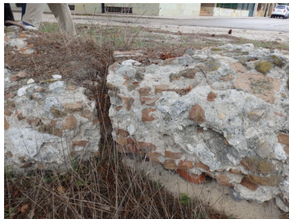
Fig. 5.1.37. Tapia de cal y canto con elementos cerámicos [A.S.E. 11/2/2014].
