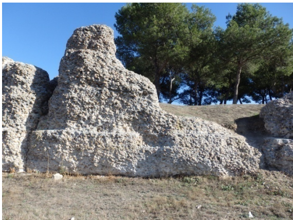
Fig. 1.5. Tramo de muralla en la zona cercana al castillo de la Mota en Medina del Campo, Valladolid. [A.S.E. 05/11/2014]
