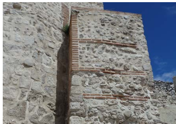
Fig. 5.2.88. Tapia mixta con verdugada doble en el elemento T8a, junto a torre de Santiago (T8). En la base el machón es de piedra [A.S.E. 12/5/2016].
