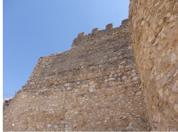
Fig. 5.3.51. Tramo al oeste de torre T9 [A.S.E. 17/6/2014].
