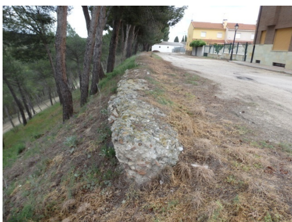
Fig. 5.1.15. Tramo L2 de muralla, en la zona este. [A.S.E. 11/02/2014].
