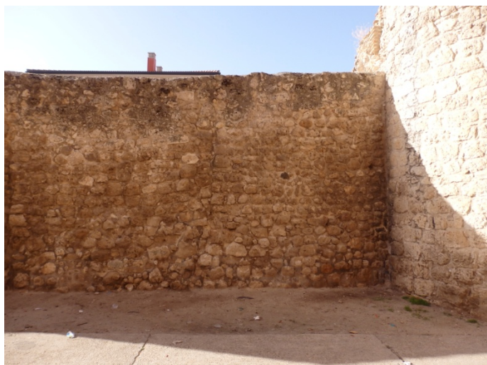
Tramo en la calle Ronda
