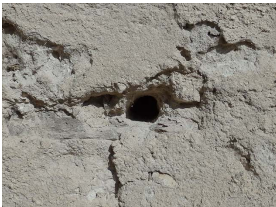
Fig. 5.2.100. Mechinal central en base de tapia T3.4 con sección circular y diámetro de 3cm [A.S.E. 20/8/2014].
