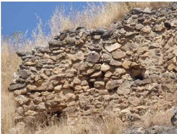
Fig. 5.5.39. Tapia de mampostería [A.S.E. 24/7/2016]
