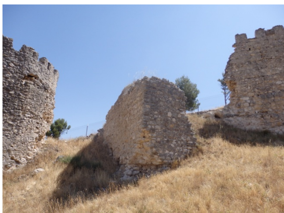
Fig. 5.3.32. Supuesta torre T4, vista desde el exterior [A.S.E. 8/7/2015].
