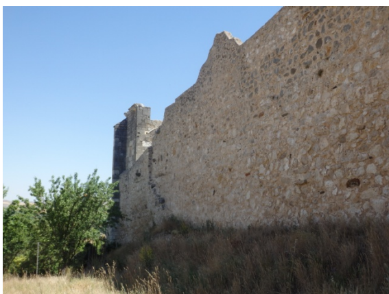
Fig. 5.3.20. Aspecto del tramo desde el hospital. Se observa una forma particular en lo alto del muro [A.S.E. 8/7/2015].
