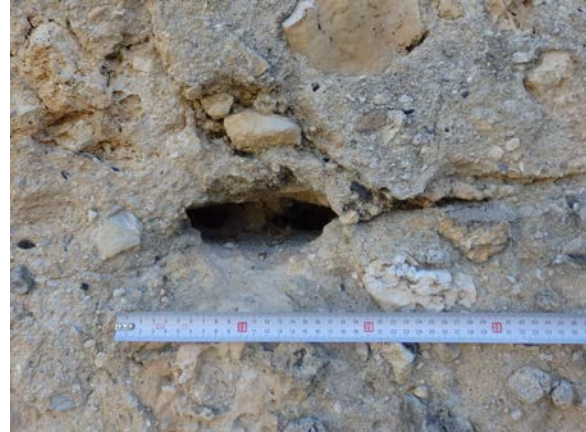
Fig. 5.3.103. Mechinal M3.7 del tramo D2 en T5-T6, cuyo interior parece albergar dos canales [A.S.E. 23/7/2016].
