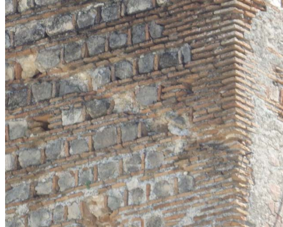
Fig. 6.29. Mampostería encintada en la posible torre en el interior del recinto de Sepúlveda [A.S.E 24/7/2016].
