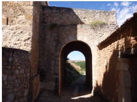
Fig. 5.4.27. Alzado interior de la puerta del Barrio [A.S.E. 23/7/2016].
