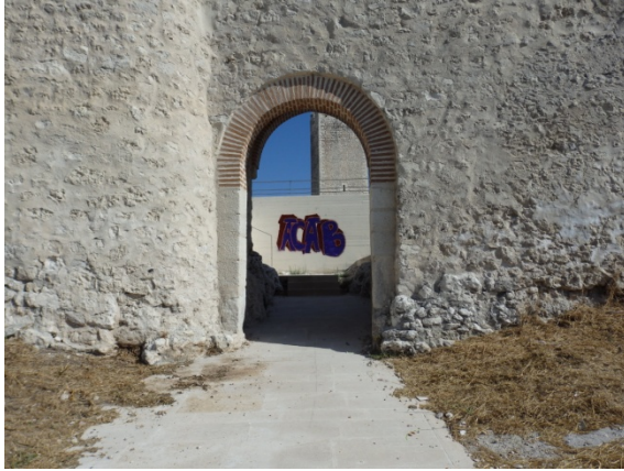
Fig. 5.2.55. Portillo de la Huerta (P6). Se observa la discontinuidad en el lienzo a la izquierda del portillo [A.S.E. 20/8/2014].
