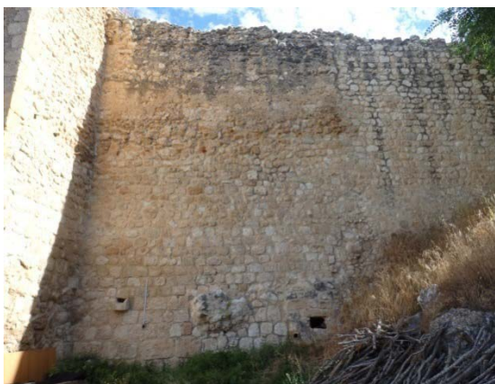
Fig. 5.4.18. Tramo T1-oeste [A.S.E. 23/7/2016].
