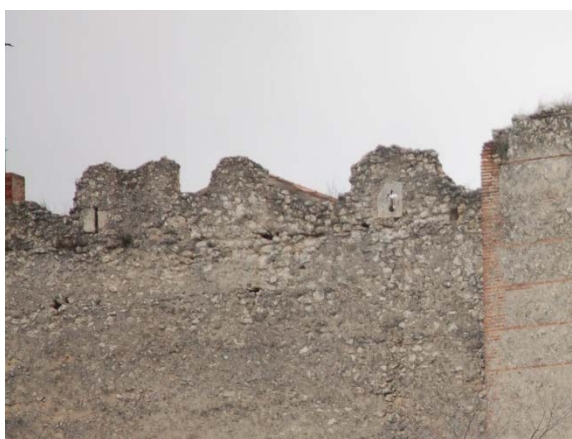
Fig. 6.24. Almenado de Cuéllar antes de su restauración, junto a la torre T6. Fuente: Fotografía facilitada por Fernando Nieto y Jesús Nieto.
