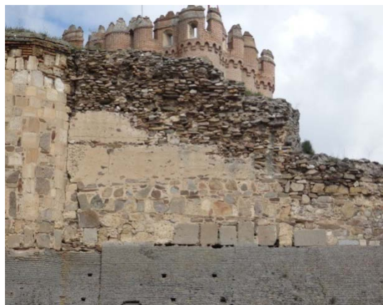
Fig. 5.1.12. Lienzo de muralla sobre el foso del castillo [A.S.E. 11/02/2014].
