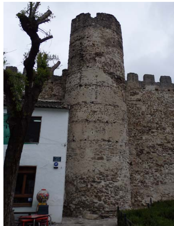
Fig. 6.17. Torre T3 de Coca [A.S.E. 24/7/2015].
