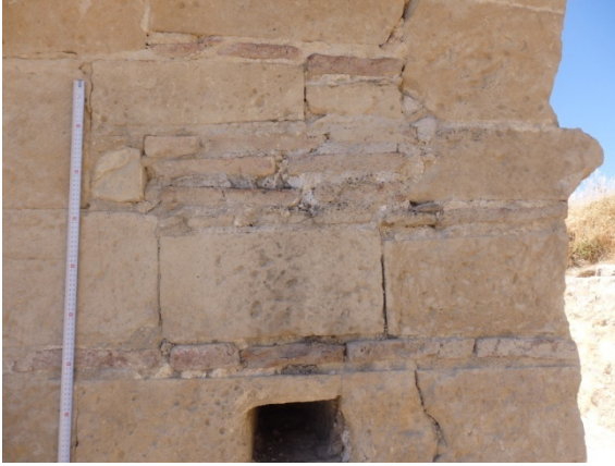
Fig. 5.5.43. Sillería en el alzado exterior del postigo de Hontanillas. Se observan hiladas de ladrillo entre los sillares [A.S.E 24/7/2016].
