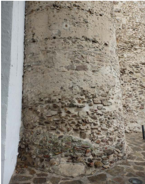
Fig. 5.1.79. Vista frontal de la base de la torre T3 [A.S.E. 2/11/2014].
