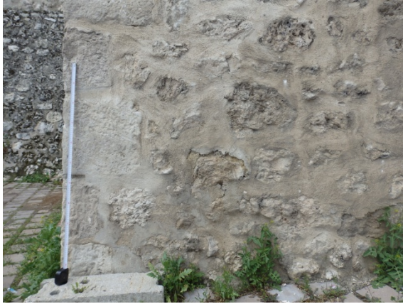
Fig. 5.2.89. Base de la torre T6 de la puerta de San Martín (P3). La esquina se resuelve con sillares. [A.S.E. 12/5/2016].
