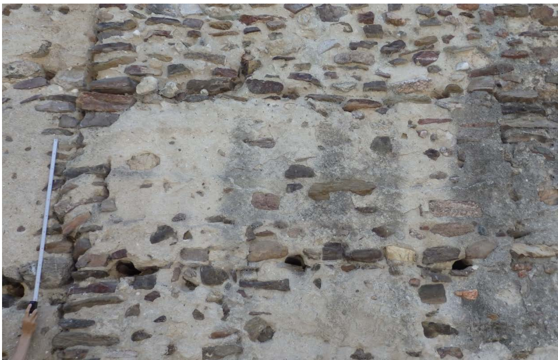
Fig. 5.1.50. Tapia T3.5 de la parte D1. Son visibles sus límites y otros elementos constructivos. Se pueden ver tres mechinales en la base del bloque. Son levemente visibles las marcas horizontales de las tablas del tapial en la zona izquierda de la tapia [A.S.E. 27/4/2015].
