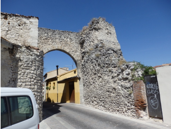
Fig. 5.2.63. Puerta de San Andrés vista desde el interior [A.S.E. 20/8/2014].
