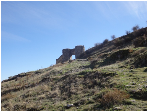
Fig. 5.6.9. Vista de la puerta de la Fuerza desde el exterior del recinto amurallado [A.S.E. 11/11/2015].
