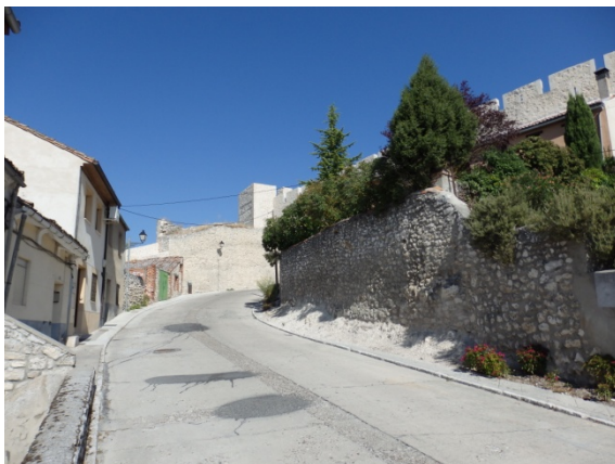
Fig. 5.2.45. Vista del lienzo P4-P5 desde la calle de las Cuevas [A.S.E. 20/8/2014].
