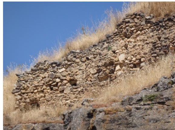
Fig. 5.5.26. Tramo L2 [A.S.E. 24/7/2016].
