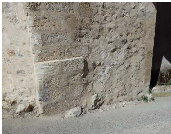
Fig. 5.3.73. Base de estribo E2 de la puerta de la Calzada [A.S.E. 08/07/2015].
