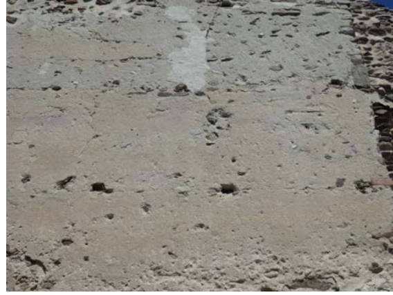
Fig. 5.1.35. Tapia de mampostería [A.S.E. 14/8/2016].
