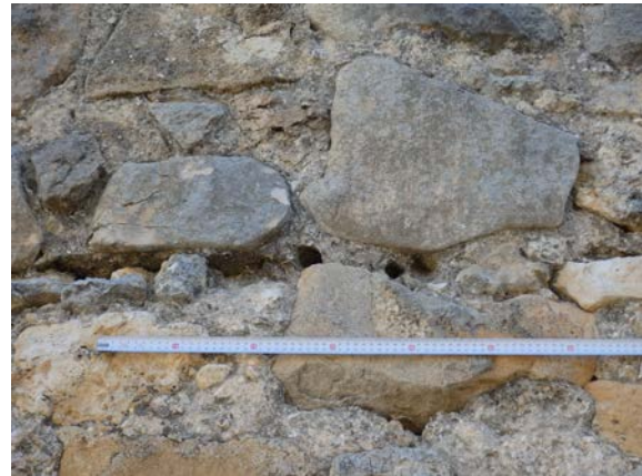
Fig. 5.3.94. Mechinal de varillas pareadas en tapia T5.9 [A.S.E. 23/7/2016].
