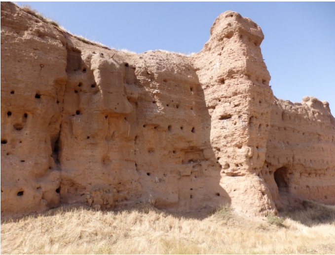
Restos de muralla en la zona alta del núcleo.
