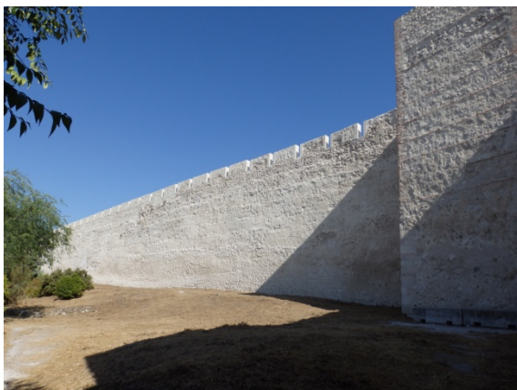
Fig. 5.2.53. Tramo T9-P6 visto desde el exterior del recinto [A.S.E. 20/8/2014].
