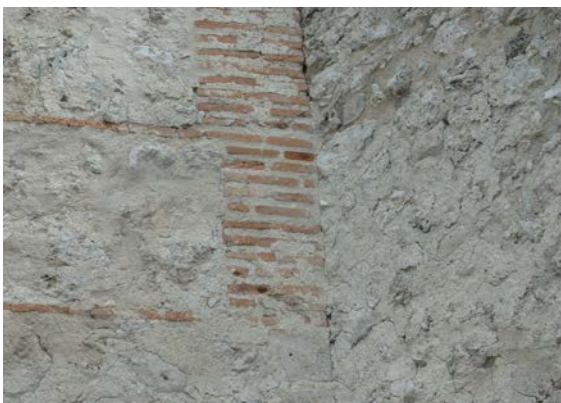
Fig. 5.2.87. Tapia mixta con verdugada simple en torre T9 [A.S.E. 12/5/2016].
