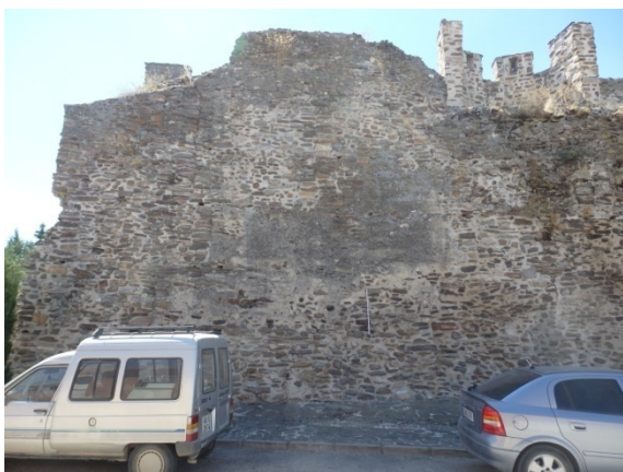
Fig. 5.1.30. Vista interior del lienzo T4-noroeste [A.S.E. 13/8/2016].
