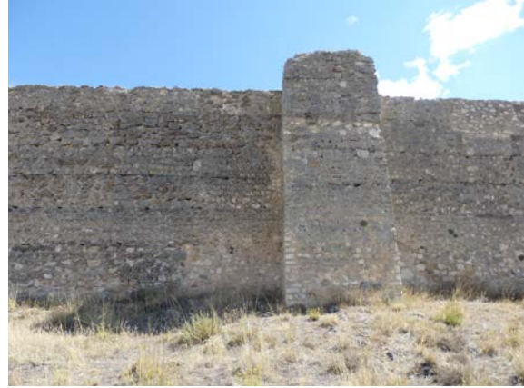
Fig. 5.3.61. Torre T10 [A.S.E. 13/8/2014].
