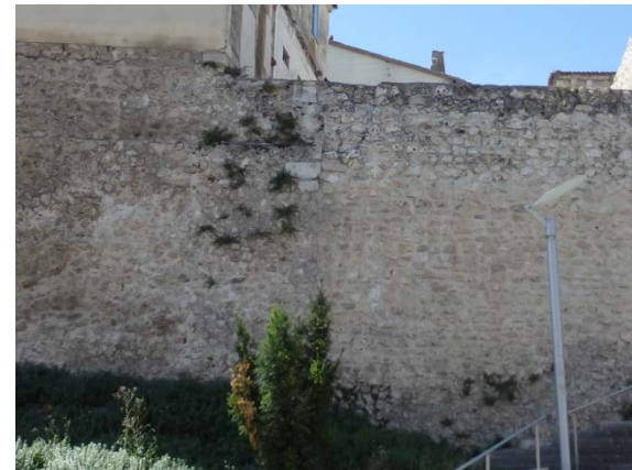
Fig. 5.2.68. Discontinuidad vertical en el tramo de muralla, visible desde el exterior a la
