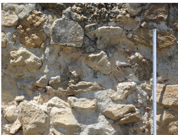
Fig. 5.5.41. Mampostería en tramo P1-T2 [24/7/2016].
