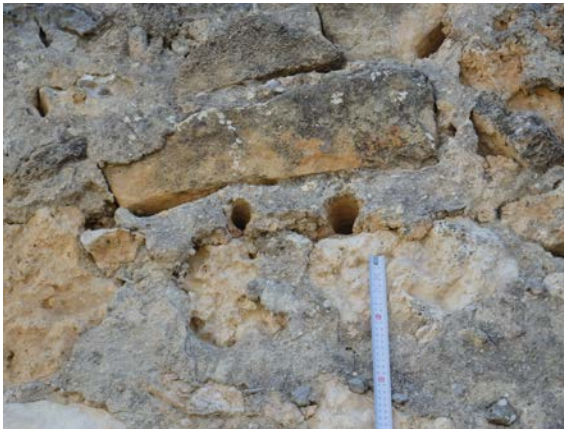
Fig. 5.3.93. Mechinal de varillas pareadas en tapia T4.7 [A.S.E. 23/7/2016].
