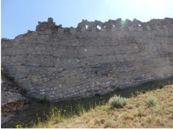
Fig. 5.3.38. Tramo al sur de la torre T5, visto desde el exterior. Se ven tapias de forma trapezoidal o en cuña [A.S.E. 17/6/2014]
