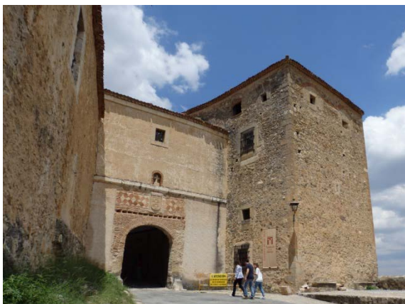
Fig. 5.5.11. Puerta de la villa vista desde el exterior. A la derecha se adosa un volumen rectangular en sentido perpendicular [A.S.E. 5/7/2014].
