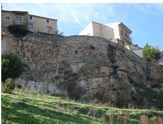
Fig. 5.5.35. Lienzo de muralla a la altura de la parcela Matadero 7 [A.S.E. 18/11/2015].
