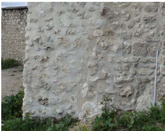
Fig. 5.2.95. A la izquierda, aspecto de parte reconstruida de la muralla. A la derecha, muralla original. En el centro, línea vertical irregular que separa [A.S.E. 12/5/2016].
