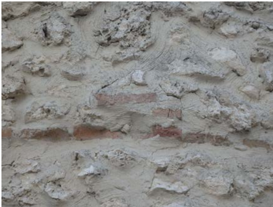
Fig. 5.2.21. Mechinal de ladrillo en la torre T3, ubicado sobre la verdegada [A.S.E. 20/8/2014].
