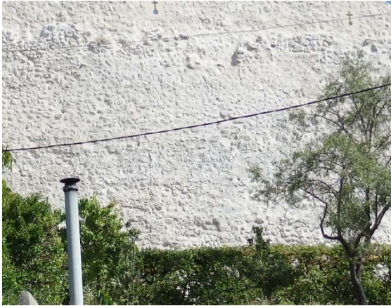
Fig. 5.2.47. Parte original del tramo P4-P5 [A.S.E. 20/8/2014].
