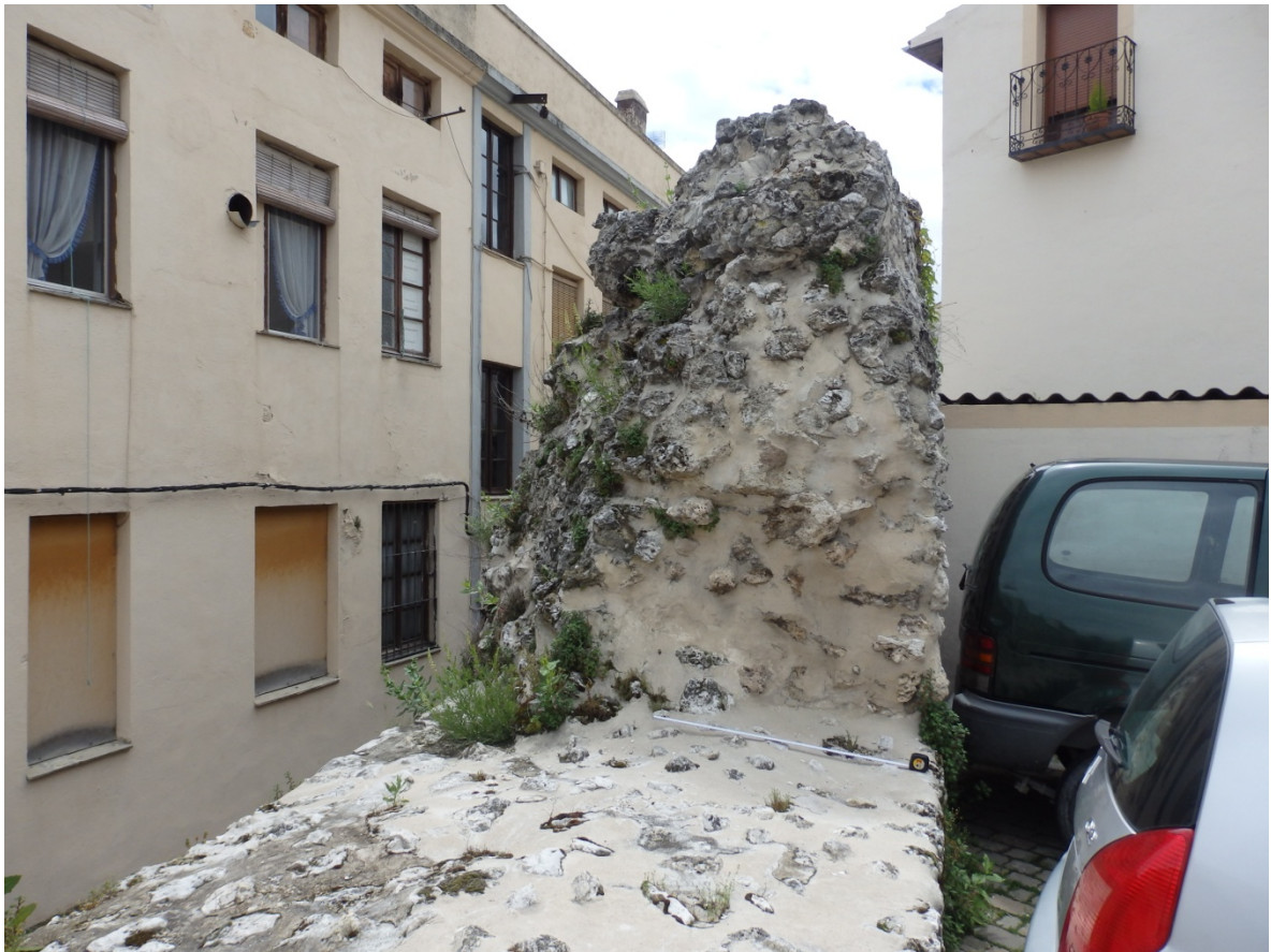
Fig. 5.2.121. Elemento E2 del tramo P9-P10. El metro marca la distancia de 1,00m. La anchura del muro en este punto es de 2,04m [A.S.E. 12/5/2016].
