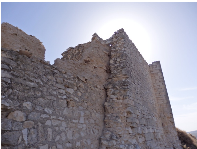
Muro adosado a un muro anterior en zona oeste.
