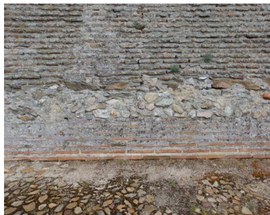
Fig. 5.1.8. Restos de aparejos de mampostería en la base del muro del castillo [A.S.E. 11/2/2016]
