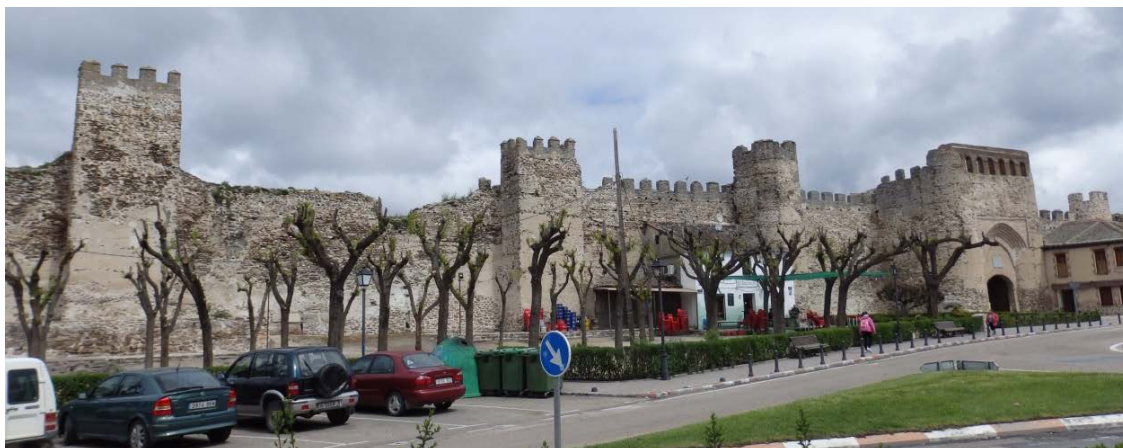
Fig. 5.1.10. Tramo sur de la muralla medieval [A.S.E. 27/04/2015].
