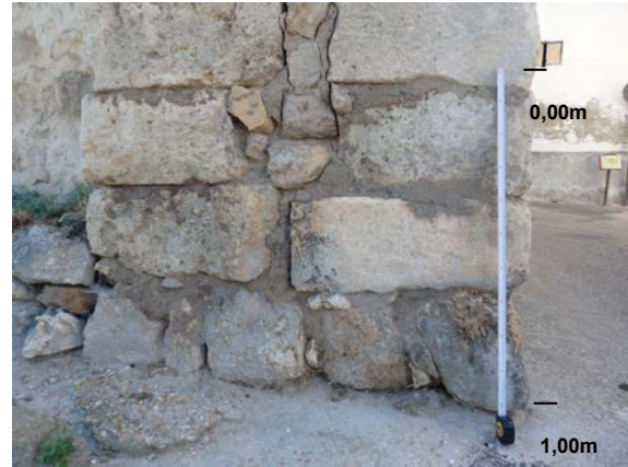
Fig. 5.3.81. Fábrica de sillería en la puerta de Palacio [A.S.E. 17/6/2014].
