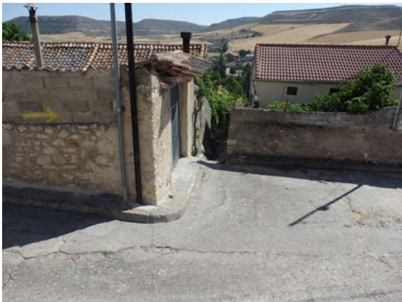
Fig. 5.3.5. Acceso al portillo [A.S.E. 8/7/2015].
