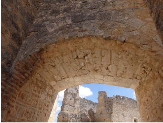
Fig. 5.3.56. Detalle de la bóveda de acceso de la puerta de Alfonso VIII (P3) [A.S.E. 13/8/2014].
