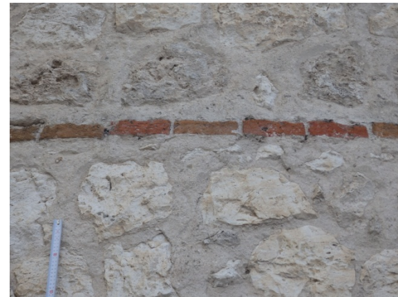
Fig. 5.2.86. Detalle de la verdugada de ladrillo en torre T1b [A.S.E. 12/5/2016].
