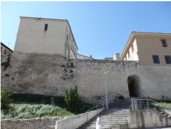
Fig. 5.2.67. Puerta de la calle Nueva [A.S.E. 20/8/2014].
