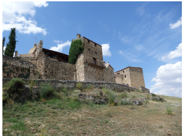
Tramo de muralla junto a la puerta de la Villa
