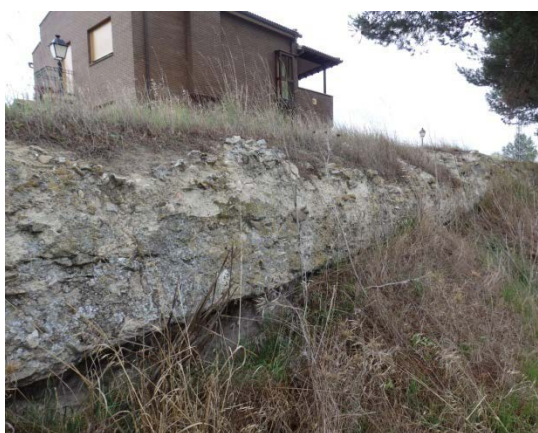
Fig. 5.1.16. Tramo L2 de muralla visto desde el oeste [A.S.E. 11/02/2014].
