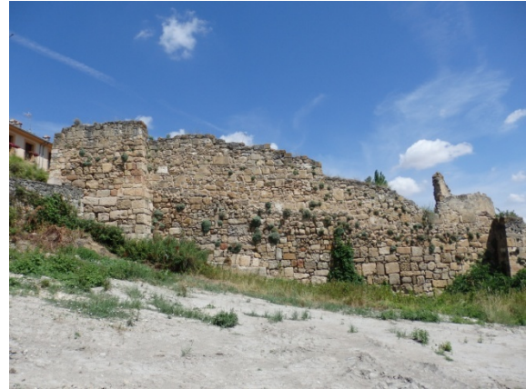
Fig. 5.6.27. Lienzo T1-T2 en la zona del Postiguillo [A.S.E. 5/7/2014].
