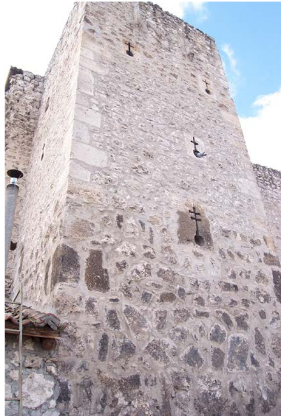
Fig. 5.2.40. Torre T7. Saetera singular en la zona inferior. Fuente: Fernando Nieto Criado y Jesús Nieto Criado [13/3/2001].
