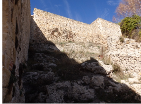
Fig. 5.5.20. Vista exterior de la torre T3 [A.S.E. 18/11/2015].
