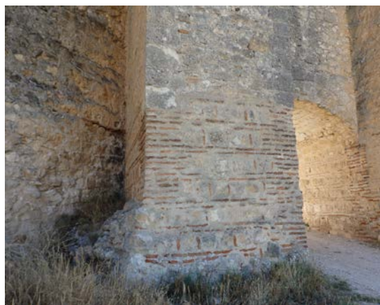
Fig. 5.3.55. Base de la torre T13, desde el exterior [A.S.E. 8/7/2015].
