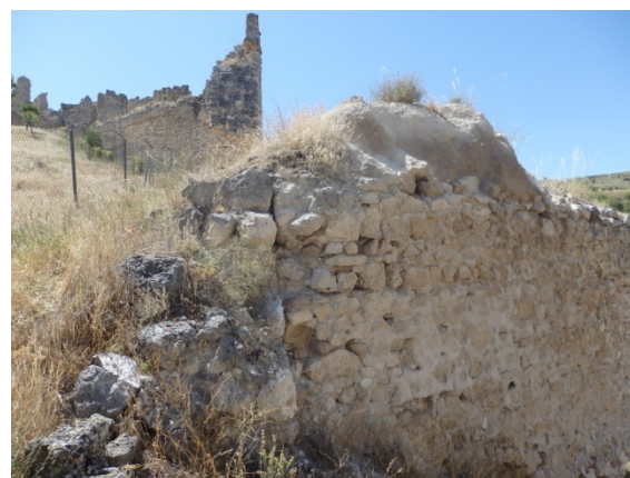
Fig. 5.3.33. Detalle del encuentro de la torre T4 con la base del lienzo [A.S.E. 8/7/2015].
