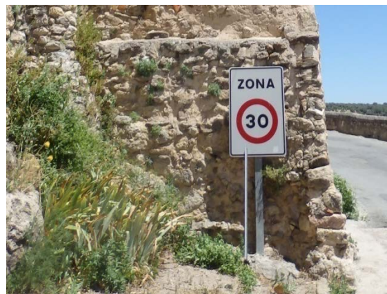
Fig. 5.5.18. Base de la cara suroeste de la torre T2 [A.S.E. 24/7/2016].
