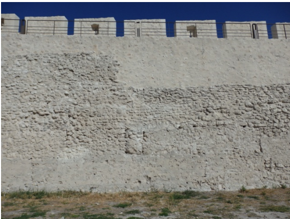
Fig. 5.2.59. Tramo C-T1 visible desde el interior del recinto [A.S.E. 20/8/2014].
