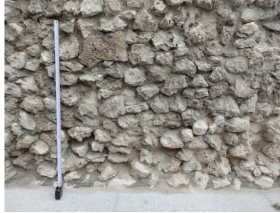
Fig. 5.2.90. Base de mampostería en la puerta de San Andrés (P12) [A.S.E. 12/5/2016].
