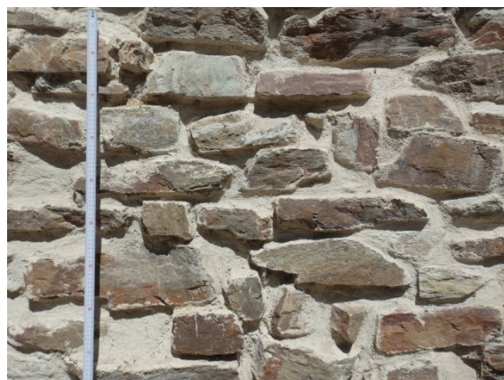
Fig. 5.1.47. Reparación con aparejo de piedras similares en la base del lienzo exterior T1-T2 [A.S.E. 14/8/2016].
