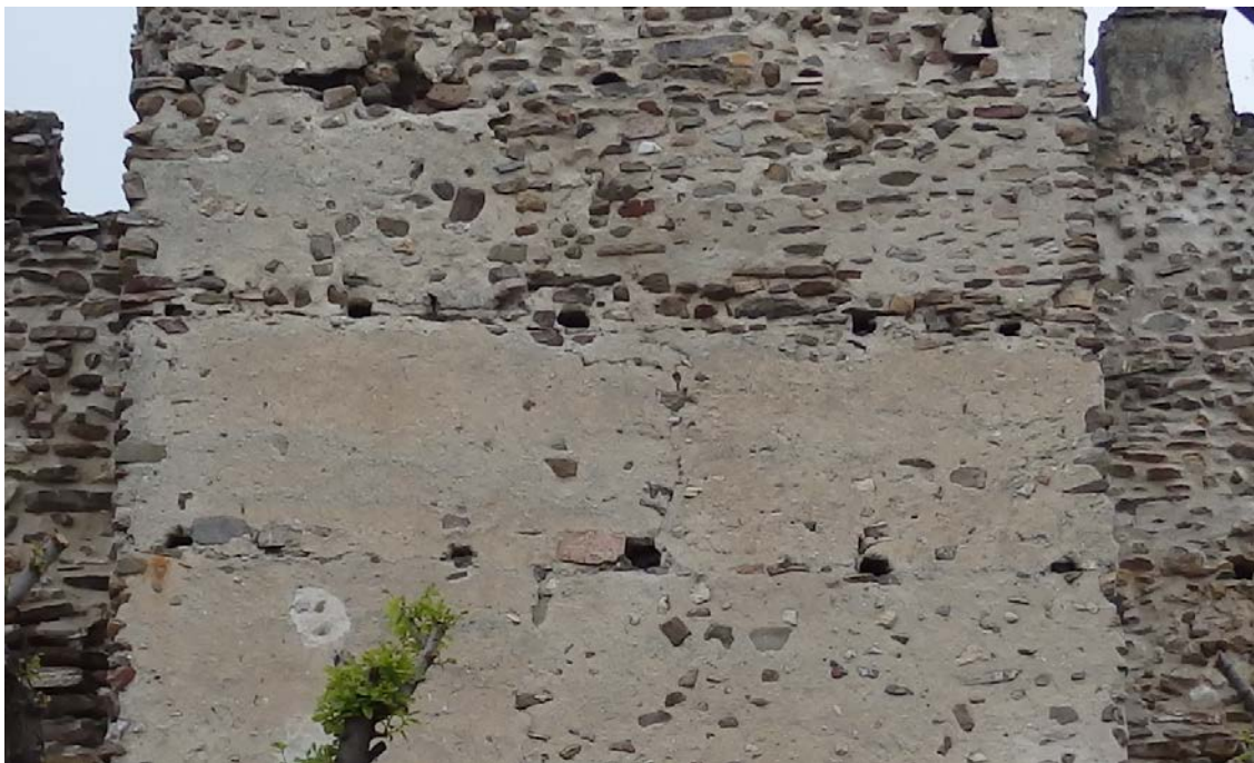
Fig. 5.1.71. Hilada que muestra seis mechinales en el frente de la torre T2 [A.S.E.27/4/2015].
