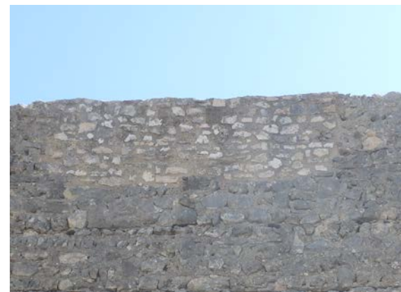
Fig. 5.3.85. Aspecto de la tapia reparada en tramo T10-T11 exterior [A.S.E. 8/7/2015]
