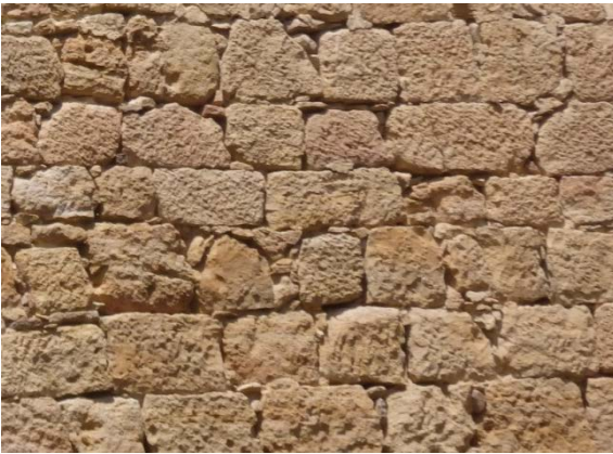
Fig. 5.5.45. Sillería de la torre de Hontanillas [A.S.E. 24/7/2016].
