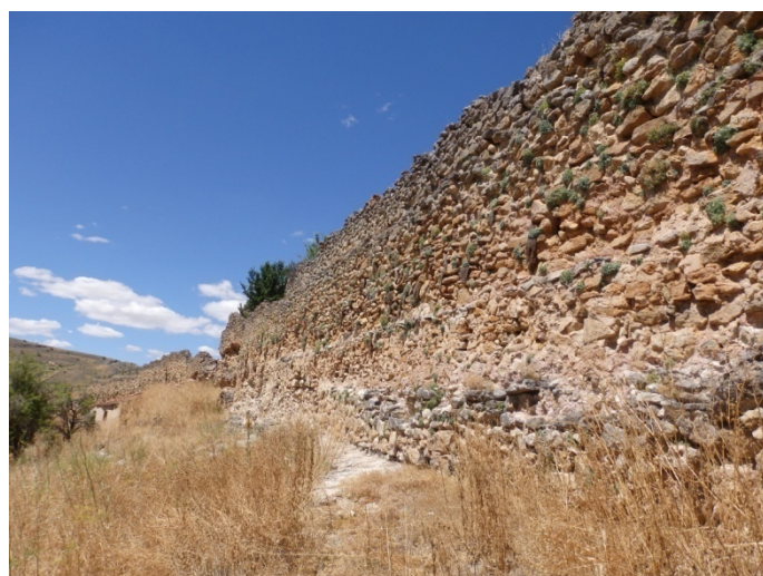
Tramo en zona al este de la puerta de Duruelo
