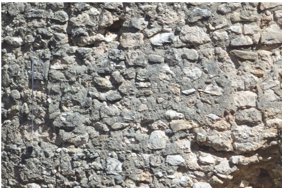
Fig. 5.3.113. Tapia T3.2 de la torre T6 [A.S.E. 23/7/2016].
