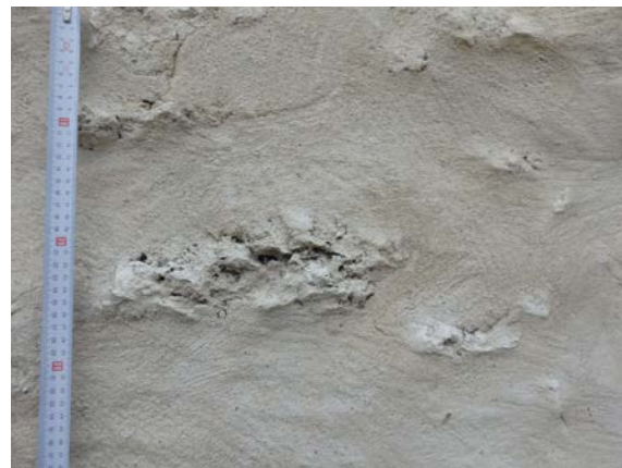
Fig. 5.2.96. Aspecto de una parte restaurada de la muralla, con nuevo mortero sobre las piedras [A.S.E. 12/5/2016].
