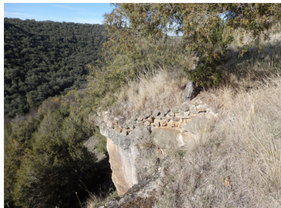
Fig. 5.5.30. Resto L6 en la zona este del núcleo [A.S.E. 18/11/2015].
