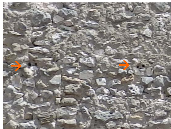
Fig. 5.3.120. Dos mechinales de varillas pareadas en la hilada 5 de la torre T8. Los separa una distancia de 1,07m [A.S.E. 17/6/2014].
