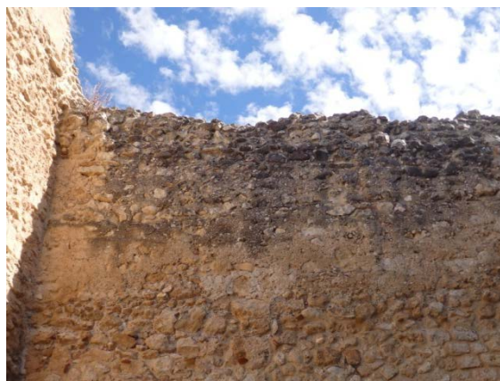
Fig. 5.4.19. Detalle de la parte superior del tramo T1-oeste [A.S.E. 23/7/2016].
