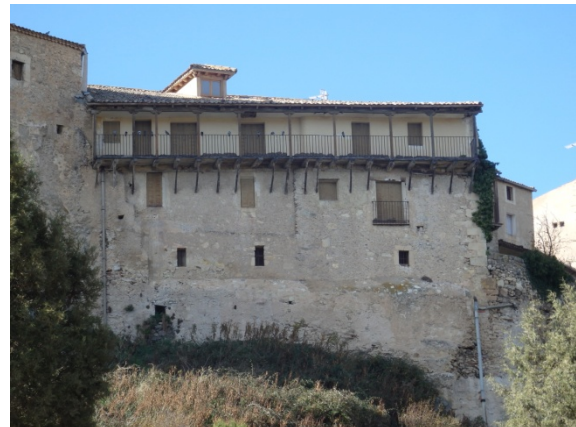
Fig. 5.5.38. Construcciones sobre la muralla junto a la puerta de la villa, hacia el norte [A.S.E. 18/11/2015].
