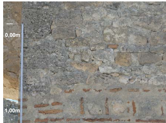
Fig. 5.3.83. Sillarejo en puerta de Alfonso VIII, sobre la base de mampostería encintada [A.S.E. 8/7/2015].
