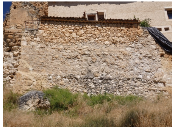
Fig. 5.4.51. Esquina sur del recinto, posible torre T4 [A.S.E. 23/7/2016].
