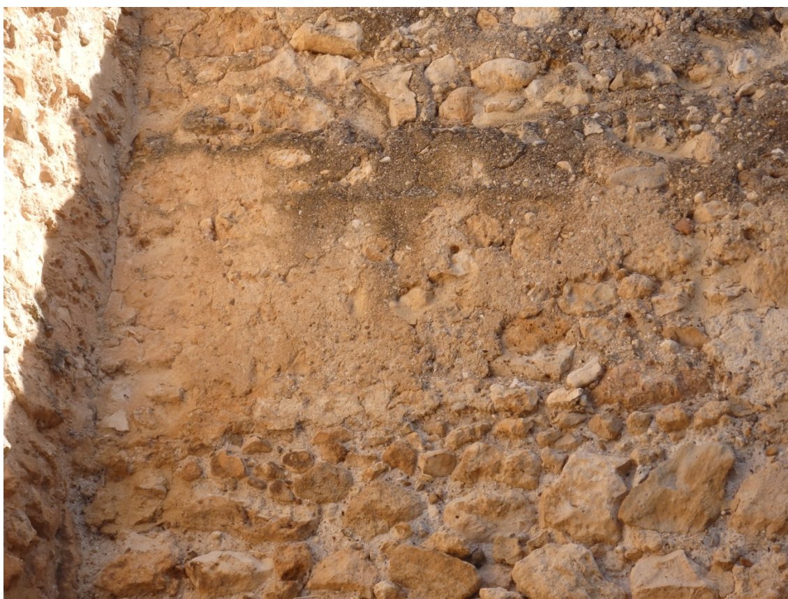
Fig. 5.4.62. Tapia T1.1. con 1,25 m de altura y 2,23 de anchura. Son visibles algunas marcas de la tablazón en la parte superior, ligeramente oscurecida. [A.S.E. 24/7/2016]
