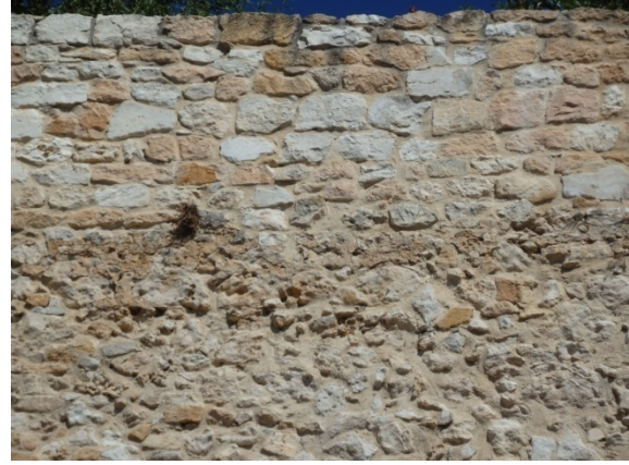
Fig. 5.4.47. Detalle de la parte nueva en sillarejo que se construye sobre una base existente, probablemente de tapia [A.S.E. 23/7/2016]
