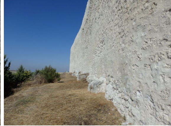
Fig. 5.2.56. Tramo P6-Castillo visto desde el exterior del recinto. En la base se observan rocas sobre las que se construye la muralla [A.S.E. 20/8/2014].
