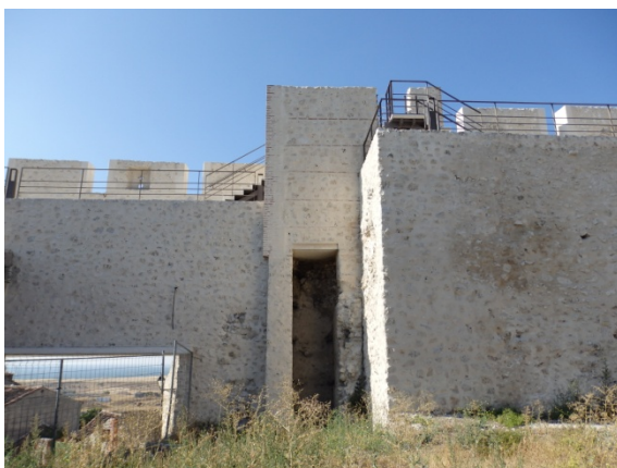
Fig. 5.2.49. Abajo a la izquierda, puerta de las Cuevas vista desde el interior. Se ve la parte interior de la torre T9 [A.S.E. 20/8/2014].
