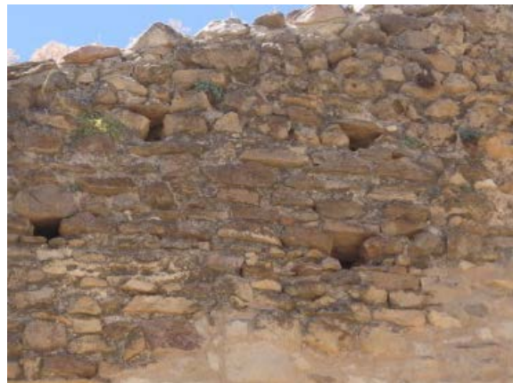
Fig. 5.5.40. Tapia de mampostería con piedras planas [A.S.E 24/7/2016]
