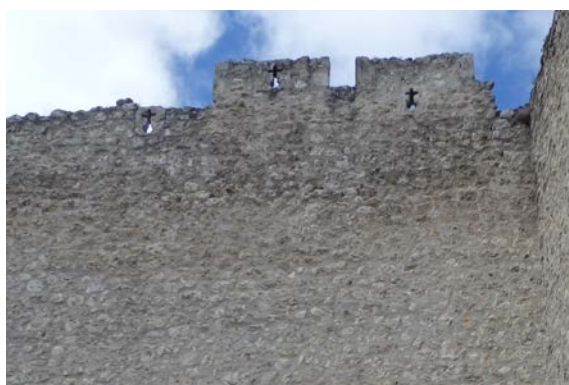
Fig. 5.2.39. Tramo T6-T7, abajo, detalle de la coronación [A.S.E. 20/8/2014].
