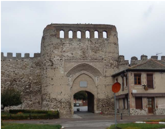
Fig. 6.6. Puerta de la Villa en Coca, de composición simétrica [A.S.E. 2/11/2014].
