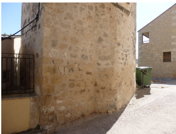
Fig. 5.3.72. Base de estribo E1 de la puerta de la Calzada [A.S.E. 08/07/2015].
