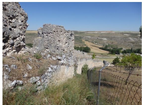
Fig. 5.3.41. Plataforma superior de la torre T7 y parte del adarve [A.S.E. 17/6/2014]
