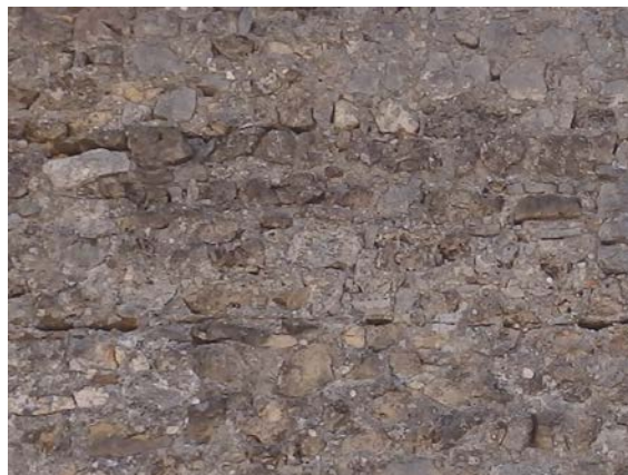
Fig. 5.3.77. Tapia de mampostería en la cara exterior del tramo T14-T11, el color es grisáceo [A.S.E. 13/8/2014].
