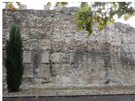
Fig. 5.1.31. Tramo interior de la muralla, a la altura de la torre T2. Se observa la tapia empleada en la construcción [A.S.E. 27/4/2015].
