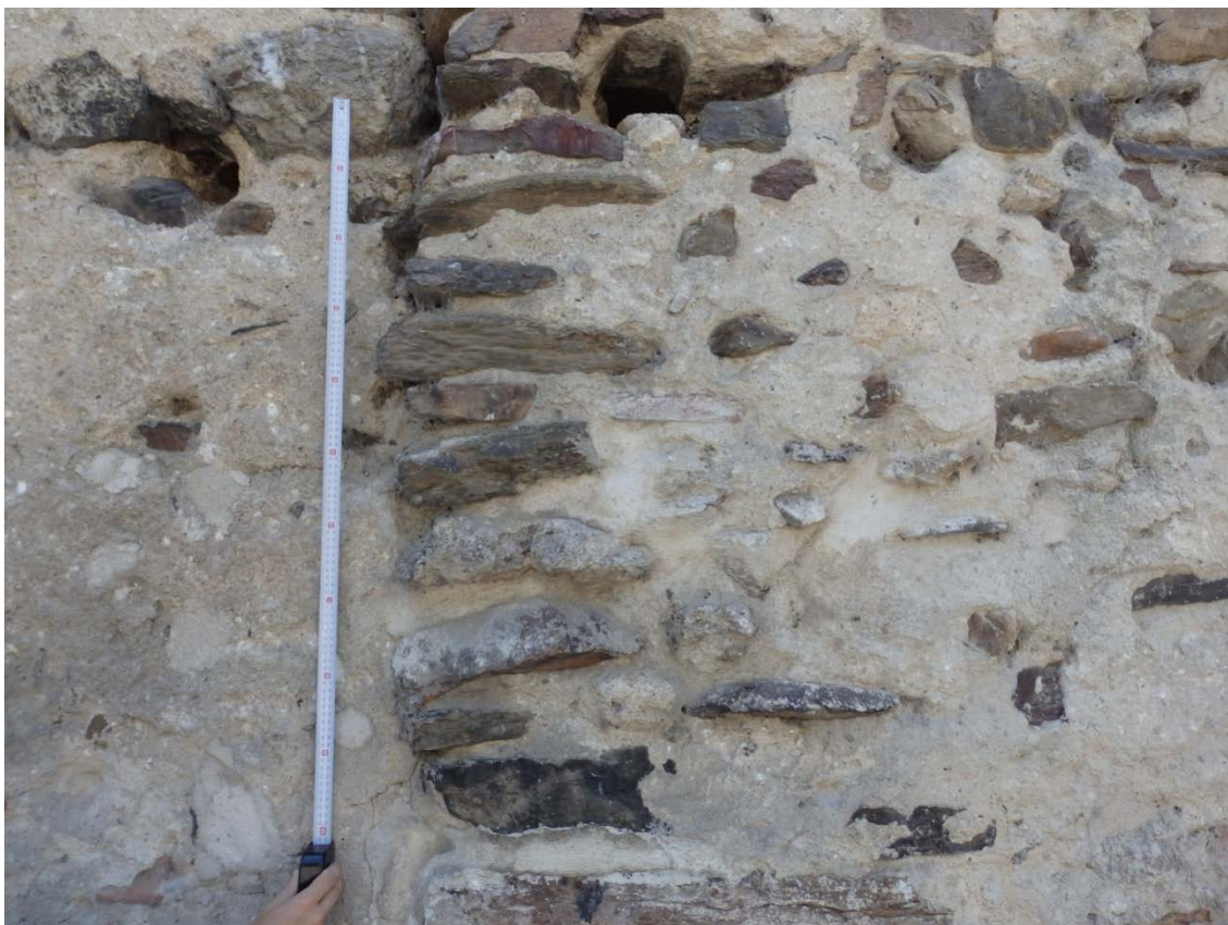
Fig. 5.1.52. Murete de piedras que cierra un lateral de la tapia T2.5 [A.S.E. 13/8/2016].
