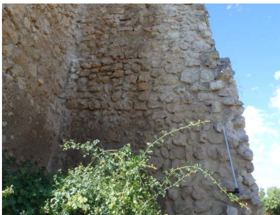
Fig. 5.4.36. Interior de la torre T2 [A.S.E. 23/7/2016].
