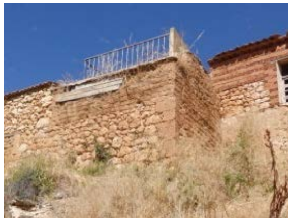
Fig. 5.4.43. Esquina que podría ser una antigua torre [A.S.E. 23/7/2016].
