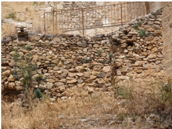
Fig. 5.5.25. Tramo L1 [A.S.E. 24/7/2016].
