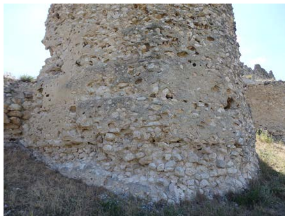
Fig. 5.3.31. Base de la torre T3, que se adosaría al lienzo hoy desaparecido. [A.S.E. 17/6/2014].
