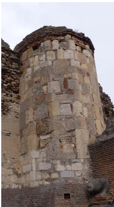
Fig. 6.32. Torre T8 en Coca [A.S.E 2/11/2014].
