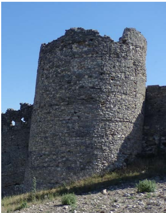
Fig. 6.16. Torre T6 de Fuentidueña [A.S.E. 17/6/2014]
