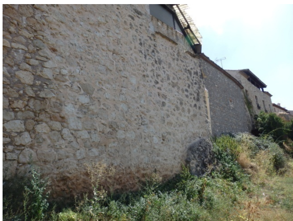
Fig. 5.4.30. Base de muro en el tramo P2-T2 [A.S.E. 3/9/2014].
