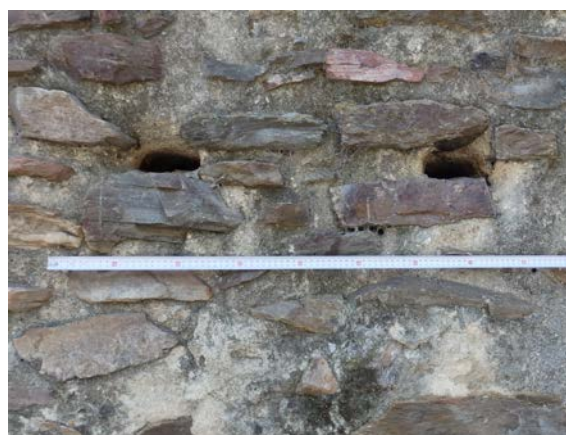
Fig. 5.1.57. Mechinales adyacentes de las tapias T3.2 y T3.3 [A.S.E. 13/8/2016].
