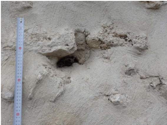
Fig. 5.2.114. Mechinal M2 que conserva la aguja de madera en su interior, situado en tramo P6-T9, visible desde la zona interior [A.S.E. 12/5/2016].
