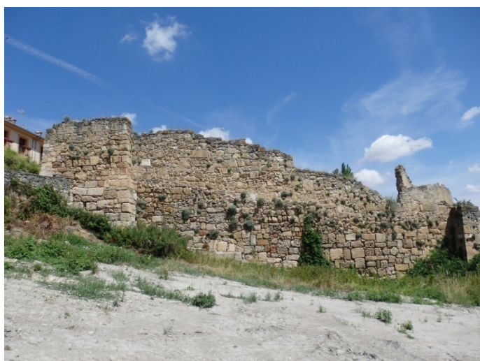
Tramo en zona del Postiguillo
