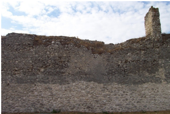
Fig. 5.2.4. Alzado interior de lienzo donde se aprecian las restauraciones en la base del muro. Fuente: Fernando Nieto Criado y Jesús Nieto Criado [10/8/2005].
