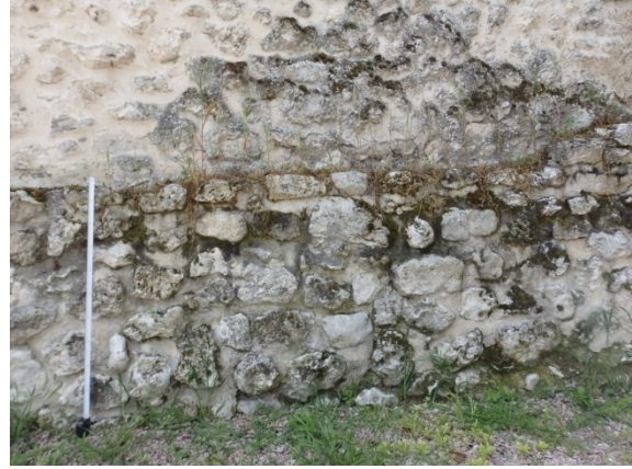
Fig. 5.2.78. Detalle de la base del muro. A la izquierda, el metro marca la longitud de 1,00m [A.S.E. 12/5/2016].
