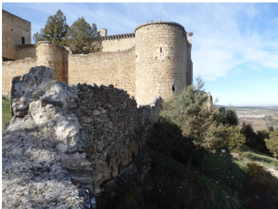
Fig. 5.5.33. Tramo de muralla junto al castillo [A.S.E. 18/11/2015].
