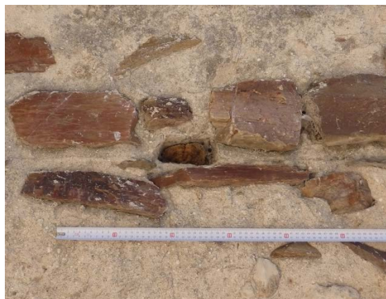
Fig. 5.1.76. Mechinal central de la tapia en la tercera hilada del lateral oeste de la torre T1. La aguja de madera es visible en su interior [A.S.E. 13/8/2016].
