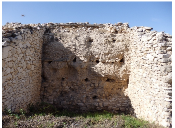
Parte interior de muralla en zona oeste.
