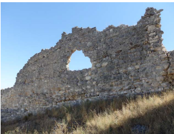
Fig. 5.3.28. Tramo al norte de la torre T3 [A.S.E. 8/7/2015].
