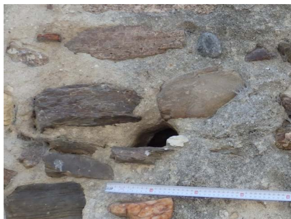
Fig. 5.1.55. Mechinal lateral derecho de la tapia T3.5 [A.S.E. 13/8/2016].
