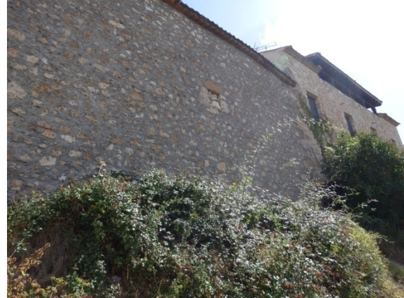
Fig. 5.4.33. Muro de nueva construcción o tal vez reparado de forma muy intensa mediante la aplicación de mortero de cemento.
