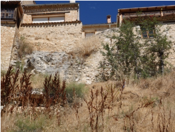
Fig. 5.4.48. Restos de muralla medieval en las bases de los muros de la zona sureste [A.S.E. 23/7/2016].
