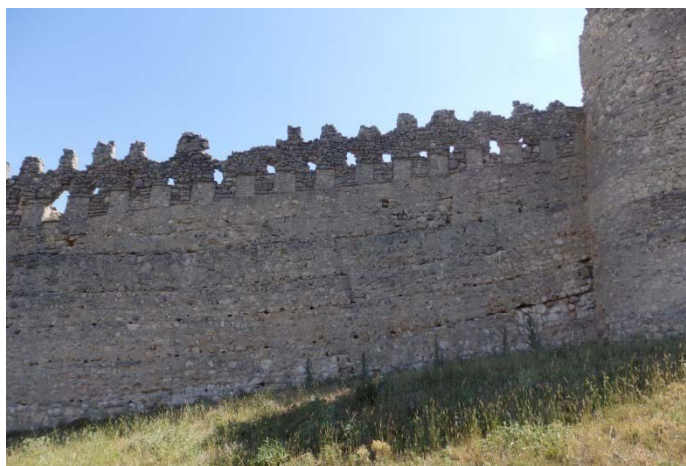
Tramo junto a torre T6 en zona este del recinto
