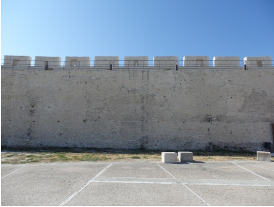
Fig. 5.2.57. Tramo del muro P6-Portillo nuevo visto desde el interior [A.S.E. 20/8/2014].
