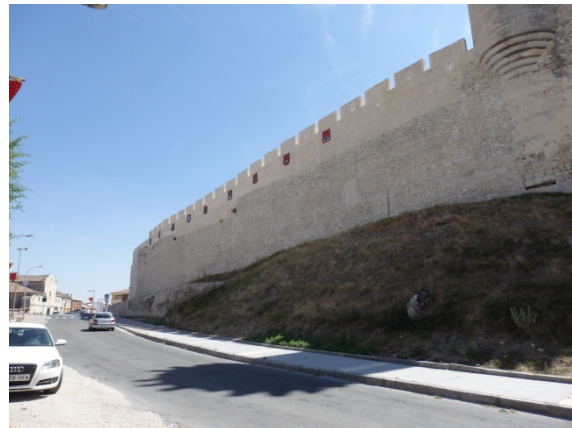
Fig. 5.2.60. Tramo C-T1 desde el exterior del recinto [A.S.E. 20/8/2014].
