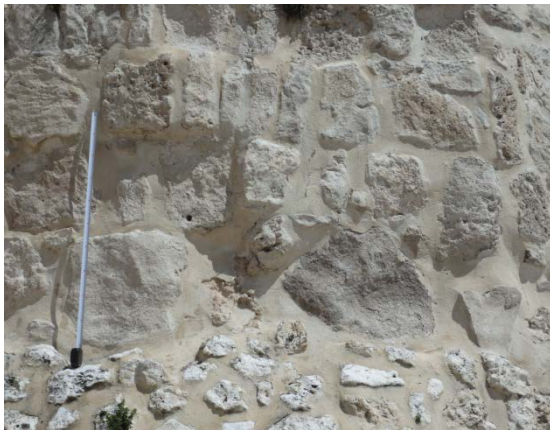
Fig. 5.2.93. Aparejo singular en la base de la torre de Santiago (P4) [A.S.E. 12/5/2016].
