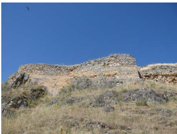
Fig. 5.3.64. Tramo T12-sur en la zona este del recinto [A.S.E. 08/07/2015].
