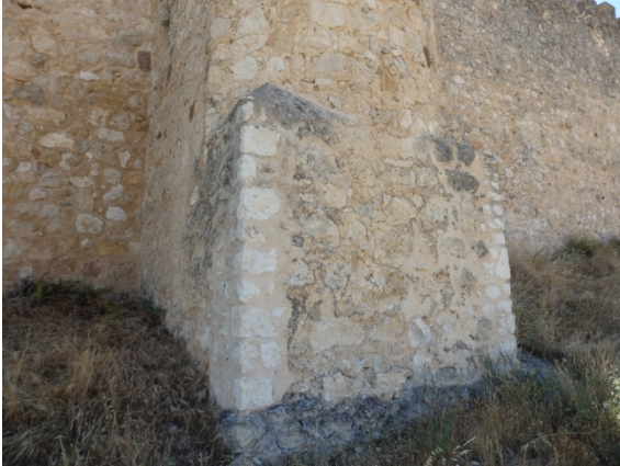
Fig. 5.3.26. Detalle de la base de la torre T1 [A.S.E. 8/7/2015]
