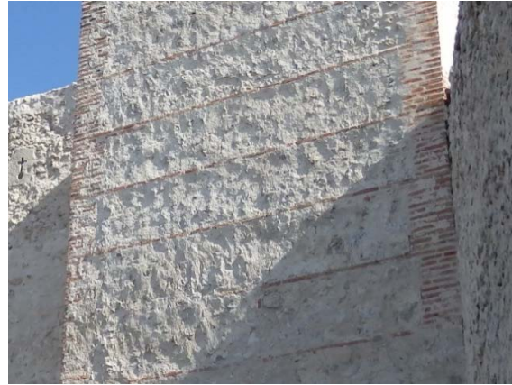
Fig. 5.2.52. Verdugadas de ladrillo y machones en la torre T9 [A.S.E. 20/8/2014].
