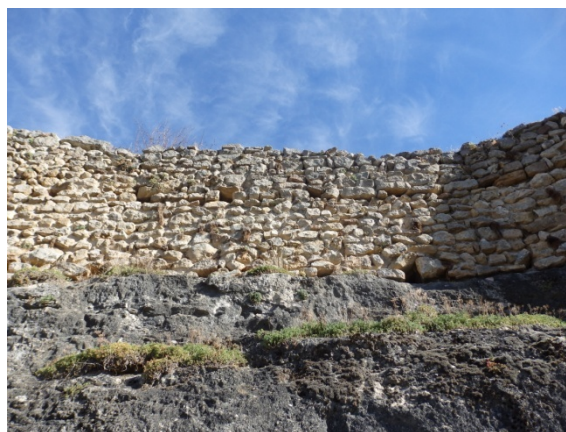
Fig. 5.6.46. Detalle del tramo de muralla junto a la puerta de Castro. Son visibles los mechinales y las dos hiladas de tapias [A.S.E. 11/11/2015].
