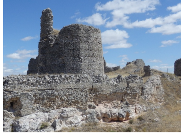
Fig. 5.3.45. Torre sur del castillo [A.S.E. 13/8/2014].
