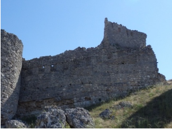
Fig. 5.3.44. Tramo desde la torre T7 hacia el sureste [A.S.E. 17/6/2014].
