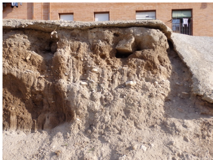
Tramo en la calle Ronda
