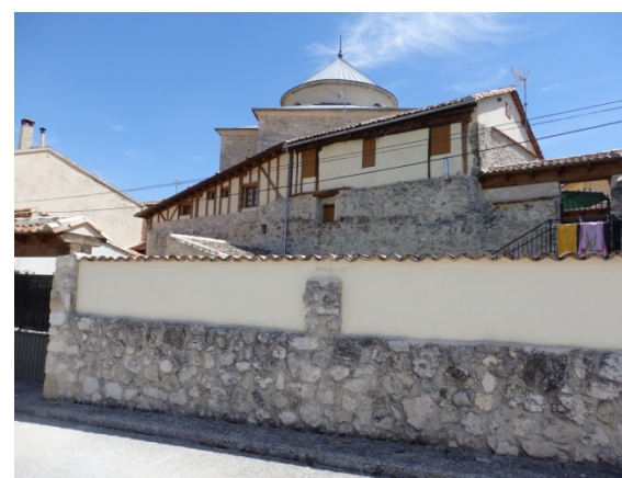
Fig. 5.3.19. Lienzo de muralla en interior de la parcela, que forma parte de la edificación (A.S.E. 13/08/2014).
