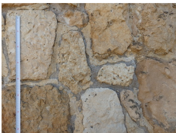
Fig. 5.4.54. Sillería irregular en la base de la cara sur de la torre del Oeste [A.S.E. 23/7/2016]
