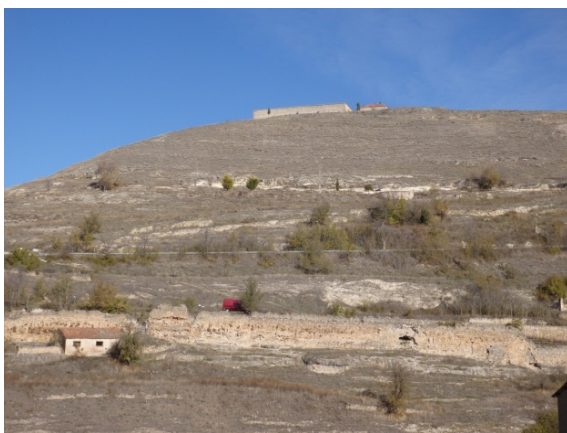
Fig. 5.6.7. Vista de la muralla en la base del cerro [A.S.E. 11/11/2015].
