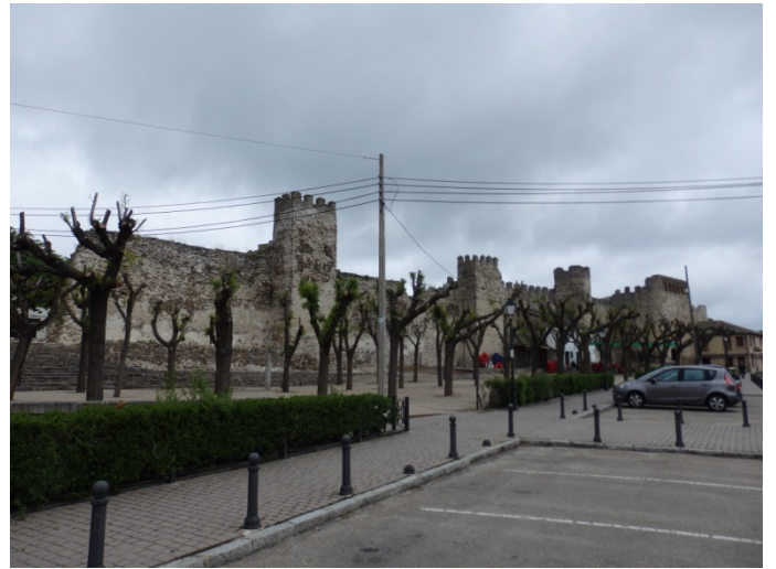
Tramo de muralla en zona sur.
