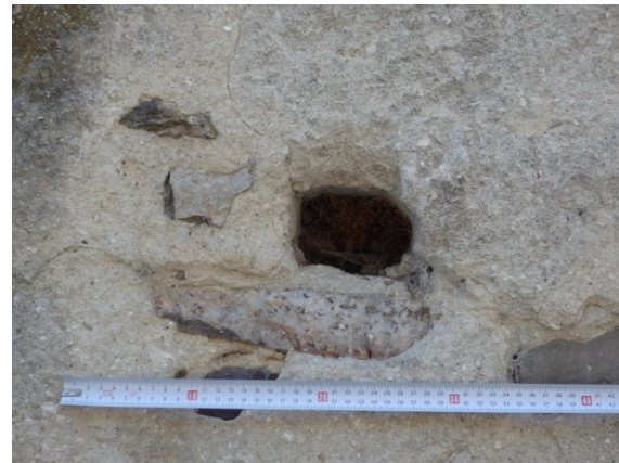
Fig. 5.1.65. Mechinal M3.1 en la zona D3. Su ubicación respecto de otras tapias es visible en Fig. 5.1.63 [A.S.E. 13/8/2016].
