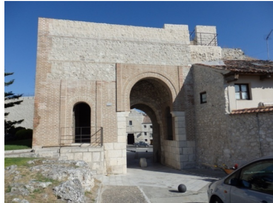
Fig. 5.2.20. Puerta de San Basilio P1 desde el interior del recinto [A.S.E. 20/8/2014].
