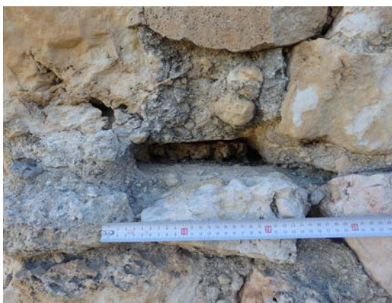
Fig. 5.3.100. Mechinal M2.1 del tramo D2 en T5-T6 [A.S.E. 23/7/2016].
