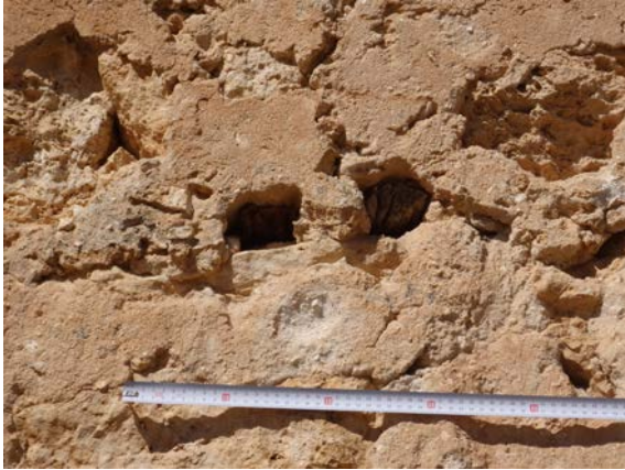
Fig. 5.3.110. Mechinal con dos agujas, situado a caballo entre las tapias T4.4. y T4.3 [A.S.E. 23/7/2016]
