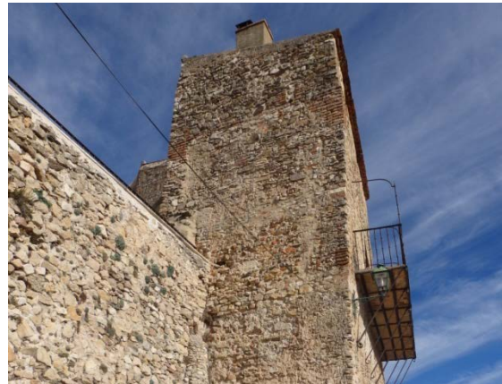
Fig. 5.5.16. Vista suroeste de la Torre T2 [A.S.E. 18/11/2015].
