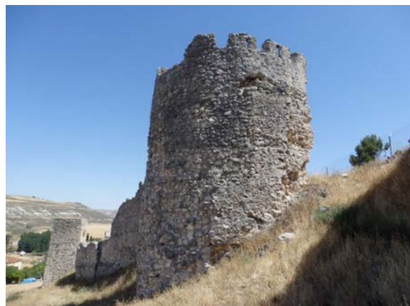
Fig. 5.3.29. Cara sur de la Torre T3. Al fondo, la torre T2 [A.S.E. 8/7/2015].
