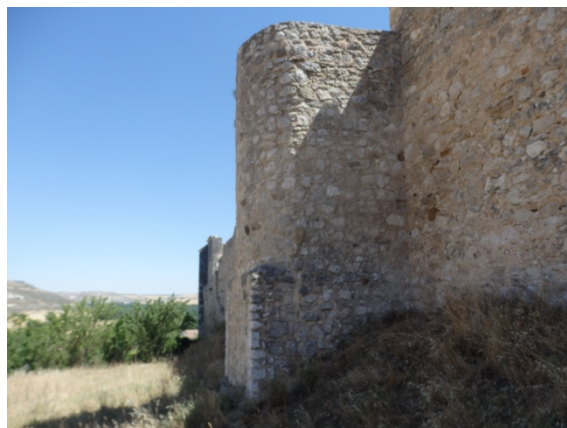
Fig. 5.3.25. Torre T1 [A.S.E. 8/7/2015].
