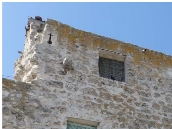
Fig. 5.2.30. Saetera visible desde la calle de la Judería. También se ve una ménsula [A.S.E. 20/8/2014].
