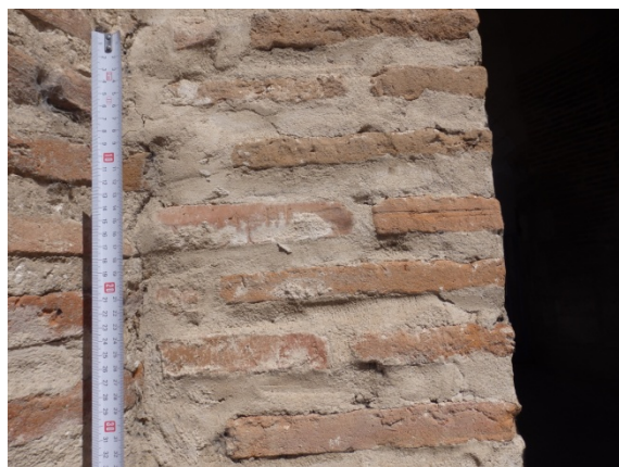
Fig. 5.1.38. Fábrica de ladrillo en el estribo izquierdo del arco de acceso de la puerta de la Villa, en su cara exterior [A.S.E. 14/8/2016].
