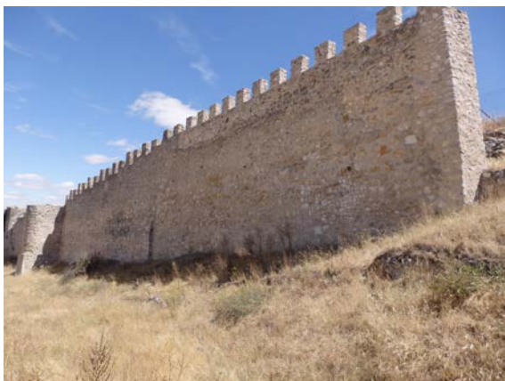
Fig. 5.3.24. Tramo T1-sur [A.S.E. 13/8/2014].
