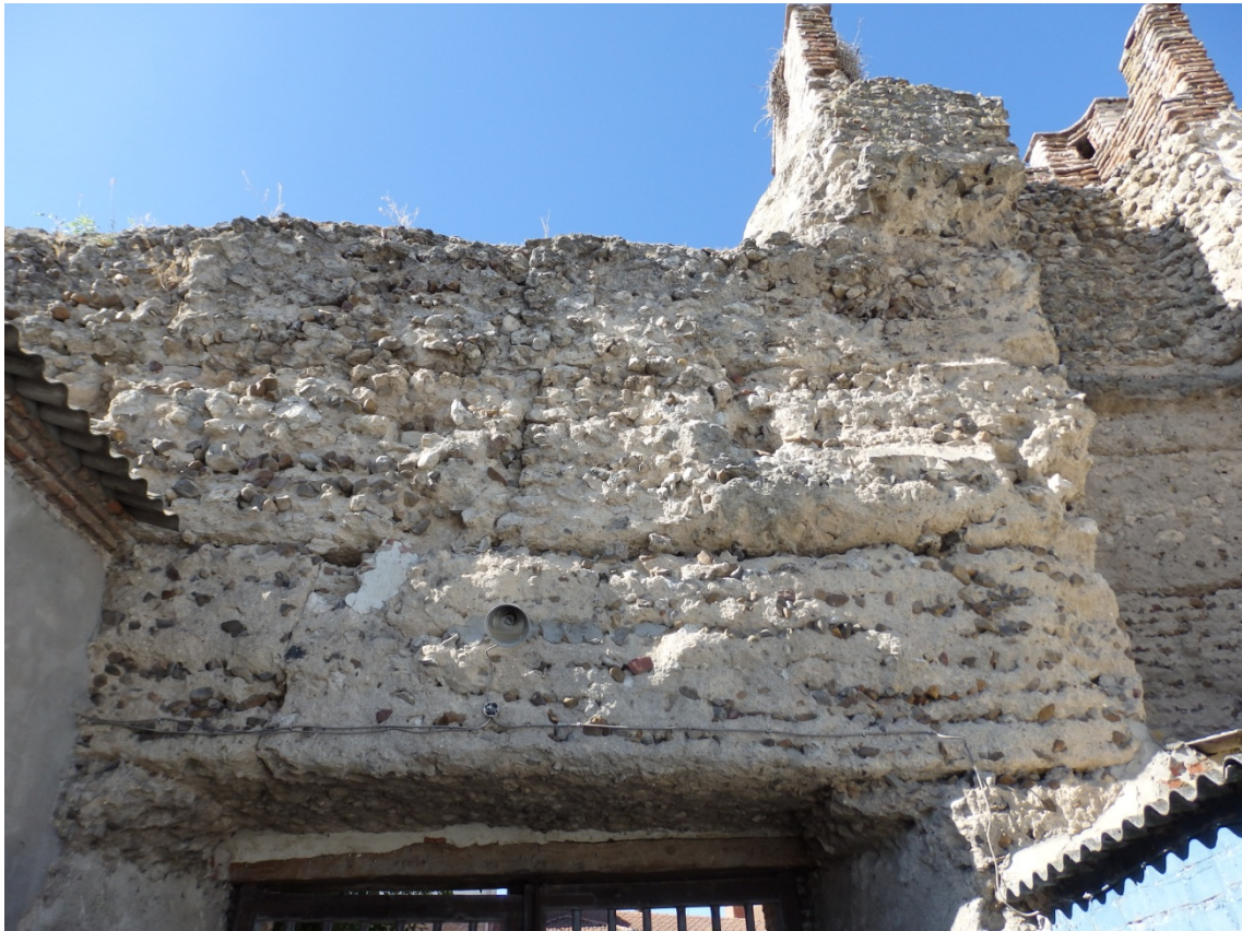
Fig. 6.42. Tapia de cal y canto en Olmedo. Se observa una colocación de los cantos rodados por hiladas [A.S.E. 1/9/2014].
