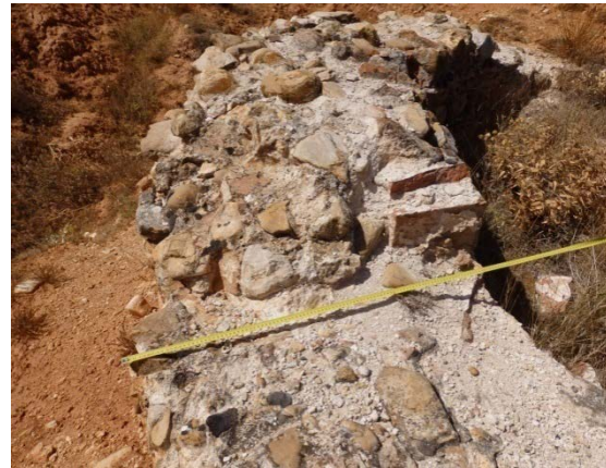
Fig. 6.31. Sección del muro, donde se ve uno de los ladrillos que encintan por la cara interior en Fresno de Cantespino [A.S.E 3/9/2014].
