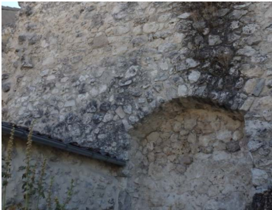
Fig. 5.2.25. Detalle del aparejo de piedra en el lienzo P2-T4. Es visible un arco cegado en la base del lienzo [A.S.E. 20/8/2014].
