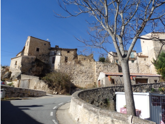
Fig. 5.6.13. Restos de muralla junto a la puerta del Río. Es visible la torre T17 que sobresale ligeramente del plano del lienzo [A.S.E. 11/11/2015].
