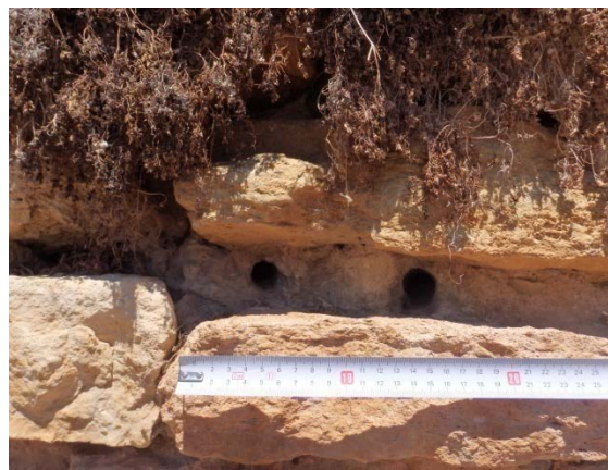
Fig. 5.6.72. Mechinal de varillas pareadas, con una separación de 9cm. [A.S.E. 23/7/2016]
