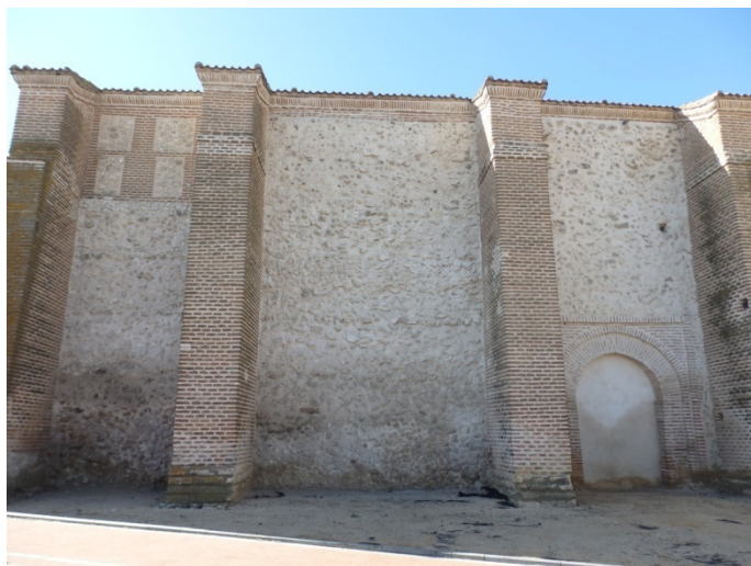
Lienzo de la muralla reutilizado en muro norte de Iglesia de San Miguel.
