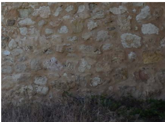
Fig. 5.3.84. Aspecto de la tapia reparada en tramo T1-sur [A.S.E. 17/6/2014]
