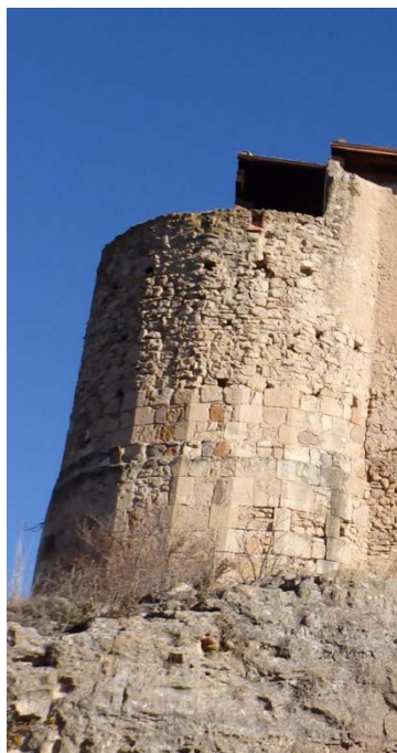
Fig. 6.33. Torre T81 en el recinto amurallado de Segovia [A.S.E 30/12/2014].
