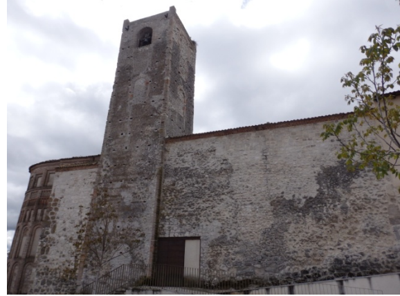
Fig. 5.2.32. Fachada norte de la iglesia de San Esteban [A.S.E. 12/5/2016].
