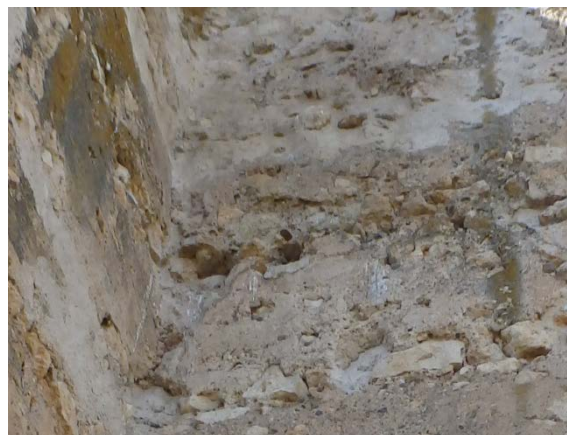
Fig. 5.4.37. Posibles mechinales en la base de la tapia [A.S.E. 23/7/2016]
