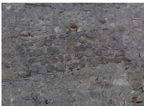
Fig. 5.3.78. Tapia T6.4 con mampostería de gran tamaño en la zona T5-T6. Se observan hiladas de piedra dentro de la tapia. Las dimensiones de la tapia son 2,81x1,17m [A.S.E. 17/6/2014].
