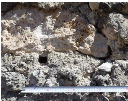
Fig. 5.3.114. Mechinal en la tapia vecina a T3.2, a su izquierda [A.S.E. 23/7/2016].
