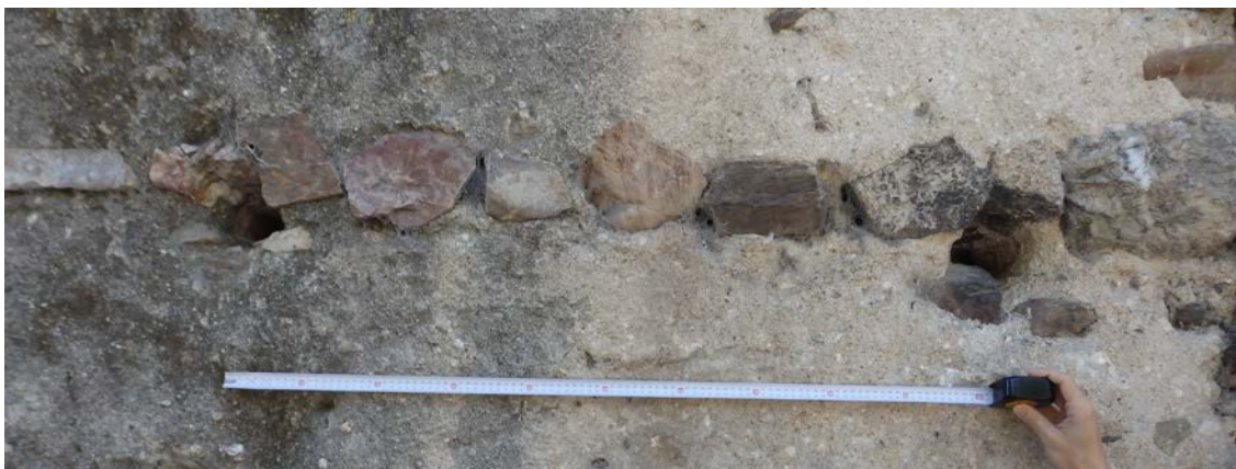
Fig. 5.1.51. Verdugada de piedra en la base de la tapia T3.4 [A.S.E. 14/08/2016]
