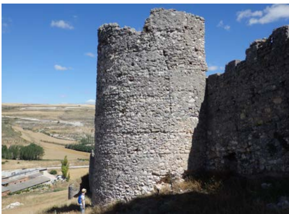
Fig. 5.3.40. Torre T6 vista desde el sureste [A.S.E. 23/7/2016].
