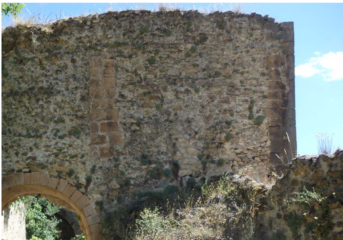
Fig. 5.6.80. Cara norte de la torre T21 [A.S.E. 23/7/2016].
