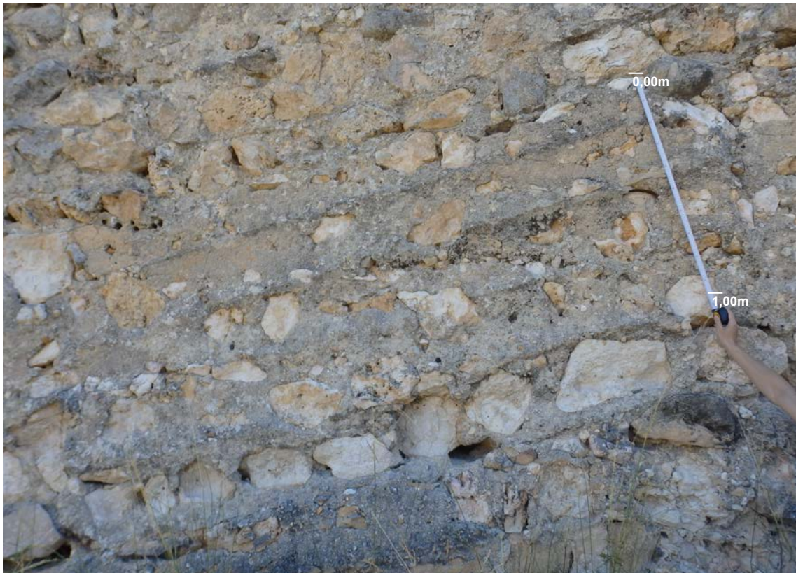
Fig. 5.3.88. Tapia T2.2 (3,08m x 1,35m). El metro marca la longitud de 1,00m [A.S.E. 23/7/2016].
