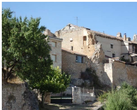
Fig. 5.4.5. Vista de la esquina sur [A.S.E. 3/9/2014].
