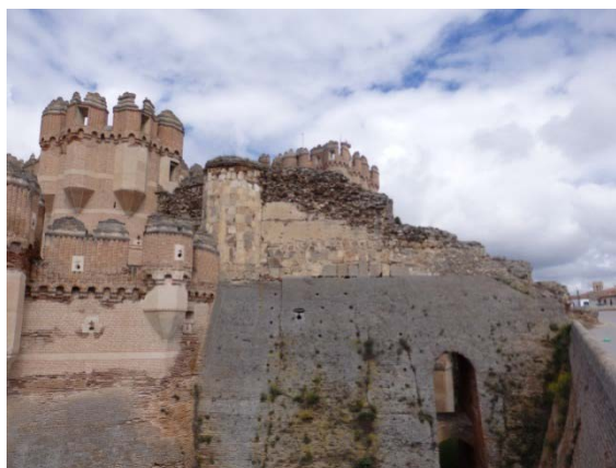
Fig. 5.1.11. Tramo medieval adosado al castillo, visible desde el exterior del castillo. Bajo el lienzo se sitúa el foso del castillo [A.S.E. 27/04/2015].
