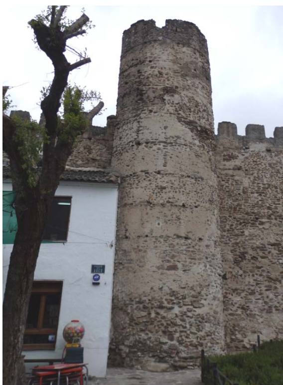
Fig. 5.1.26. Torre T3, con base semicircular. A la izquierda se adosa una edificación [A.S.E. 27/04/2015].
