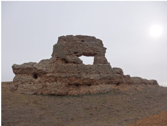
Fig. 1.15. Castro de Torrejón de la Nava, en Nava del Rey, Valladolid. [A.S.E. 20/02/2015]
