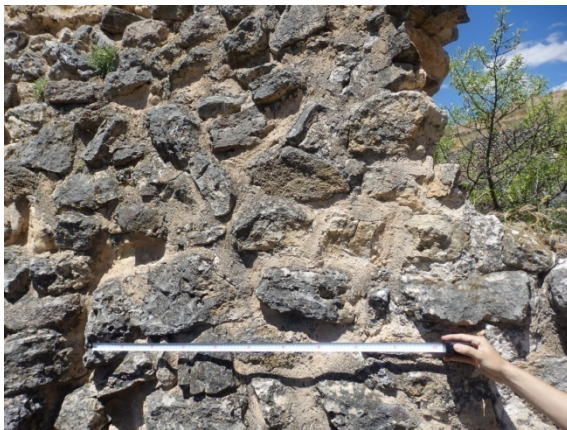
Fig. 5.6.56. Aparejo de piedra en la puerta de Castro. El metro marca la distancia de 1,00m [A.S.E. 23/7/2016].
