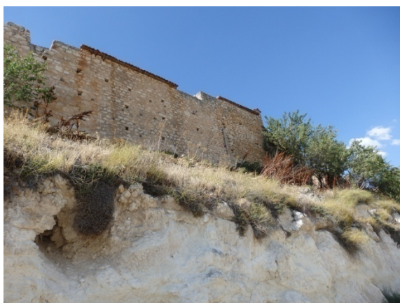
Fig. 5.4.44. Parte reconstruida [A.S.E. 23/7/2016].
