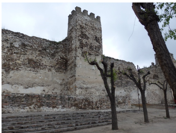
Fig. 5.1.24. Torre T1, con base rectangular [A.S.E. 27/04/2015].
