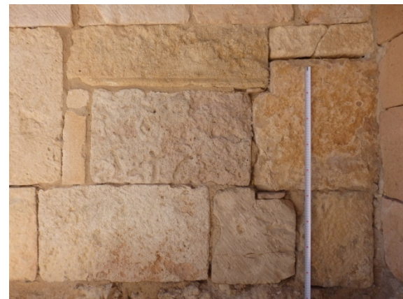
Fig. 5.6.50. Sillería sustituida en base de la puerta de la Fuerza, en el interior del paso de acceso [A.S.E. 23/7/2016].
