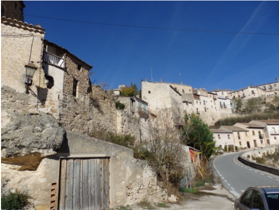
Fig. 5.6.15. Tramo desde la puerta del Río hacia el noreste.
