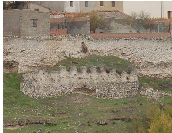
Fig. 6.27. Almenado de proporción cuadrada en la barbacana de la zona sur del recinto de Cuéllar. Fuente: Fotografía facilitada por los arquitectos Fernando Nieto y Jesús Nieto.
