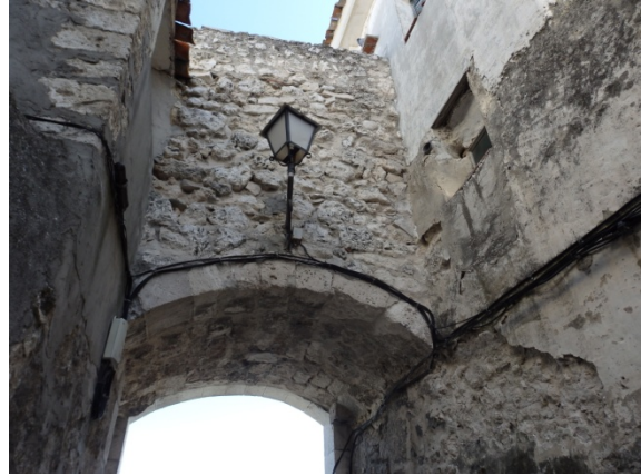
Fig. 5.2.28. Bóveda de la puerta de la Judería P2 vista desde el interior [A.S.E. 20/8/2014].
