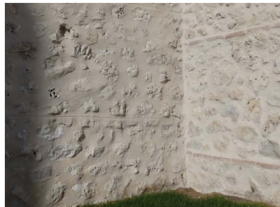
Fig. 5.2.18. Encuentro de las tapias de la torre T1b y el lienzo T1b-T2. Se observa que no hay una continuidad entre las fábricas [A.S.E. 20/8/2014].
