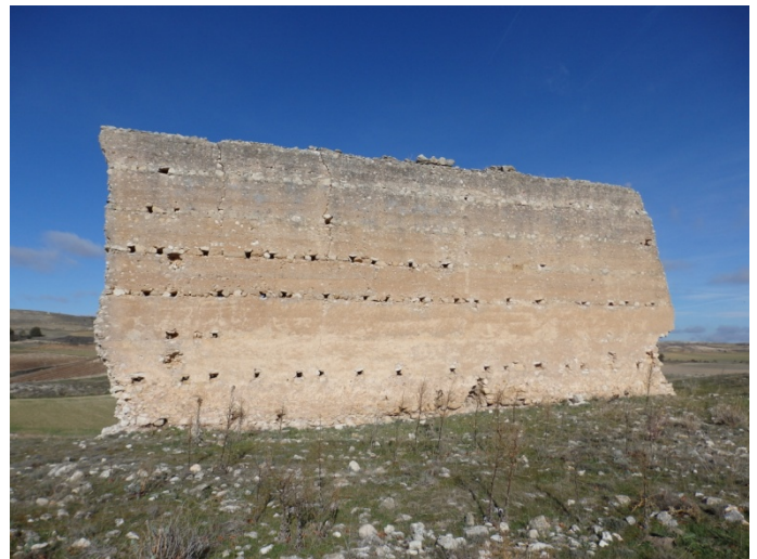
Muro de posible casa fuerte
