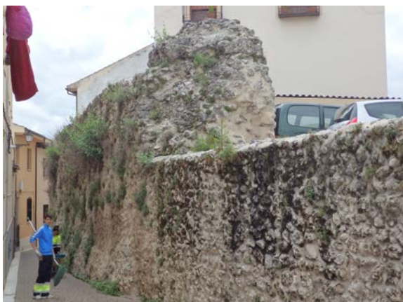
Fig. 5.2.73. Tramo de muralla visible en la calle Herreros [A.S.E. 12/5/2016].
