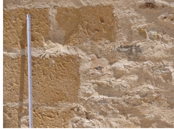
Fig. 5.5.44. Sillería en el alzado interior del postigo de Hontanillas [A.S.E 24/7/2016].
