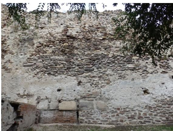
Fig. 5.1.28. Hilada de grandes piedras de granito y arenisca en la base del lienzo T1-T2, en su cara sur [A.S.E. 11/02/2014].
