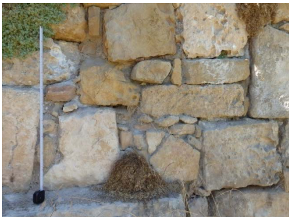
Fig. 5.6.60. Sillería-sillarejo de aparejo desordenado T1-T2. Aparejo B de Martín Aymerich et al. (1990, 131) [A.S.E. 23/7/2016]
