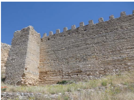
Fig. 5.3.48. Torre T8 vista desde el sur y parte del lienzo [A.S.E. 17/6/2014].
