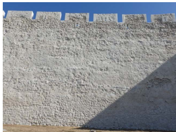
Fig. 5.2.54. Tramo T9-P6 visto desde el exterior del recinto [A.S.E. 20/8/2014].
