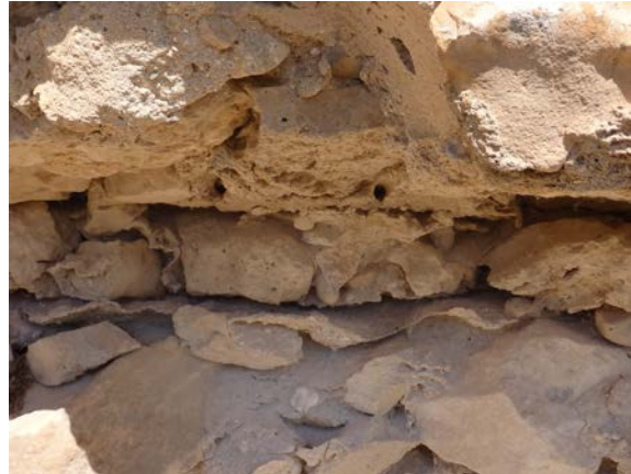
Fig. 5.3.67. Marca del empleo de varillas pareadas de una tapia en el tramo T12-norte [A.S.E. 08/07/2015].
