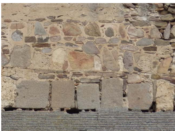
Fig. 5.1.44. Base del tramo T8-noreste, desde el exterior [A.S.E. 27/4/2015].
