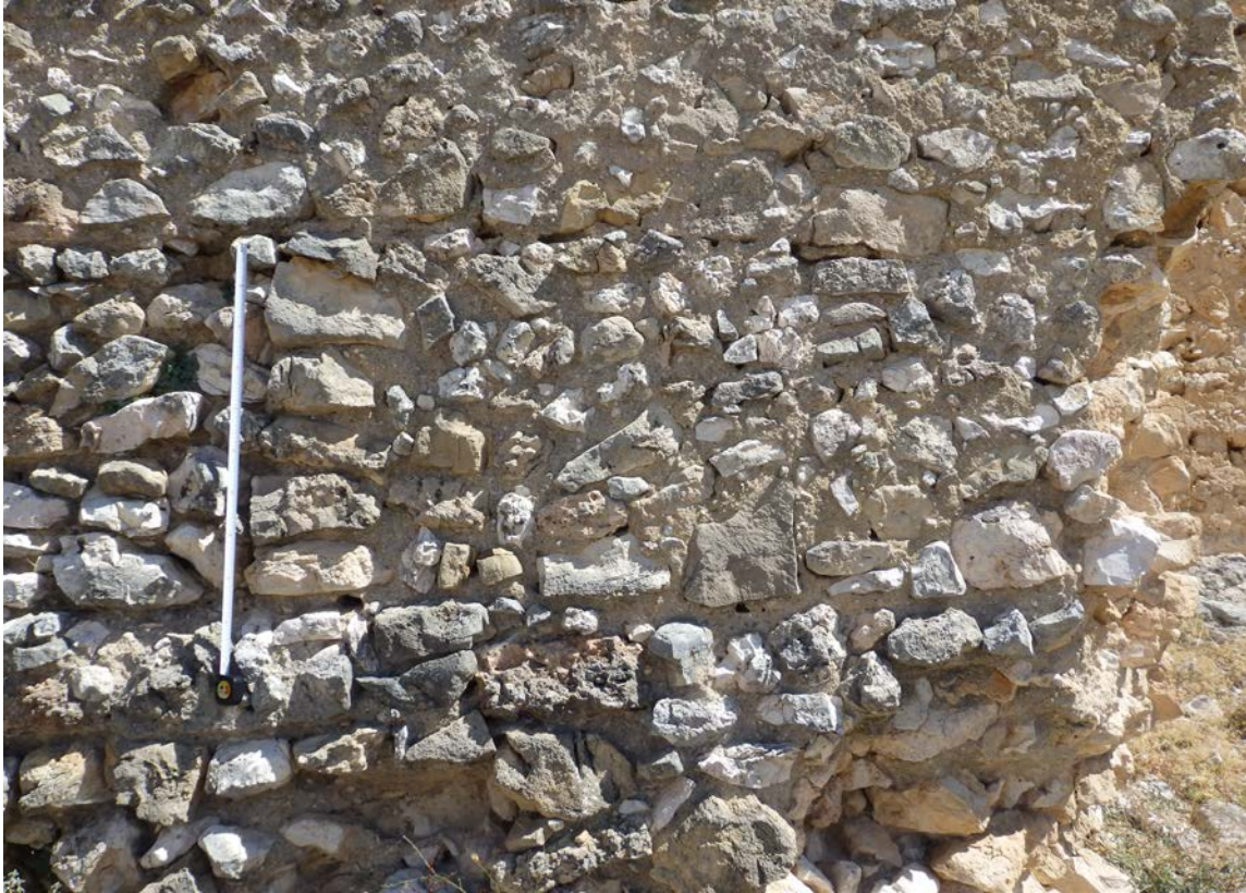
Fig. 5.3.118. Tapia T2.1 de la cara sur de la torre T8. El metro marca la distancia de 1,00m [A.S.E. 23/7/2016].
