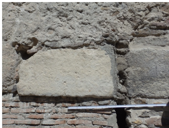
Fig. 5.1.41. Sillares en la base del tramo T1-T2 [A.S.E 13/8/2016]
