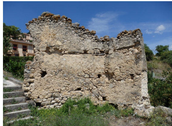
Fig. 5.6.29. Tapias en la zona interior de la torre T1 [A.S.E. 5/7/2014].
