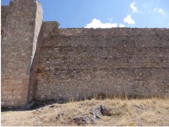
Fig. 5.3.60. Parte del tramo T14-T10 [A.S.E. 13/8/2014].
