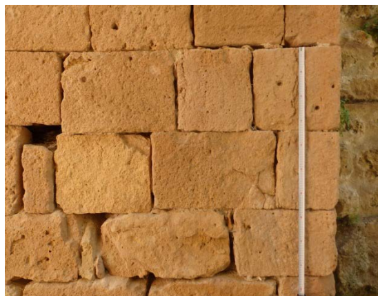
Fig. 5.6.63. Sillería reutilizada en la restauración de la puerta de Duruelo de 1987 [A.S.E. 23/7/2016]
