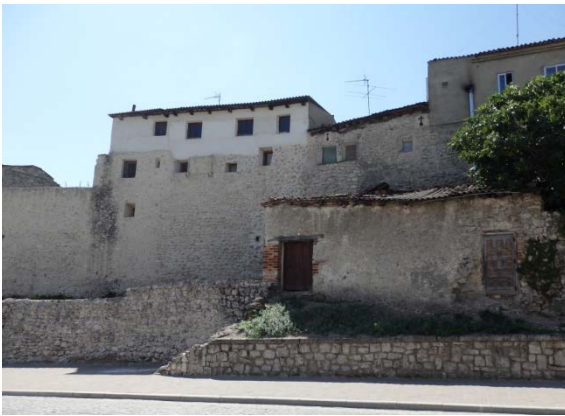
Fig. 5.2.65. Muralla en el interior de las parcelas, en la calle Nueva. Los edificios han utilizado la muralla en su construcción. Dos saeteras son visibles en una de las construcciones [A.S.E. 20/8/2014].
