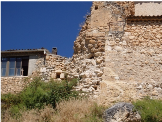
Fig. 5.4.50. Esquina sur del recinto [A.S.E. 23/7/2016].
