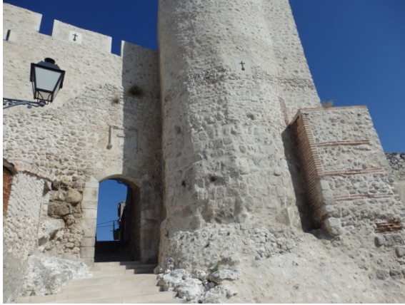
Fig. 5.2.41. Puerta de Santiago (P4) desde el exterior [A.S.E. 20/8/2014].
