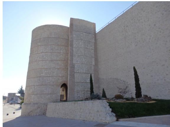
Fig. 5.2.16. Torre de San Basilio vista desde el oeste [A.S.E. 20/8/2014].
