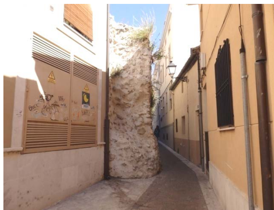
Fig. 5.2.74. Tramo en la calle de la Muralla [A.S.E. 20/8/2014].
