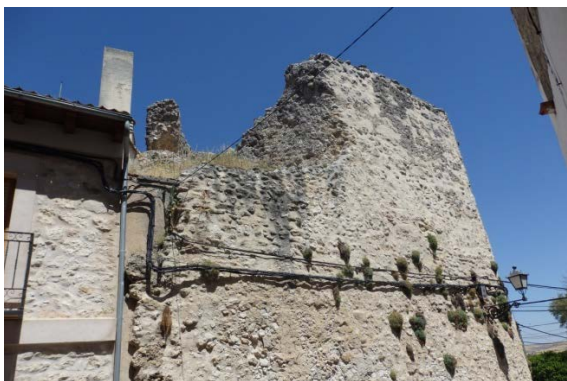
Fig. 5.3.16. Parte superior de la torre T1 desde el interior del recinto [A.S.E. 08/07/2015].
