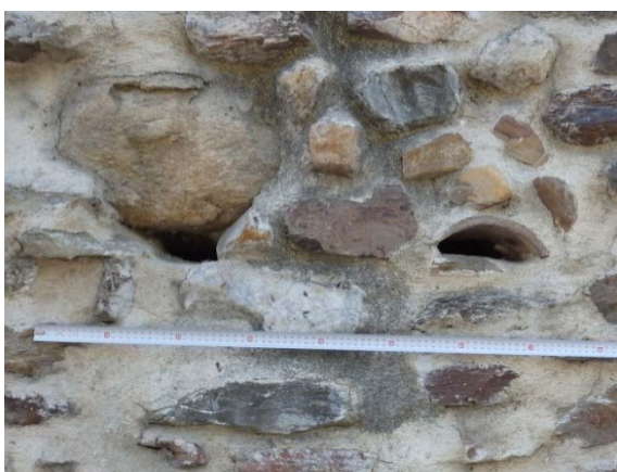
Fig. 5.1.56. Dos mechinales adyacentes de distinta configuración situados bajo la escalera de acceso al adarve [A.S.E. 13/8/2016]
