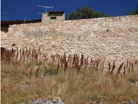
Fig. 5.4.46. Base de muro restaurada que podría tratarse de muralla medieval [A.S.E. 23/7/2016]
