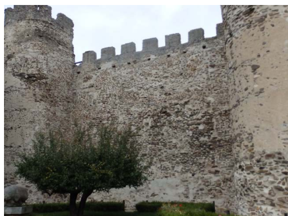
Fig. 5.1.29. Tramo T3-P1 desde el exterior [A.S.E. 11/02/2014].
