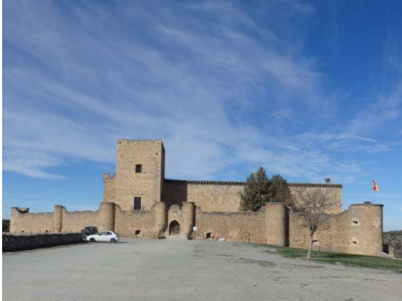
Fig. 5.5.9. Vista sureste del castillo [A.S.E. 18/11/2015].
