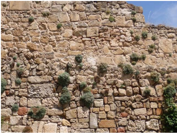
Fig. 5.6.28. Detalle del aparejo irregular en el tramo T1-T2. [A.S.E. 5/7/2014].
