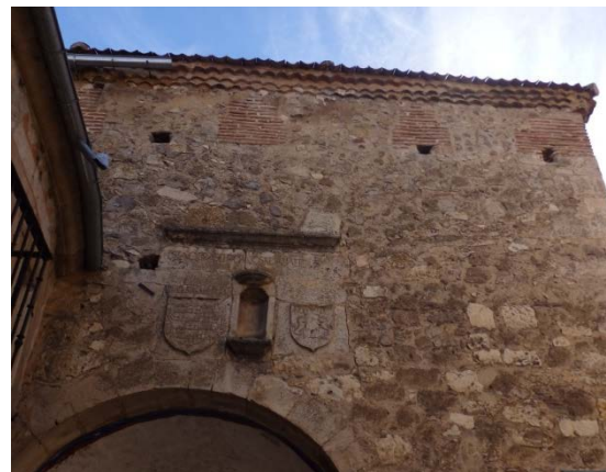
Fig. 5.5.14. Coronación del volumen de acceso de la puerta de la villa [A.S.E. 18/11/2015].
