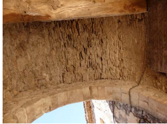
Fig. 5.4.15. Bóveda entre el arco intermedio de la puerta y el arco del alzado interior de la puerta. Arriba se ve la viga que sujeta la puerta en el arco intermedio y abajo se puede ver el arco del alzado interior [A.S.E. 3/9/2014].
