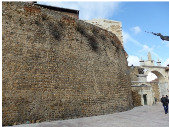
Fig. 1.6. Cerca que rodea las torres de León [A.S.E. 22/02/2014]
