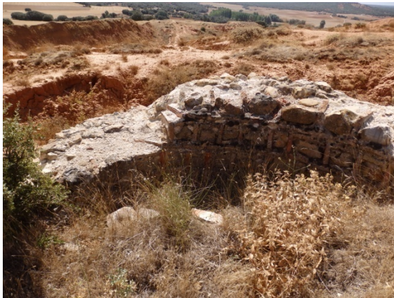
Fig. 6.30. Mampostería encintada en la cara interior del muro semicircular en Fresno de Cantespino [A.S.E 3/9/2014].
