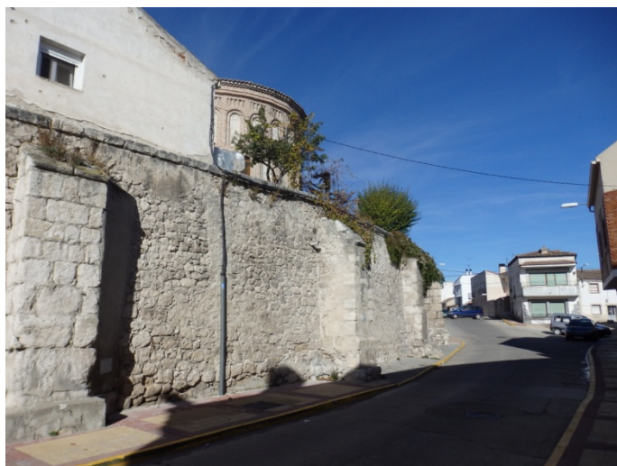
Muro con contrafuertes de la iglesia de Santa María
