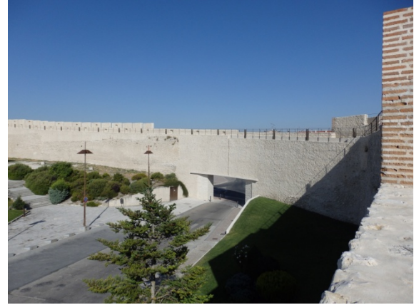
Fig. 5.2.8. Tramo junto al castillo visto desde el interior del recinto [A.S.E. 20/8/2014].
