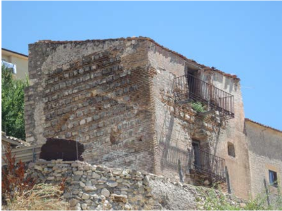
Fig. 5.6.41. Construcción al norte de la puerta de Duruelo [A.S.E. 23/7/2016].
