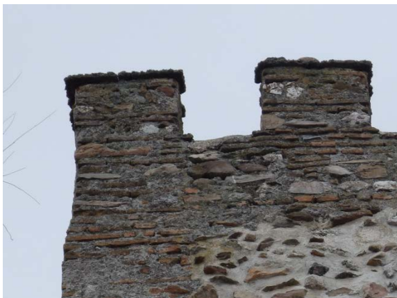
Fig. 5.1.81. Almenas de la torre T1, en la fachada oeste [A.S.E. 27/4/2015].
