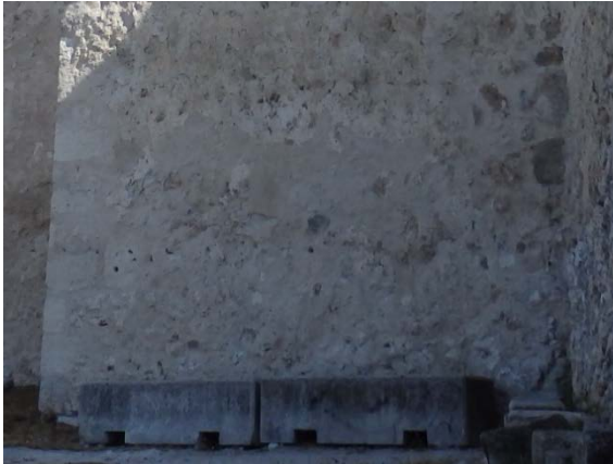
Fig. 5.2.51. Base de la torre T9 [A.S.E. 20/8/2014].
