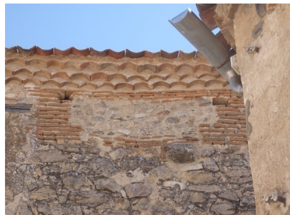
Fig. 5.5.48. Tapia mixta en la coronación del alzado interior de la puerta de la villa [A.S.E 24/7/2016].
