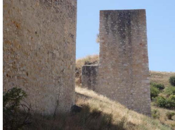
Fig. 5.3.27. Vista norte de la torre T2. En la base se observa cómo se adosa al lienzo [A.S.E. 8/7/2015]
