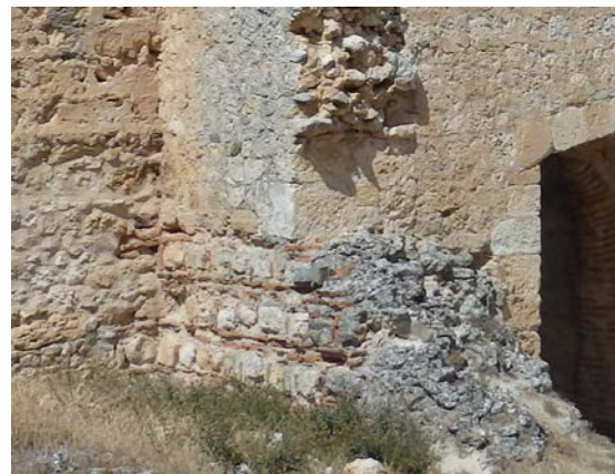
Fig. 5.3.59. Detalle de la base de la torre T14, vista desde el interior [A.S.E. 13/8/2014].
