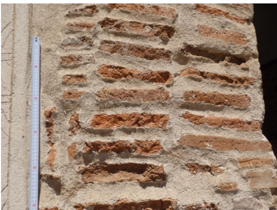
Fig. 5.5.47. Ladrillo en la cara exterior del arco de la Villa [A.S.E 24/7/2016].
