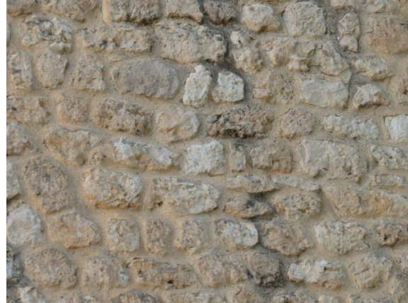
Fig. 5.4.57. Sillarejo en tramo P1-T1 [A.S.E. 23/7/2016].
