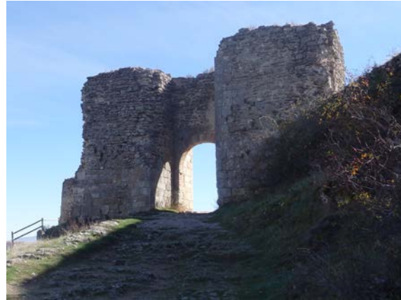
Fig. 6.5. Puerta de la Fuerza en Sepúlveda, de composición simétrica [A.S.E. 11/11/2015].
