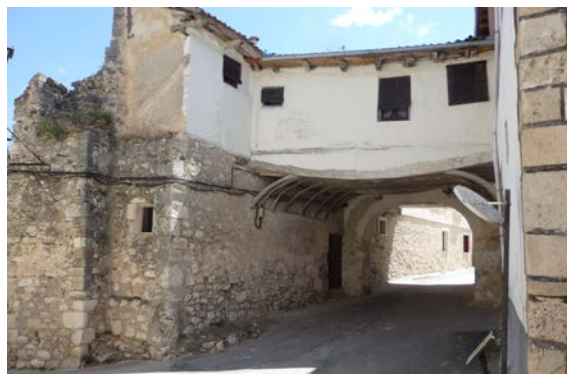
Fig. 5.3.17. Vista de la puerta desde el interior [A.S.E. 17/6/2014].
