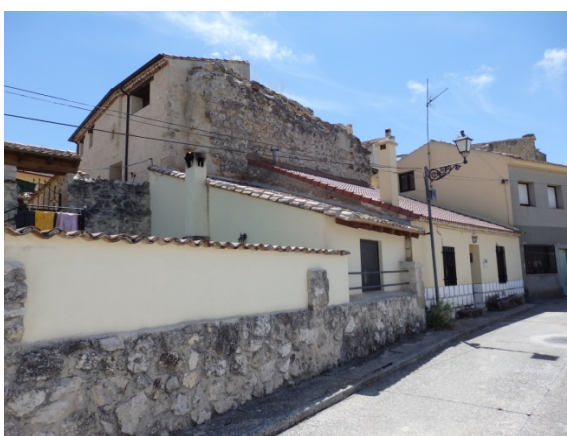
Fig. 5.3.18. Lienzo de muralla en interior de la parcela. A ambos lados se adosan edificaciones (A.S.E. 13/08/2014).
