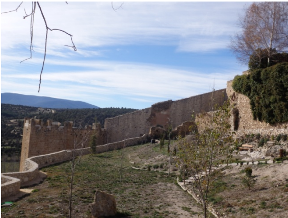
Fig. 5.5.21. Vista norte de la torre de Hontanillas (T4) y el acceso adyacente [A.S.E. 18/11/2015].
