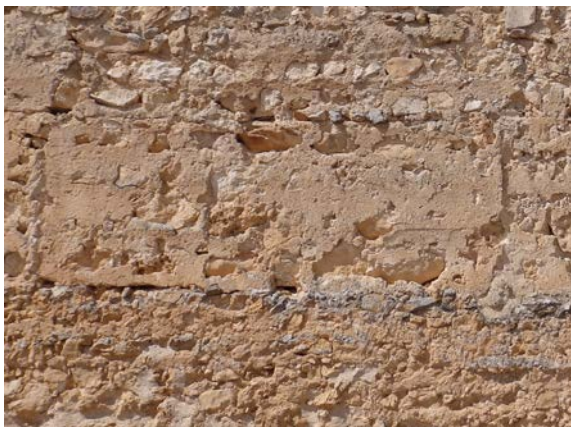
Fig. 5.3.76. Tapia de mampostería de color terroso en la cara interior del tramo T14-T11, con medidas 3,05m x 1,15m [A.S.E. 13/8/2014].
