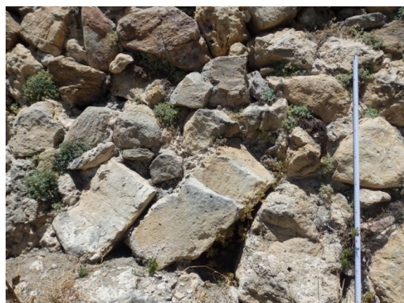
Fig. 5.5.42. Mampostería en tramo P1-T2 [A. S. E. 24/7/2016].
