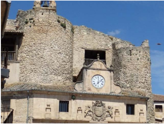
Fig. 5.6.20. Torres T11 y T12 [A.S.E. 5/7/2014].
