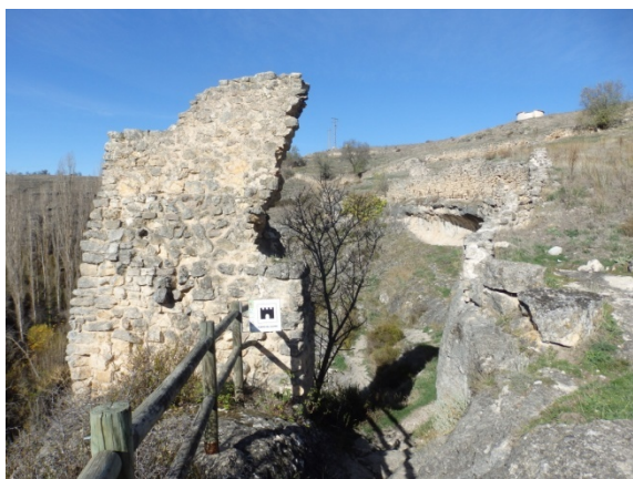
Fig. 5.6.43. Vista de la puerta de Castro desde el interior del recinto. [A.S.E. 11/11/2015].
