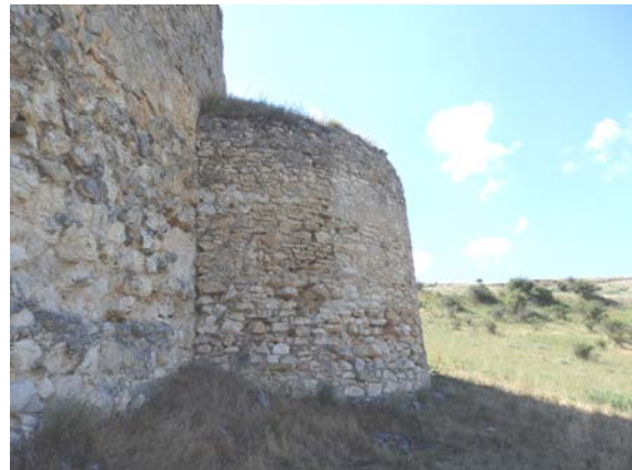
Fig. 5.3.35. Torre T5 [A.S.E. 17/6/2014]
