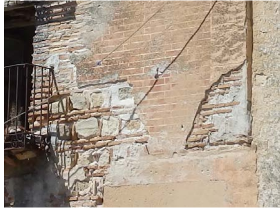
Fig. 5.6.42. Detalle de la técnica constructiva del muro [A.S.E. 23/7/2016].
