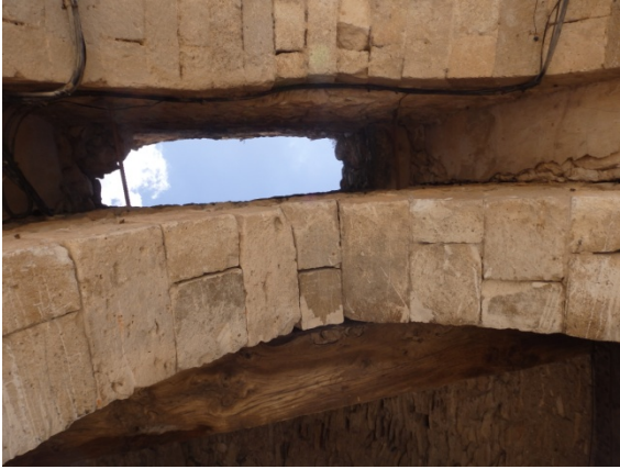
Fig. 5.4.14. Matacán entre el arco del alzado exterior y el arco intermedio. Arriba se ve el arco exterior y abajo el arco intermedio [A.S.E. 3/9/2014].
