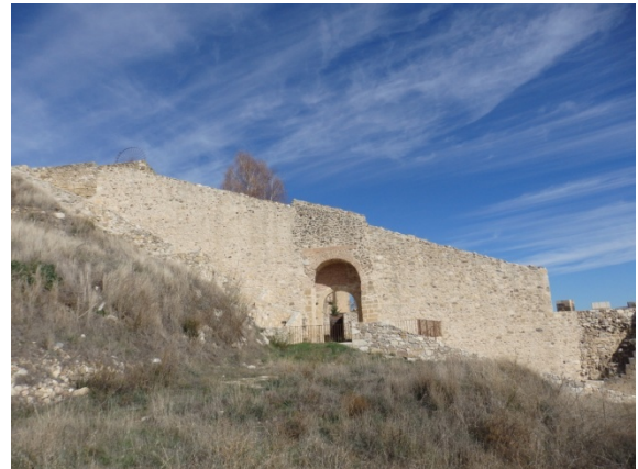
Fig. 5.5.22. Vista sur del tramo de Hontanillas. Los tramos a ambos lados del postigo fueron reconstruidos. [A.S.E. 18/11/2015].
