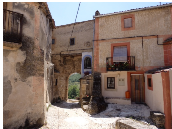
Fig. 5.6.12. Vista interior de la Puerta del Río [A.S.E. 5/7/2014].
