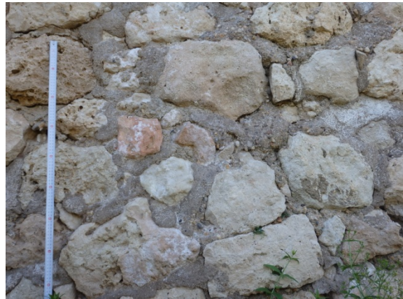
Fig. 5.4.59. Mampostería en zona reparada [A.S.E. 23/7/2016].
