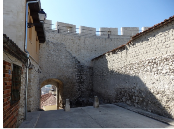
Fig. 5.2.42. Puerta de Santiago (P4) desde el interior [A.S.E. 20/8/2014].
