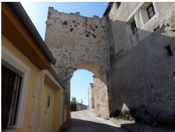
Fig. 5.3.70. Puerta de la Calzada P2 [A.S.E. 08/07/2015].
