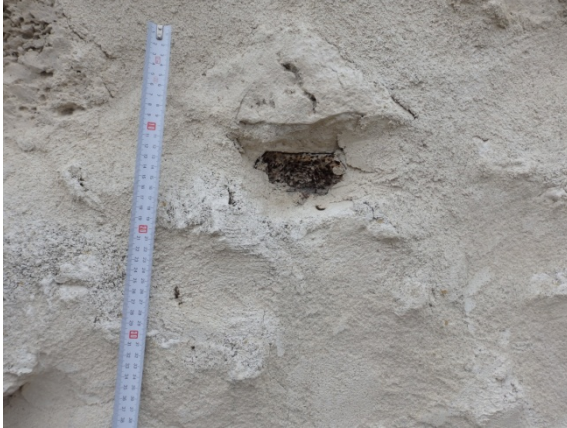
Fig. 5.2.112. Mechinal M1 que conserva la aguja de madera en su interior, situado en tramo P6-T9, visible desde la zona interior [A.S.E. 12/5/2016].
