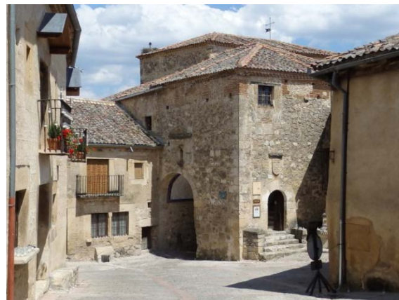
Fig. 5.5.12. Puerta de la villa vista desde el interior del recinto. A la izquierda se ve el hueco de acceso. A la derecha se encuentra la puerta de acceso al interior del edificio [A.S.E. 5/7/2014].
