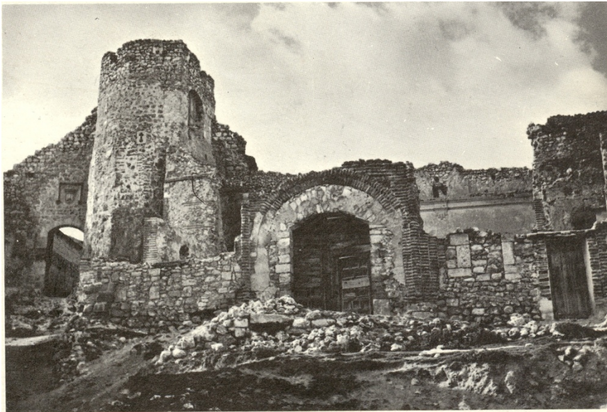
Fig. 6.37. Fotografía antigua de la iglesia de Santiago, en Cuéllar. Fuente: Imagen facilitada por Fernando Nieto y Jesús Nieto.
