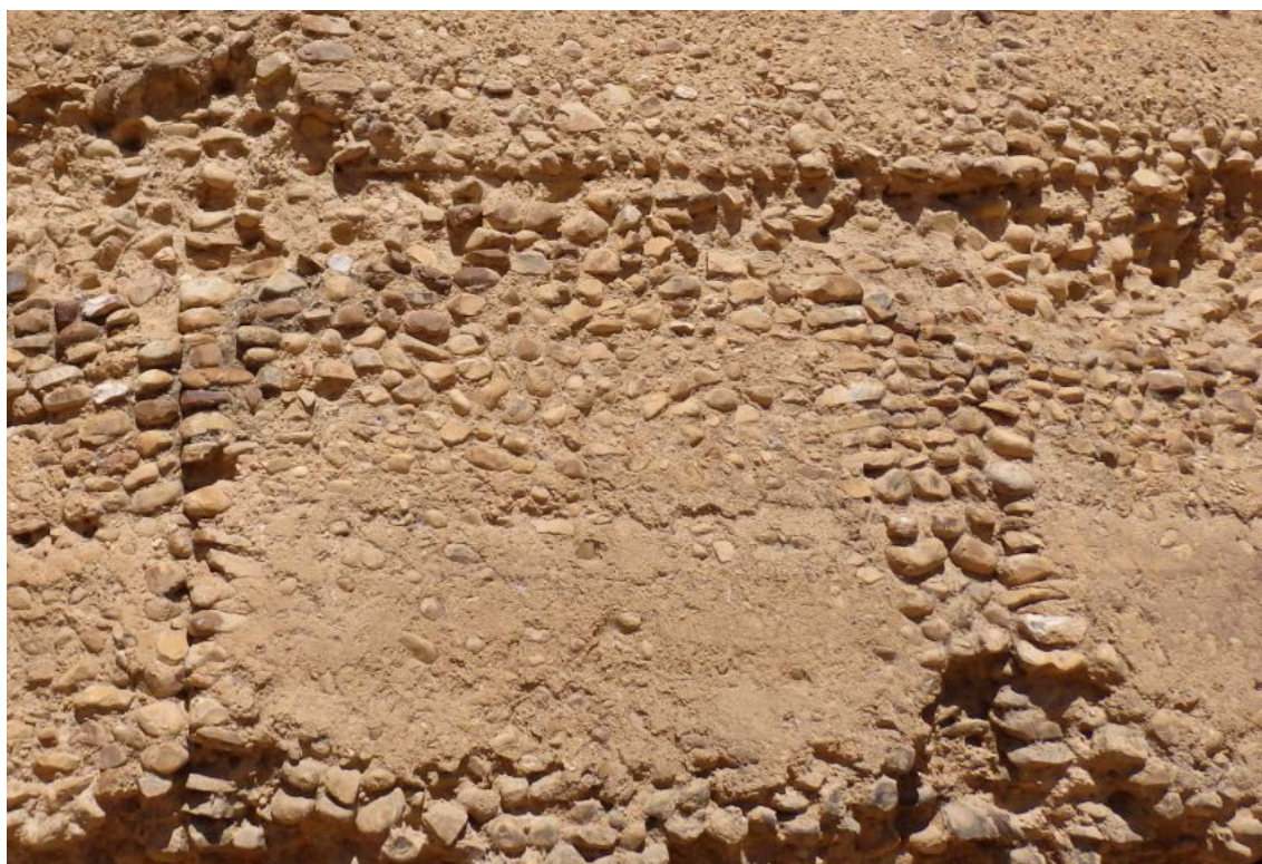
Fig. 5.1.53. Bloques de la muralla de San Pedro de Latarce, Valladolid. Se puede apreciar la colocación de las piedras formando un murete en el lateral de la tapia [A.S.E 29/06/2014].
