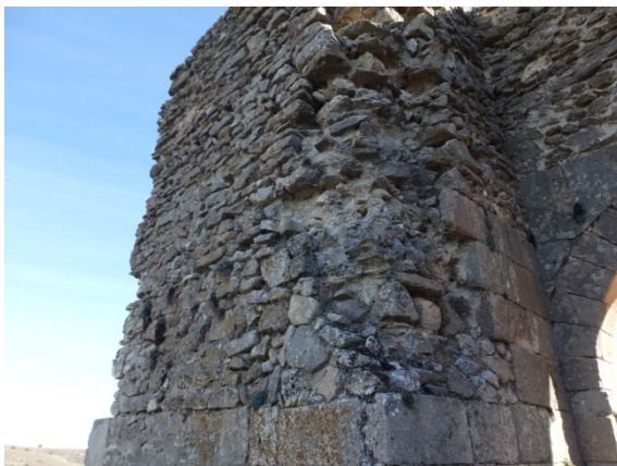
Fig. 5.6.49. Mampostería encofrada de la torre T23. [A.S.E. 11/11/2015].
