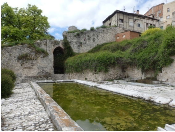
Fig. 5.2.77. Tramo en la zona de Exángel. Se observa al fondo el portillo de Exángel [A.S.E. 12/5/2016].
