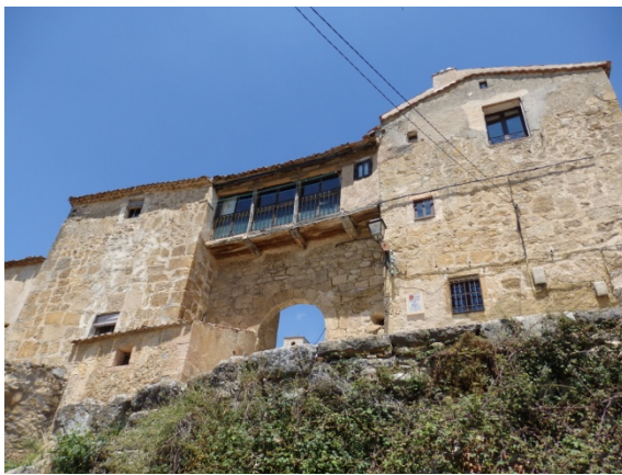
Fig. 5.6.11. Vista de la Puerta del Río, torres T18 (izq.) y T19 (dcha.) [A.S.E. 5/7/2014].
