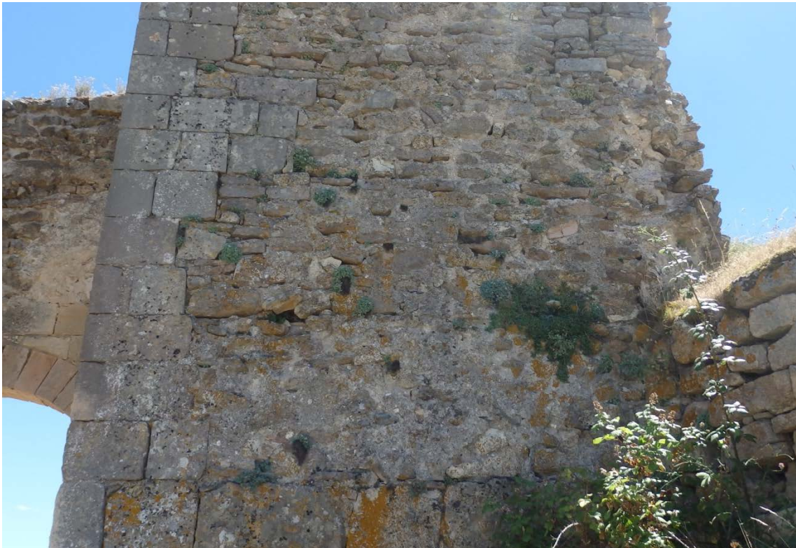
Fig. 5.6.74. Frente exterior de la torre T22. Se observan tapias sobre la base de sillares [A.S.E 23/7/2016].
