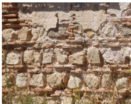
Fig. 5.6.65. Mampostería encintada con ladrillo en una construcción cercana a P11 en el interior del recinto amurallado [A.S.E. 23/7/2016].
