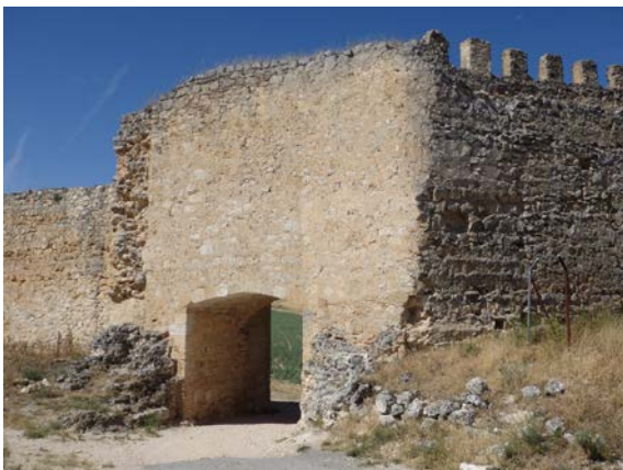
Fig. 5.3.58. Vista interior de la puerta de Alfonso VIII (P3) [A.S.E. 8/7/2015].
