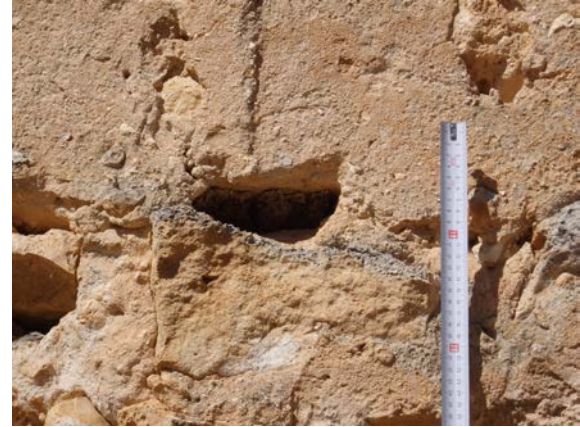
Fig. 5.3.111. Mechinal situado entre T4.4 y T4.5. Sobre el mechinal se observa la línea vertical de límite entre tapias [A.S.E. 23/7/2016]
