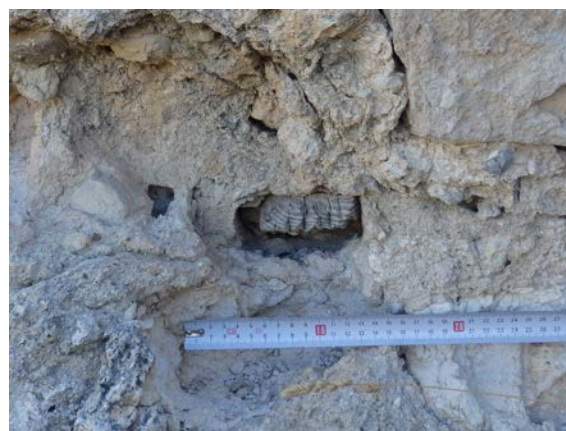
Fig. 5.3.101. Mechinal 2.5 del tramo D2 en T5-T6 [A.S.E. 23/7/2016].
